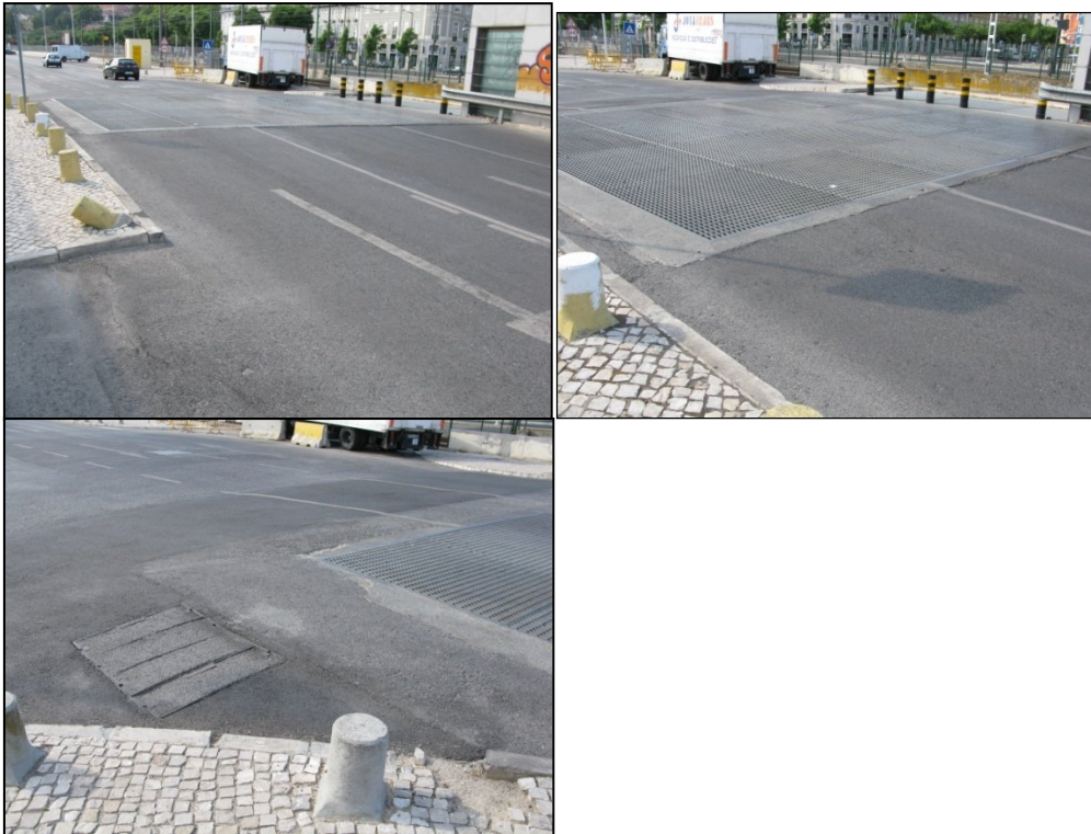
Figura 2.4.9 - Vista geral do poço de ventilação do metro de Lisboa
