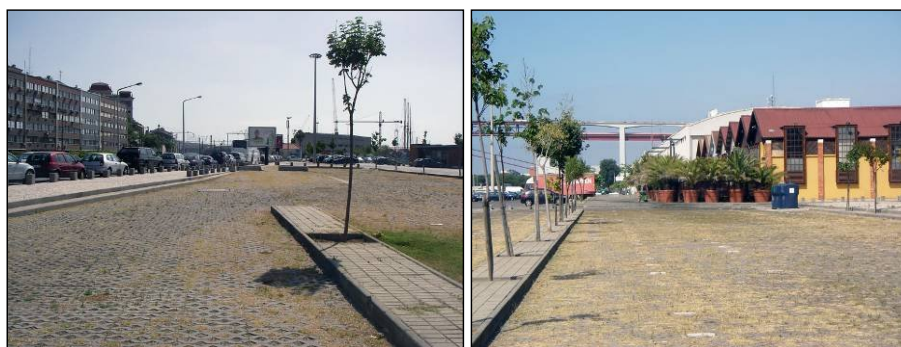
Figura 2.4.25 – Vista geral da zona em que o interceptor é desviado para o parque de estacionamento (à esquerda) e do local proposto para a implantação da estação elevatória (à direita).
