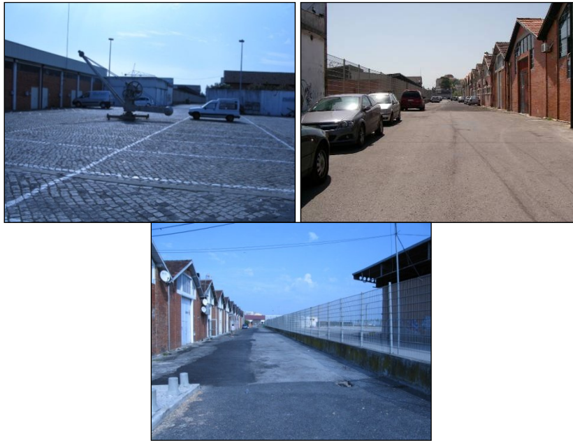
Figura 2.4.15 – Vista geral do local de inflexão do interceptor (à esquerda e centro) e do local proposto para a implantação da Estação Elevatória da Rocha de Conde de Óbitos (à direita).
