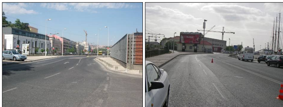
Figura 2.4.23 – Vista geral sobre o local do cruzamento 10 (à esquerda) e do cruzamento 11 (à direita).
