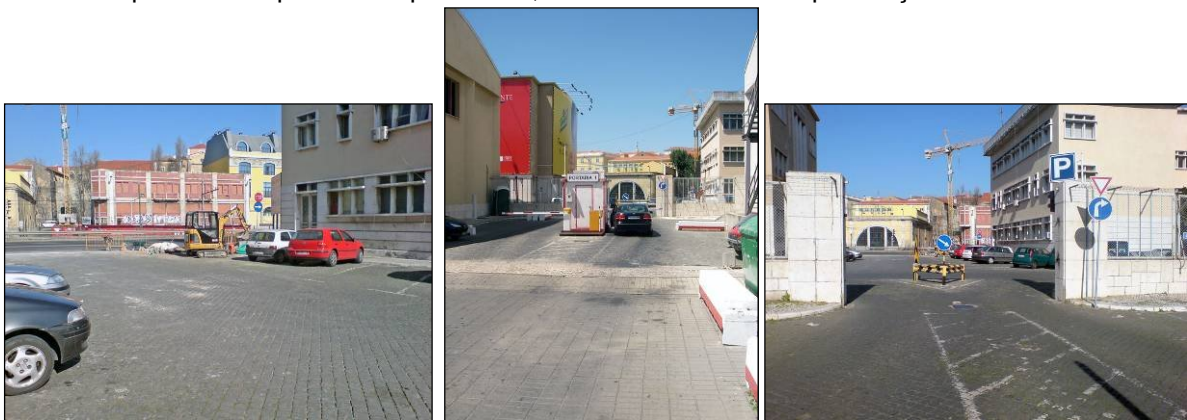
Figura 2.4.27 – Vista geral dos locais dos cruzamentos e da rua em que o interceptor deriva para norte (à esquerda e ao centro) e local do poço de arranque da perfuração horizontal (à direita).
