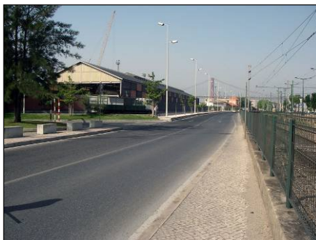
Figura 2.4.19 – Vista geral da Rua da Cintura do Porto de Lisboa, no local dos cruzamentos com a rede de drenagem da APL.
