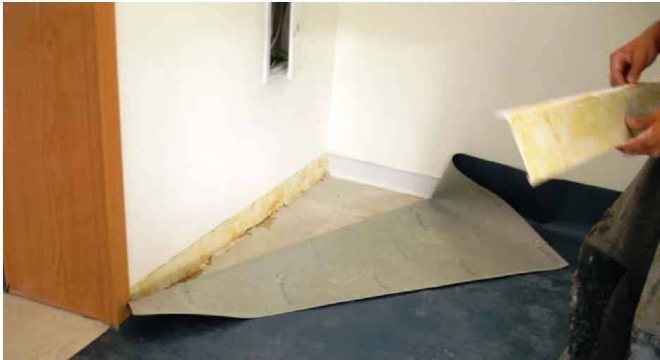
Fig. 56 - Aplicação de cola em ambos os elementos
