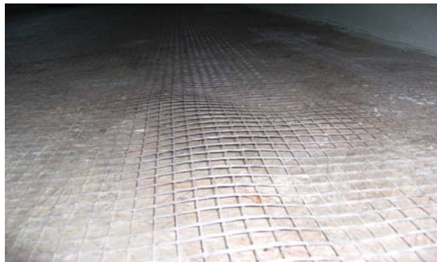
Fig. 31 - Aplicação de rede de fibra de vidro
