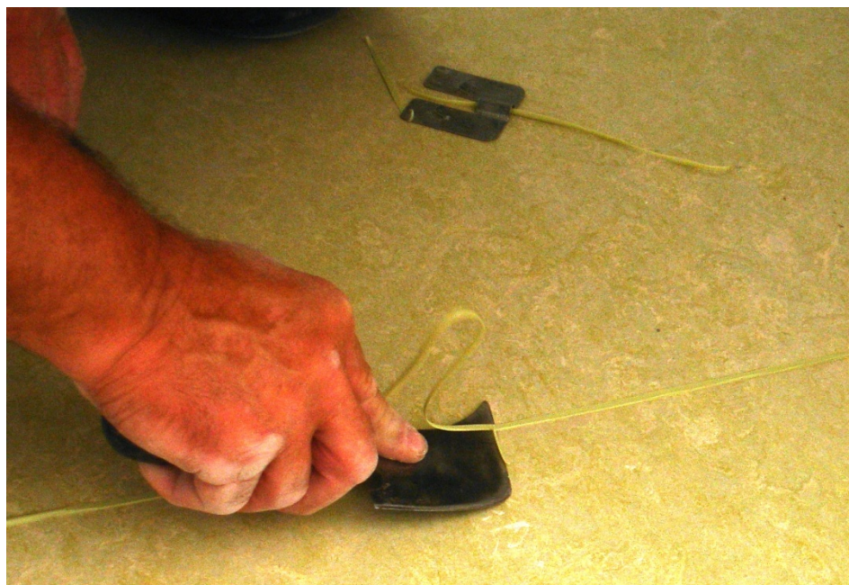
Fig. 45 – Execução do segundo corte do cordão de soldadura
