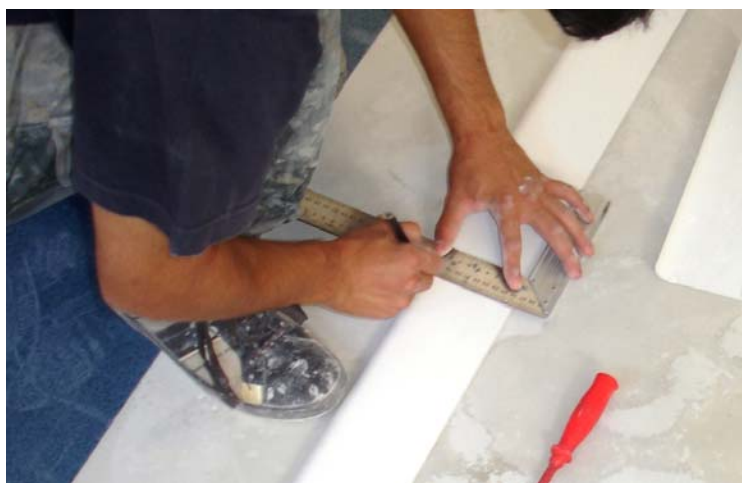
Fig. 55 - Marcação do rodapé para posterior corte
