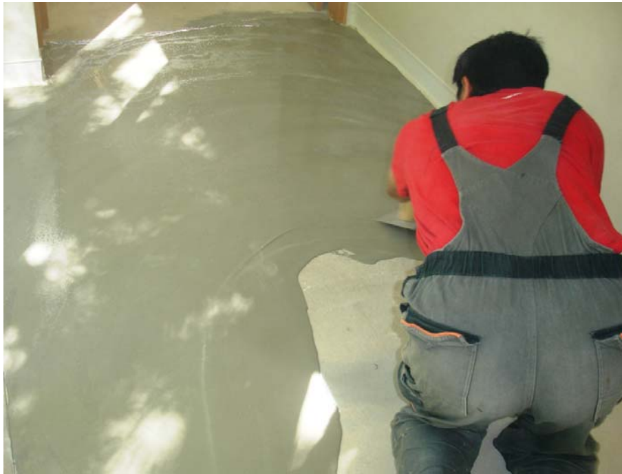
Fig. 23 – Aplicação de massa de barramento / regularização auto-nivelante
