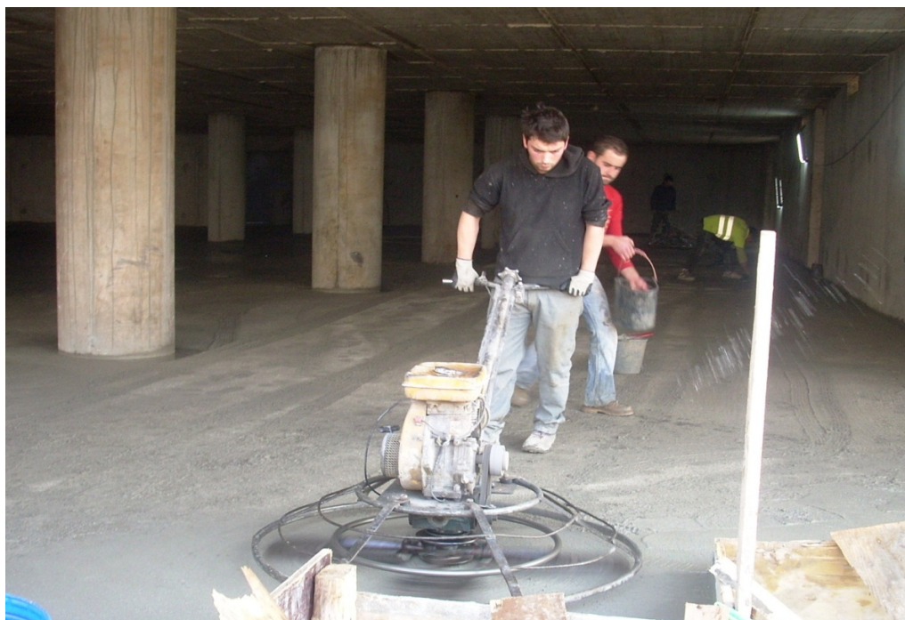
Fig. 18 - Regularização da camada de betão com talocha mecânica
