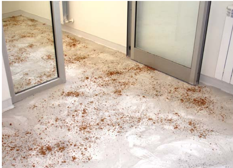
Fig. 25 – Limpeza com serradura humedecida da poeira provocada pela regularização com discos abrasivos
