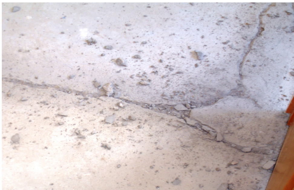
Fig. 19 – Alegramento de fissuras
