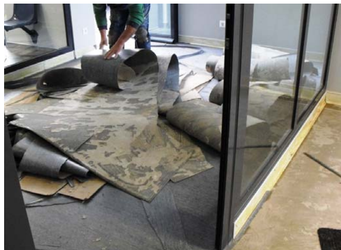
Fig. 70 - Aspecto do material vinílico após a sua remoção
