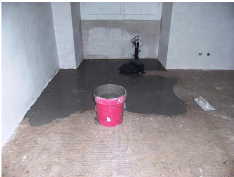
Fig. 32 - Aplicação de camada final de barramento
