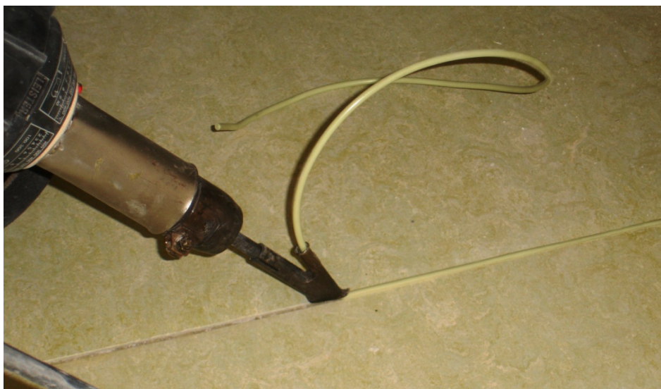
Fig. 43 - Aplicação de cordão de soldar com pistola de ar quente
