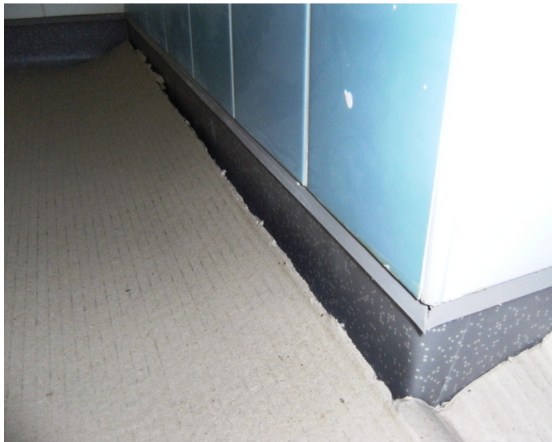
Fig. 39 – Exemplo de protecção ao revestimento vinílico com cartão canelado
