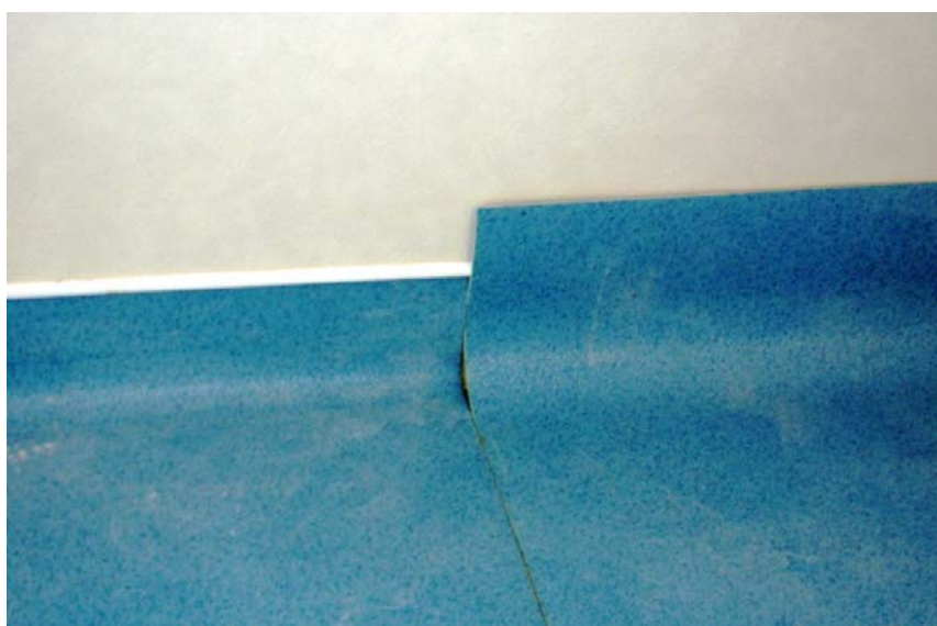
Fig. 57 - Comparação entre rodapé acabado e por acabar
