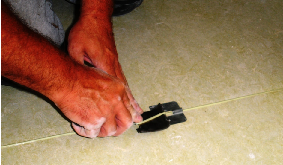
Fig. 44 - Redução do cordão de soldadura
