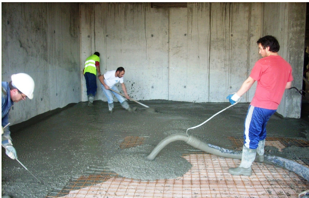
Fig. 17 - Aplicação de betão em pavimento térreo
