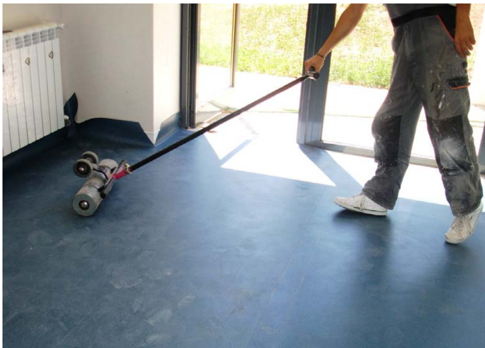
Fig. 35 - Aplicação de rolo metálico
