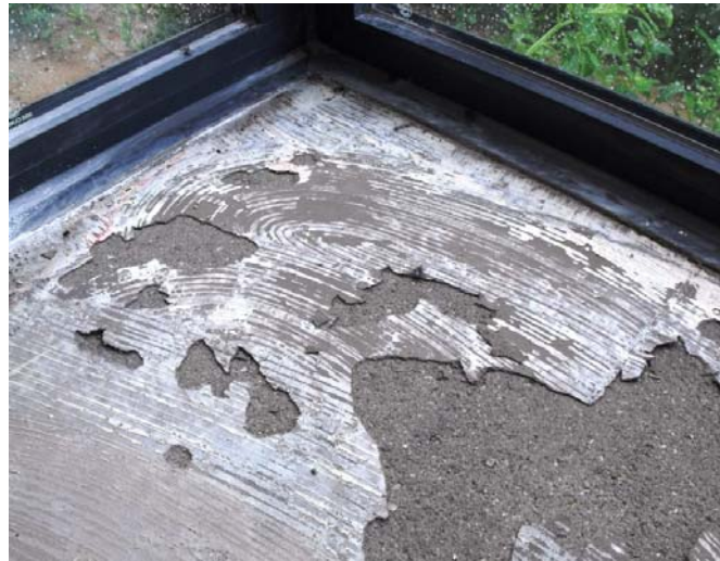
Fig. 69 - Aspecto do suporte após remoção do revestimento vinílico
