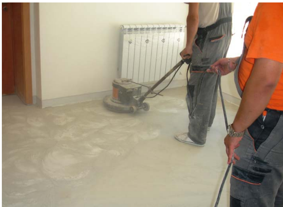
Fig. 24 – Alisamento da camada de regularização por desgaste com discos abrasivos
