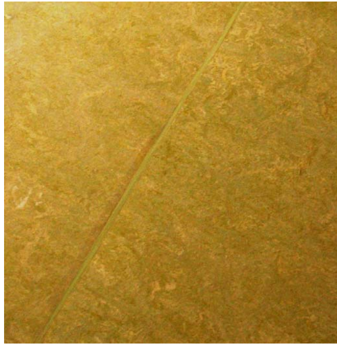
Fig. 46 - Aspecto final de uma soldadura a quente
