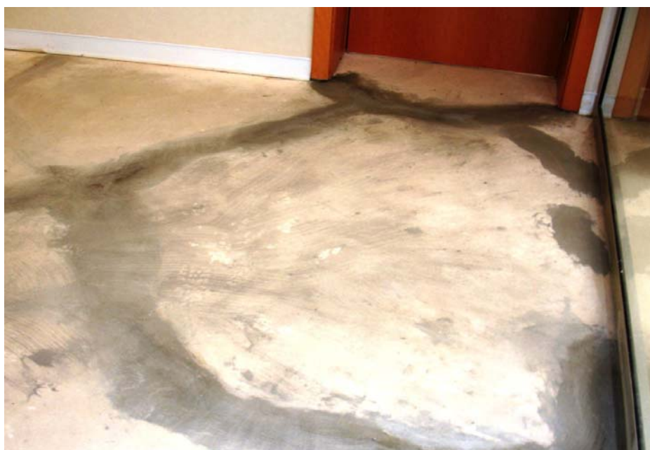
Fig. 20 – Reparação de fissuração com argamassa não retráctil
