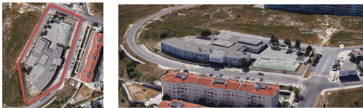
Figura 4.1 - Delimitação da área de implantação da escola de São Bartolomeu Dias (fonte: Google Earth, 2016)
