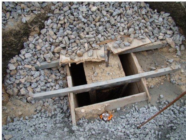
Figura 70 – Exemplo de colocação e travamento do negativo, com recurso a um cangalho.
