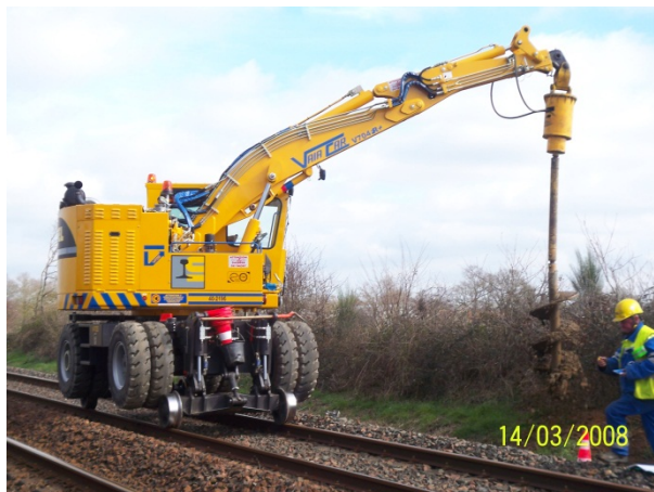
Figura 69 – Equipamento rail-route com trado acoplado para escavação dos maciços.
