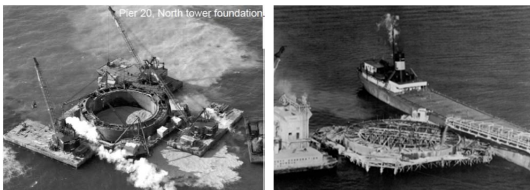
Figuras 14 e 15 – Execução de pilares da ponte de Mackinac, Michigan, com betão com pré-colocação de agregados em ambiente submerso (Fonte: ACI 304.1 R-92, 1997).
