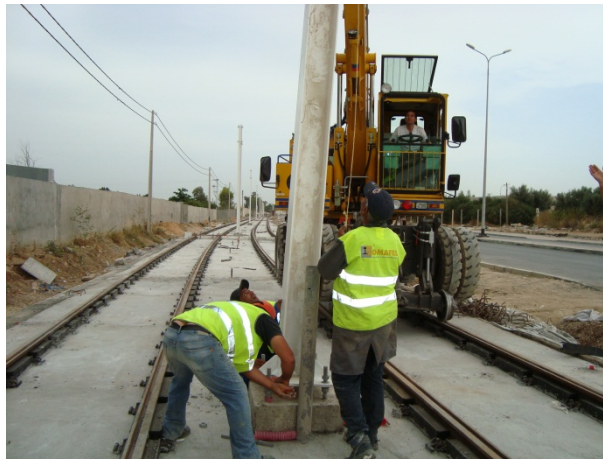
Figura 74 – Colocação de poste de catenária em maciço de fundação com recurso a rail-route com grua.
