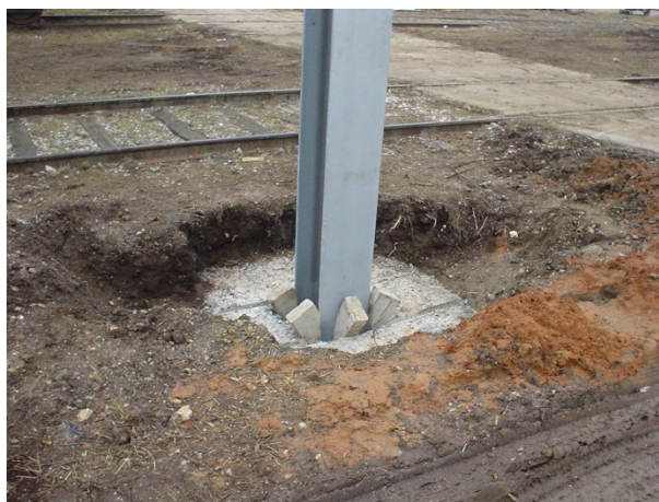
Figura 75 – Fixação temporária de poste de catenária, recorrendo a cunhas de madeira.
