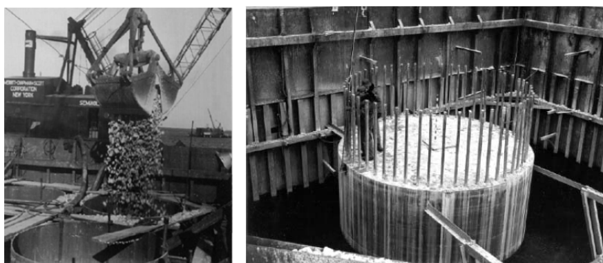
Figuras 6 e 7 – Execução de pilares da ponte de Mackinac, Michigan (Fonte: ACI 304.1 R-92, 1997).
