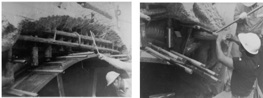
Figuras 16 e 17 – Execução de estrutura de contenção nuclear com acesso condicionado e profusão de armaduras recorrendo a betão com pré-colocação de agregados (Fonte: ACI 304.1 R-92, 1997).
