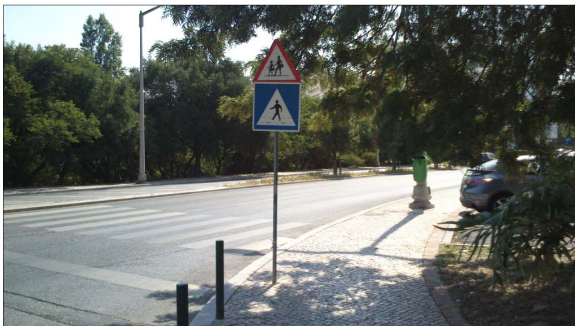
Figura 4.46 – Exemplo de sinalização vertical de perigo obsoleta.
