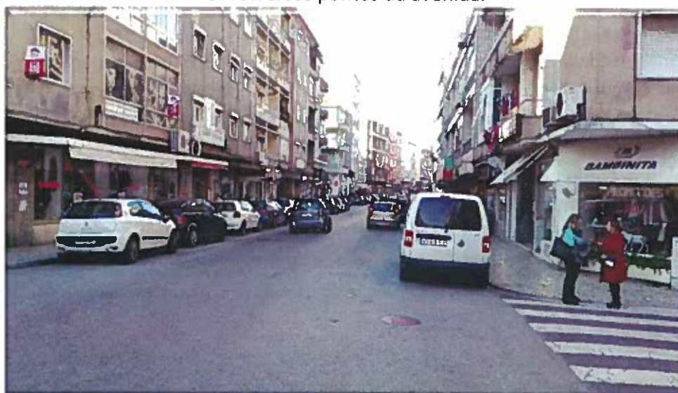
Figura 8 - Zona-piloto antes da intervenção
