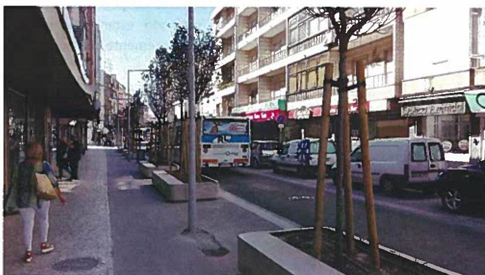
Figura 9 - Zona-piloto após a intervenção
