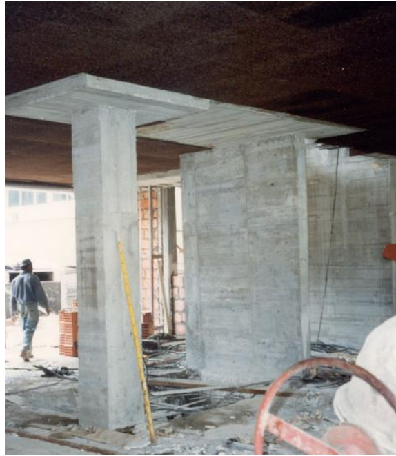
Figura 42 – Pilares reforçados por encamisamento. (a2p.pt)
