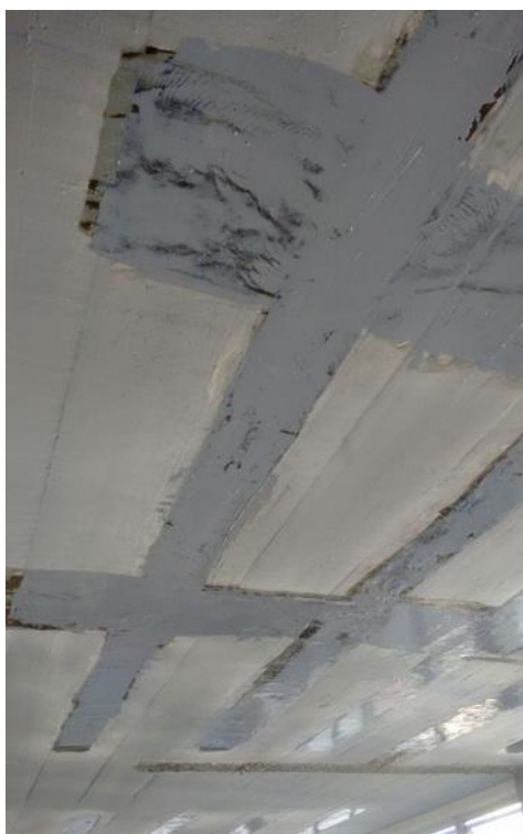
Figura 6 – Superfícies regularizadas com argamassa epoxídica.( tecknicas.com.br)
