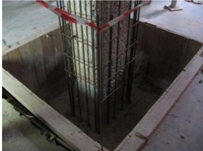
Figura 49 – Execução do reforço por encamisamento dos pilares nas zonas enterradas. (htecnic.pt)
