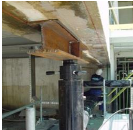
Figura 13 – Alívio da sobrecarga por auxílio de macaco hidráulico. (stb.pt)
