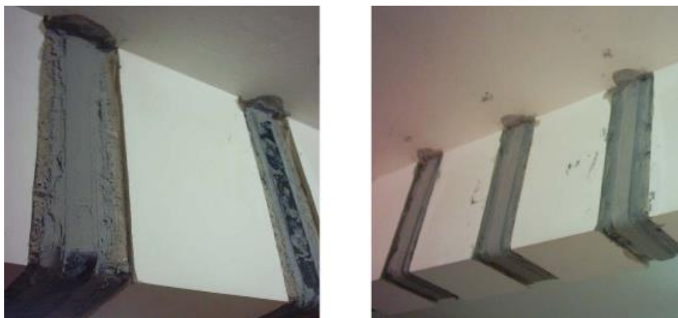
Figura 16 – Aplicação da resina epóxi nos sobre os laminados. (stb.pt)
