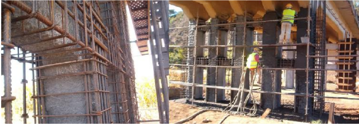
Figura 45 – Reforço dos pilares. (htecnic.pt)
