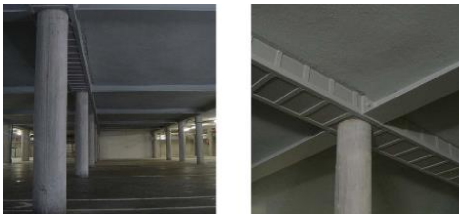
Figura 34 – Resultado final da laje após regularização e pintura e ligação entre perfil metálico HEB300 e viga reforçada. (stb.pt)
