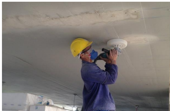
Figura 4 – Preparação da superfície com lixadeira elétrica com disco diamantado aplicado. (tecknicas.com.br)
