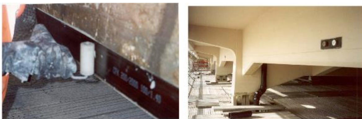
Figura 9 – Reforço das vigas e controlo de qualidade, (Costa A, et al 2004).
