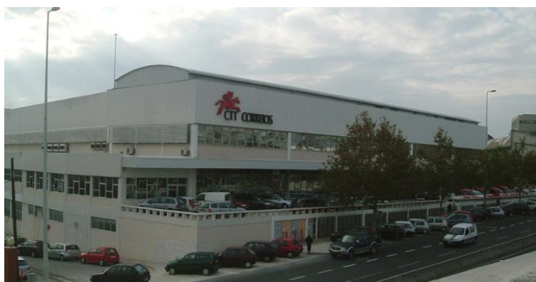
Figura 35 – Central dos CTT de Cabo Ruivo, Lisboa. (a2p.pt)
