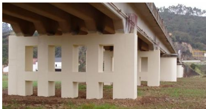
Figura 47 – Pintura nas zonas reparadas. (htecnic.pt)
