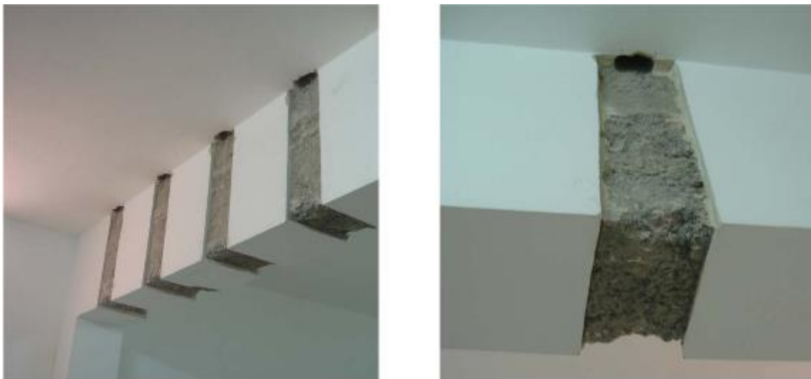
Figura 14 – Tratamento da superfície e boleamento das arestas. (stb.pt)
