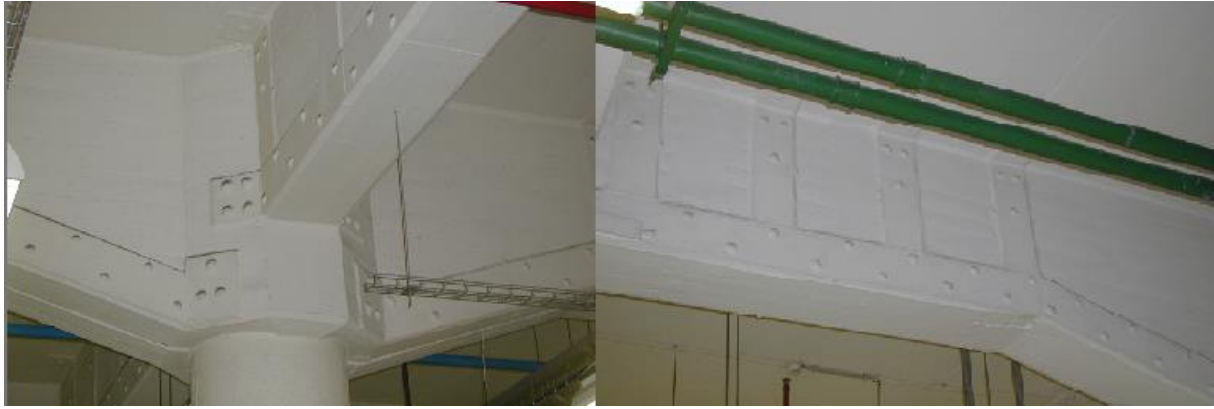
Figura 36 – Reforço das vigas com chapas metálicas. (a2p.pt)
