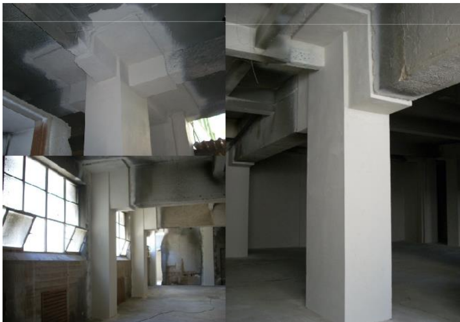
Figura 50 – Regularização das superfícies reparadas e pintura final. (htecnic.pt)
