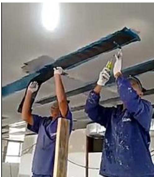
Figura 5 – Aplicação da manta de carbono. (tecknicas.com.br)
