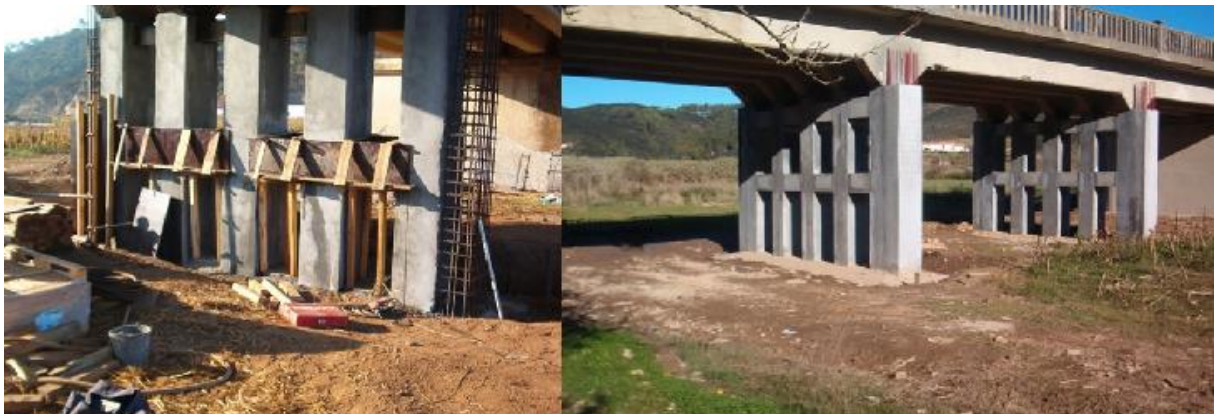
Figura 46 – Execução de novos pilares. (htecnic.pt)
