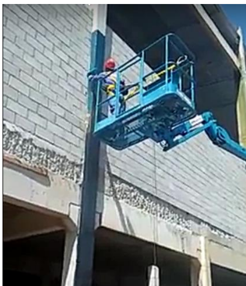
Figura 8 – Preparação da superfície para aplicação do reforço. (tecknicas.com.br)
