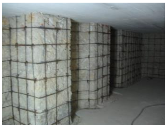
Figura 48 – Reforço dos pilares por encamisamento. (htecnic.pt)
