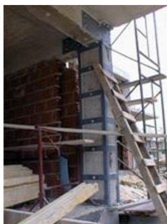
Figura 30 – Reforço de um pilar das moradias. (trimetrica.com.pt)
