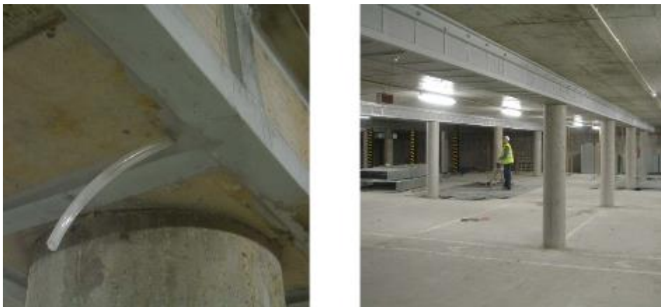
Figura 33 – Reforço exterior das vigas. (stb.pt)
