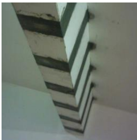
Figura 17 – Regularização da superfície com argamassa hidráulica. (stb.pt)
