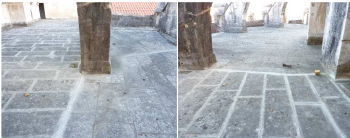
Figura 58 – Terraço dos arcobotantes.
