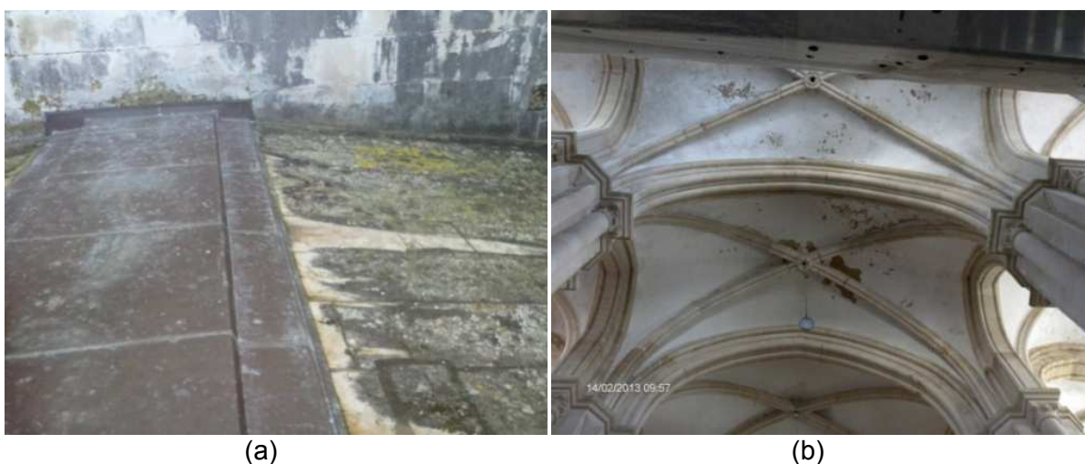
Figura 59 – Cobertura entre as torres sineiras (a) no exterior (b) no tecto no interior da Igreja subjacente ao pavimento.
