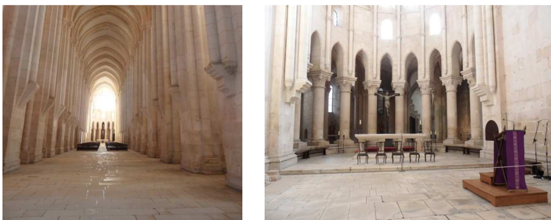
Figura 18 – Igreja depois da intervenção.
