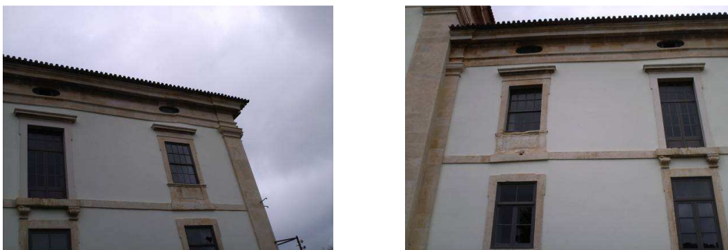
Figura 68 – Claustro do Rachadouro – Biblioteca – Lado Poente exterior.
