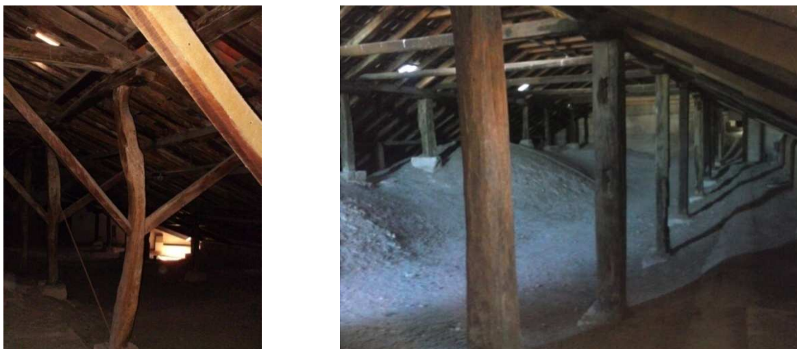
Figura 42 – Estrutura de madeira de suporte ao telhado da Igreja.
