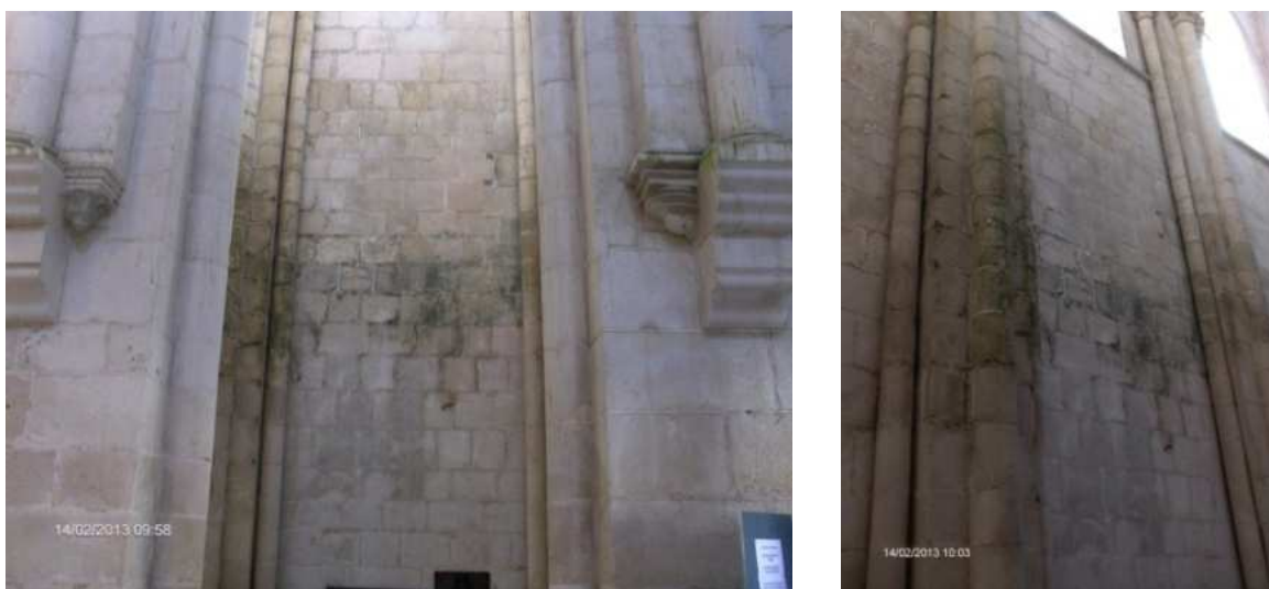
Figura 63 – Paramentos interiores da Igreja do lado Sul.
