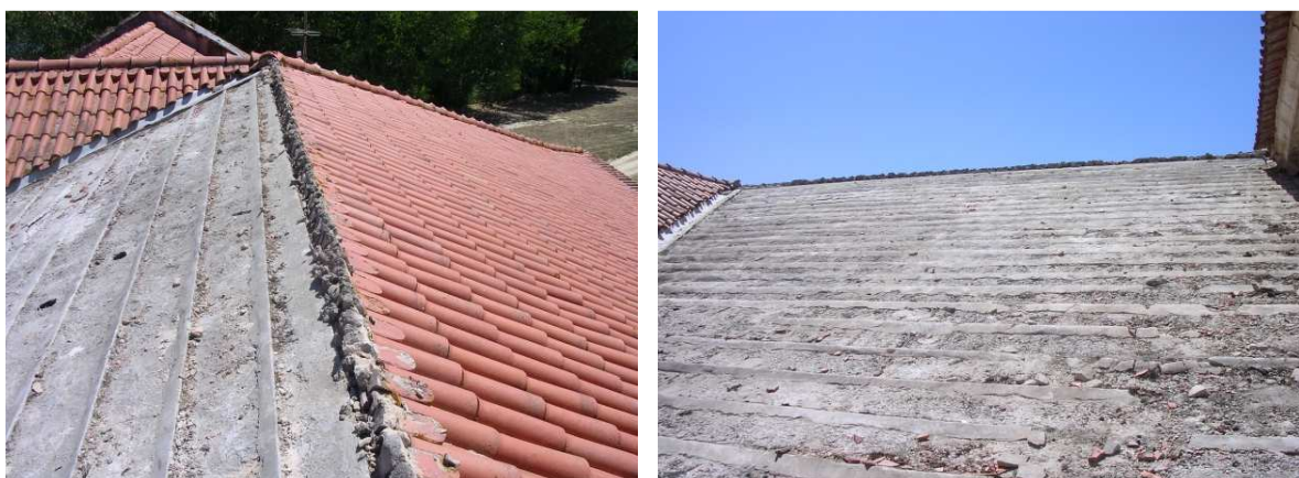
Figura 71 – Biblioteca – Coberturas em lajes aligeiradas com vigotas pré-esforçadas, abobadilhas cerâmicas e lâmina de betão de compressão.
