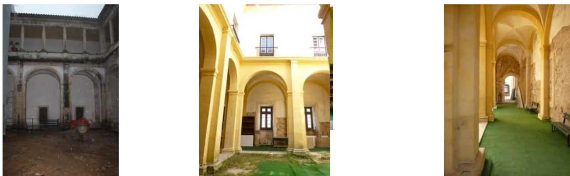
Figura 24 – Claustros da Portaria e da Hospedaria antes da intervenção.
