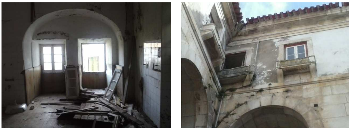
Figura 60 – Vãos em caixilharia de madeira.
