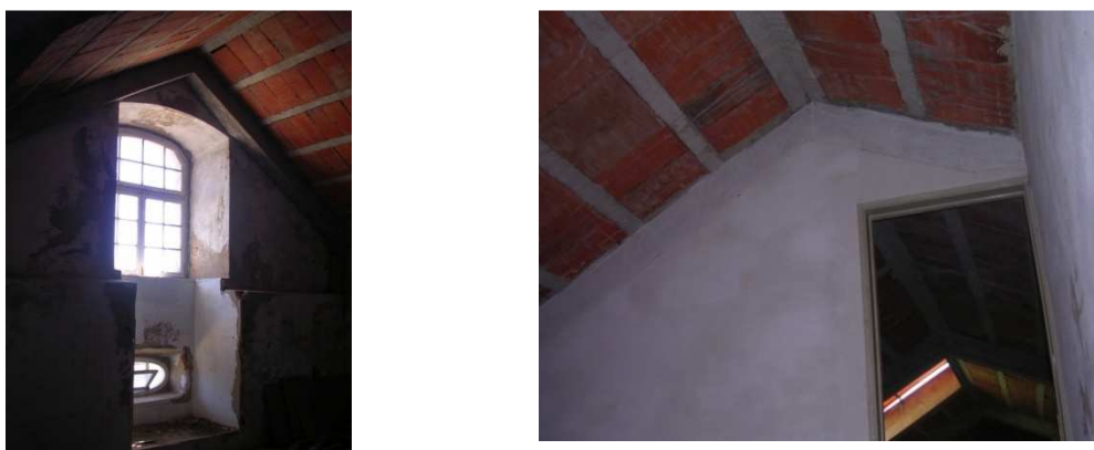
Figura 70 – Claustro do Rachadouro, coberturas em lajes aligeiradas.
