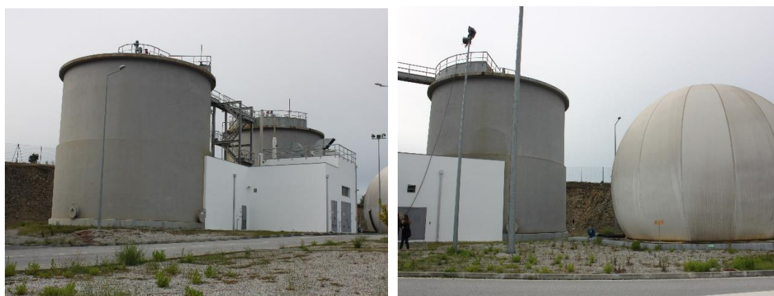
Figura 17. Digestores anaeróbios e gasómetro da ETAR de Castelo Branco
