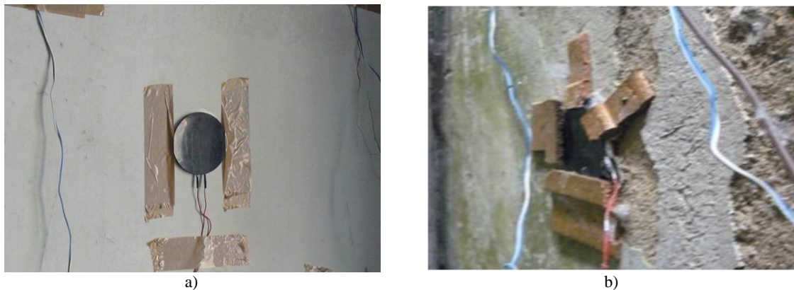
Figura 4.4 - Montagem dos fluxímetros parede 1: a) Paramento interior; b) Paramento exterior
