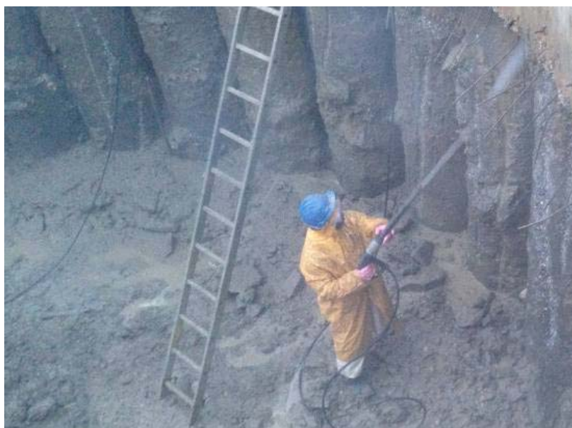
Fig. 18 – Limpeza das Estacas do Poço B
