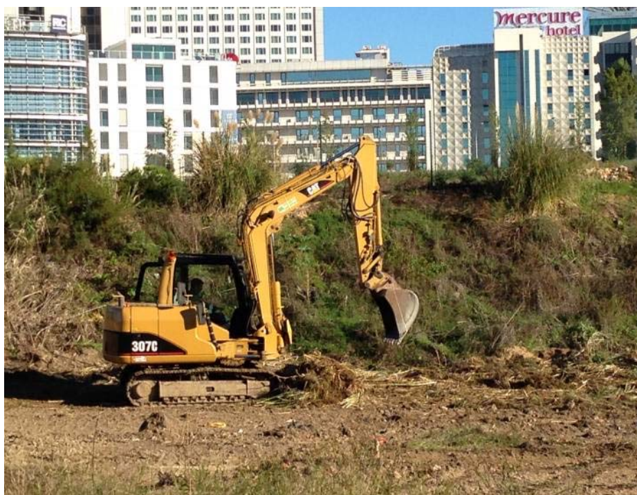
Fig. 15 – Desmatização do Terreno na Zona do Estaleiro
