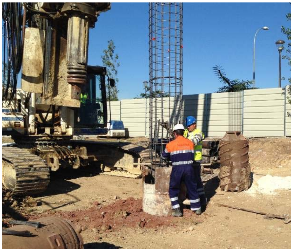
Fig. 17 – Execução de Estacas
