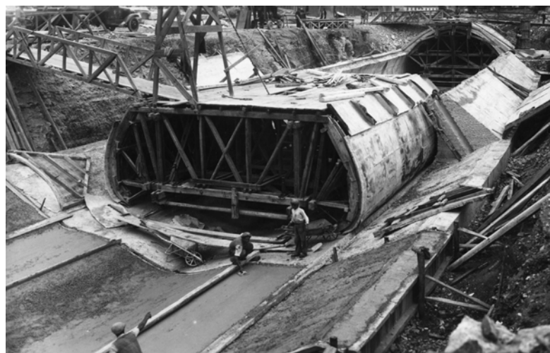
Fig. 12 – Caneiro de Alcântara – Obras de Cobertura da Ribeira de Alcântara (1945)
