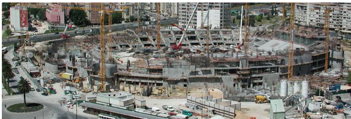
Fig. 2 – Construção do Novo Estádio do Sporting Clube de Portugal (2003).
