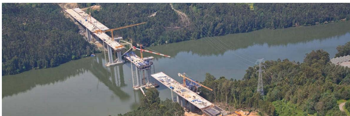
Fig. 6 – Ponte sobre o Rio Douro na A41- Concessão do Douro Litoral (2011)
