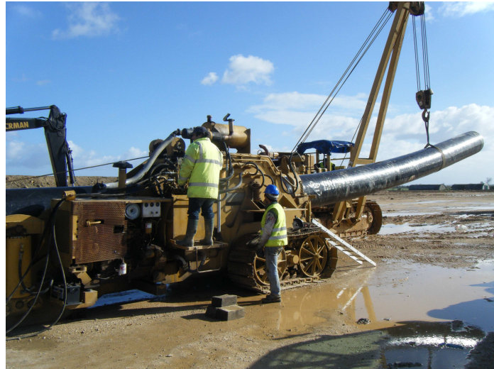
Figura 22 – Equipamento de encurvamento a frio.
