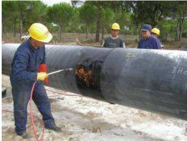
Figura 33 – Aplicação de manga termo retráctil em junta soldada
