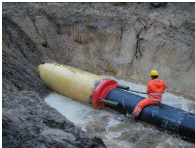
Figura 43 – Instalação de caboduto de fibra óptica, para transmissão de dados
