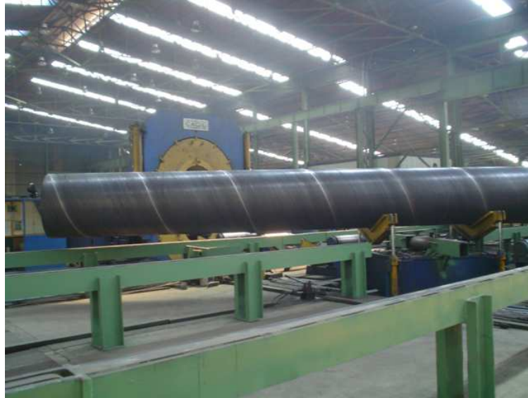
Figura 18 – Inspeção de tubos em fábrica.
