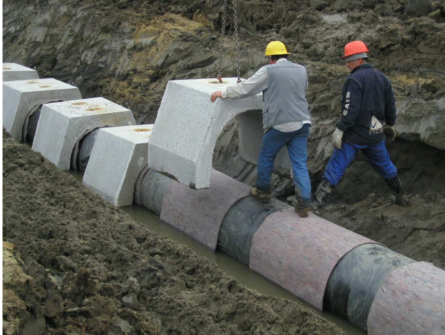
Figura 40 – Colocação de muretes de betão
