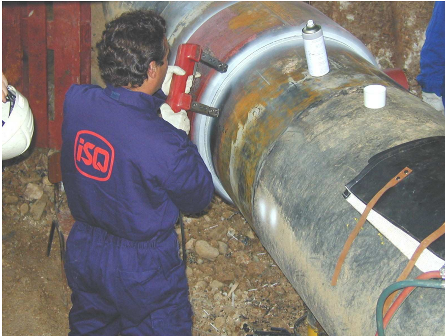
Figura 30 – Realização de ensaio por magnestocopia
