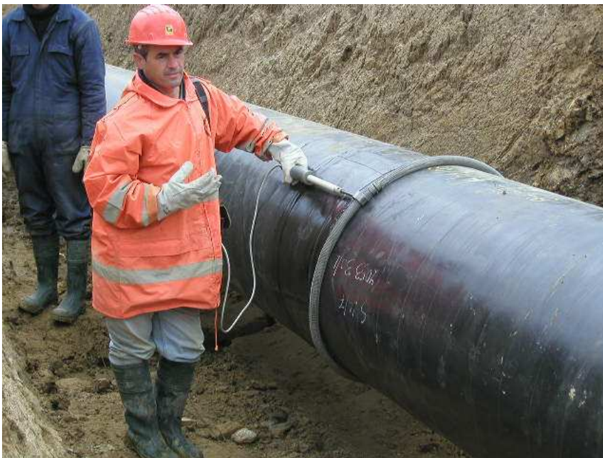
Figura 37 – Execução de ensaio dieléctrico ao revestimento de tubagem
