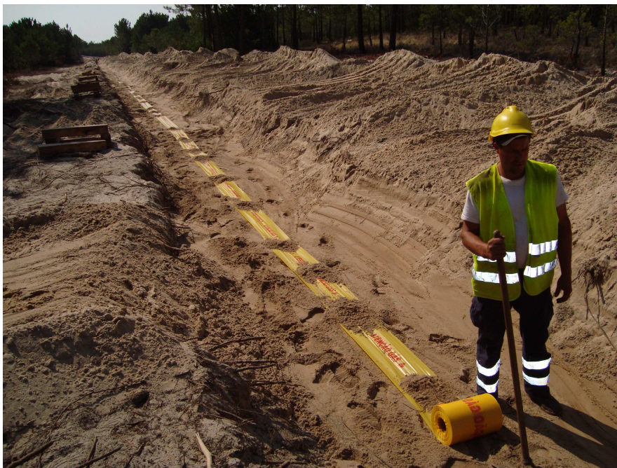
Figura 39 – Colocação de fita avisadora “Atenção Gás”
