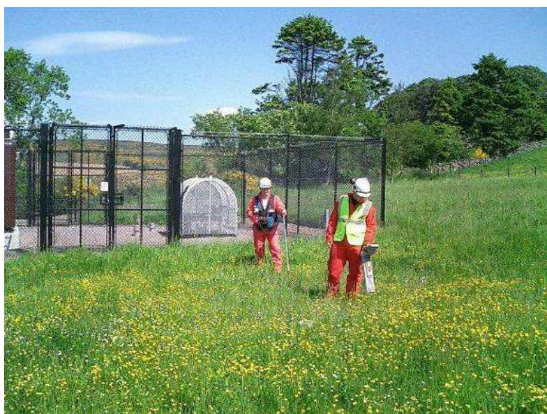
Figura 50 – Inspeção CIPS, seguida de identificação da tubagem por radiodeteção [32]
