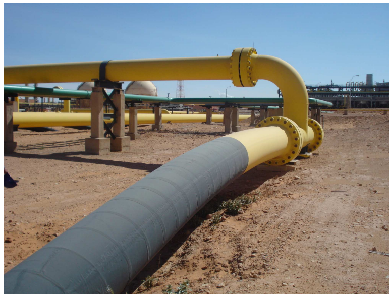
Figura 2 – Vista geral de gasoduto em Norte de África 5
