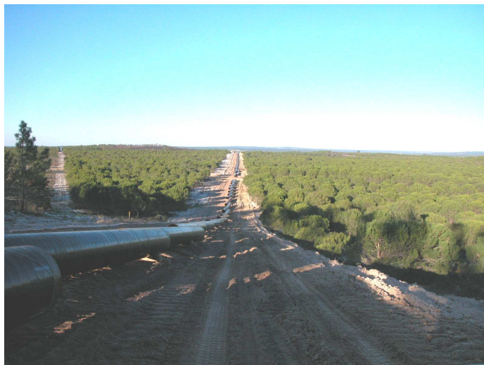
Figura 20 – Alinhamento da tubagem.
