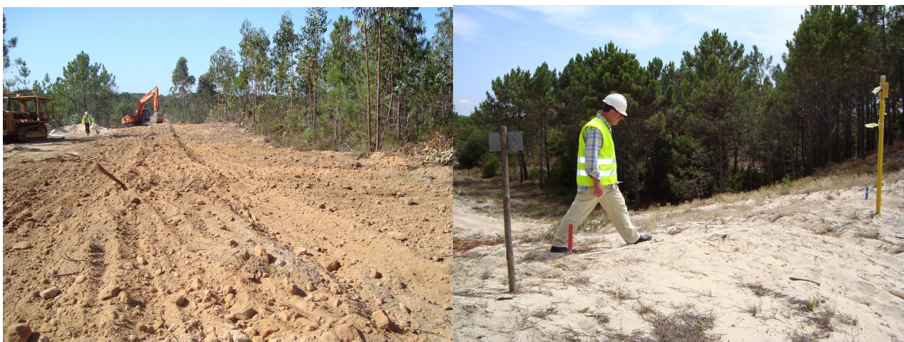
Figura 19 – Abertura de pista e pormenor de verificação da delimitação da faixa com estacas
