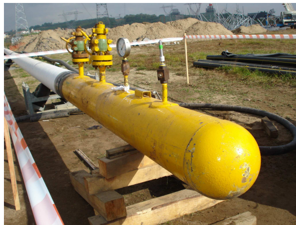
Figura 35 – Vista de ponto terminal de enchimento do gasoduto, vulgarmente designado por “cabeça de teste”
