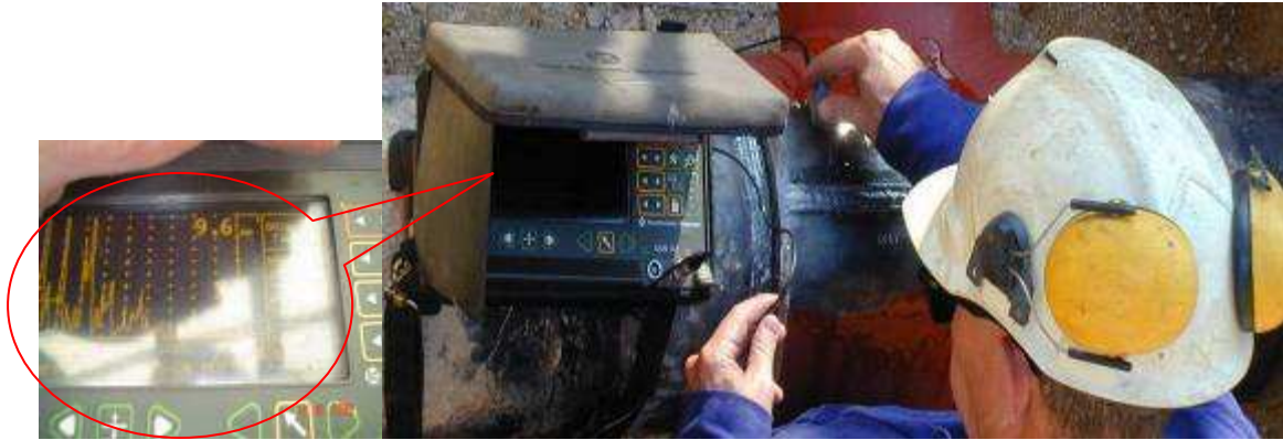
Figura 32 – Realização de ensaio por ultra - sons
