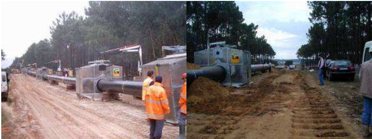
Figura 25 – Execução de soldadura mecanizada
