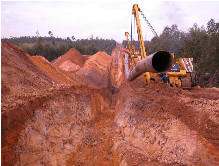
Figura 38 – Colocação de tubagem na vala
