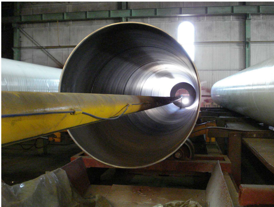
Figura 14 – Aplicação de revestimento interno, por pistola pulverizante a 360° no interior do tubo
