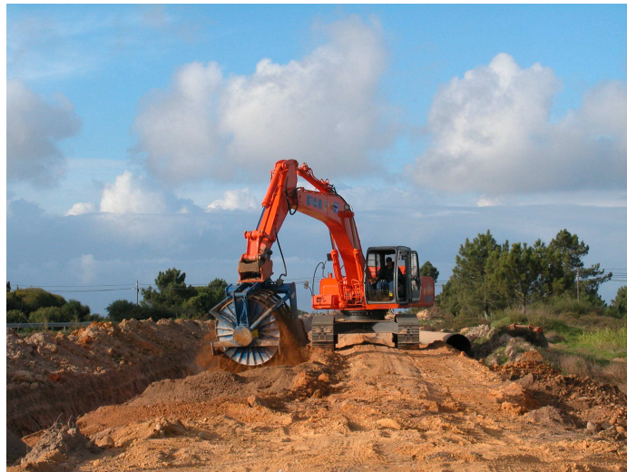
Figura 21 – Abertura de vala e segregação de pedras no leito da vala
