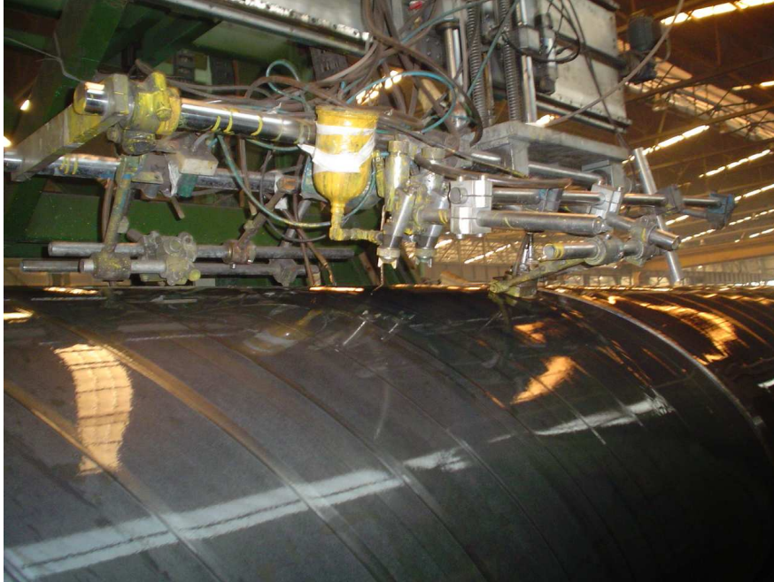
Figura 8 – Operação de soldadura helicoidal da chapa para fabrico de tubos
