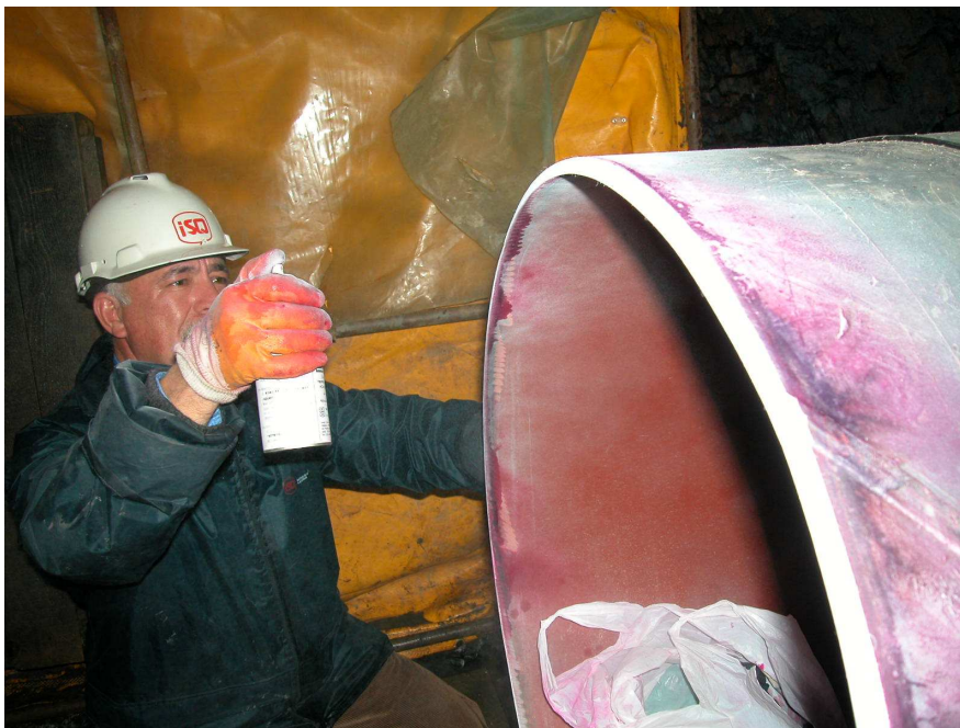
Figura 31 – Realização de ensaio por líquidos penetrantes
