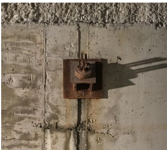
Figura 2-48 – Cabeça de uma ancoragem ativa
