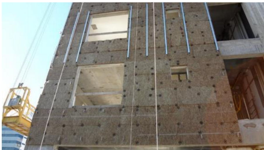
Figura 2-64 – Fixação da lã de rocha na fachada
