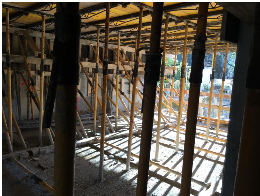
Figura 2-52 – Cofragem das lajes
