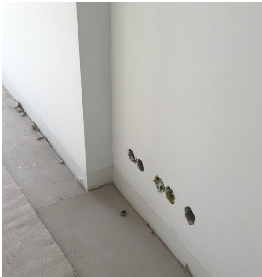
Figura 2-72 – Rodapé coplanar com a parede
