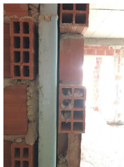
Figura 2-9 - Isolamento térmico colocado no interior da alvenaria
