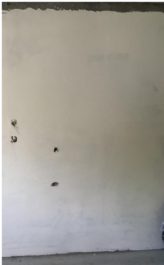
Figura 2-5 – Parede exterior estucada pelo interior
