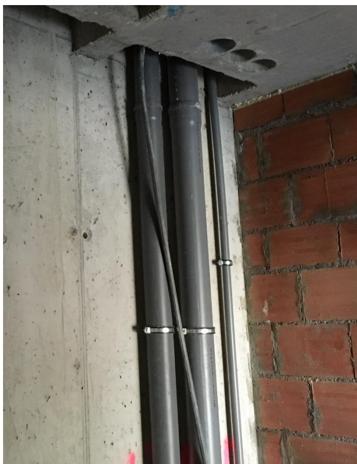
Figura 2-59 – Prumadas das águas residuais
