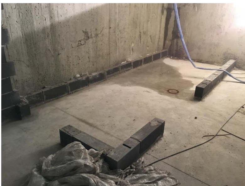
Figura 2-57 – Colocação da 1ª fiada de alvenaria das arrecadações
