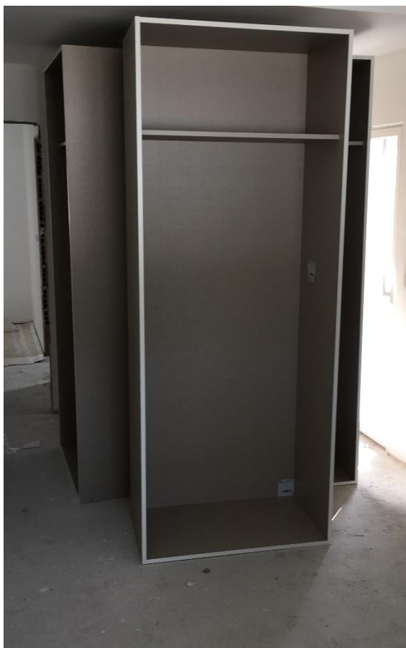
Figura 2-28 – Montagem dos caixotes dos roupeiros
