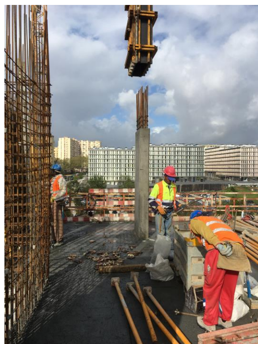
Figura 2-54 – Pilar descofrado
