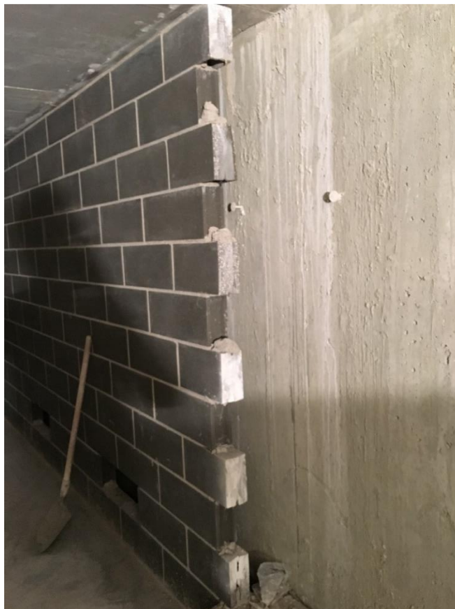
Figura 2-56 – Parede de blocos de betão para realização da caixa de ar e da caleira
