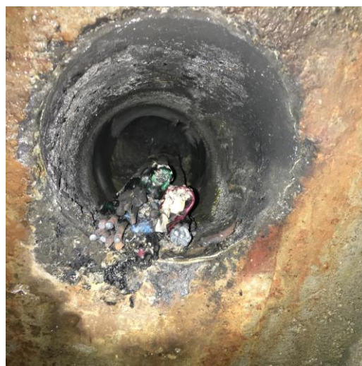
Figura 2-49 – Aspto de uma ancoragem desativada
