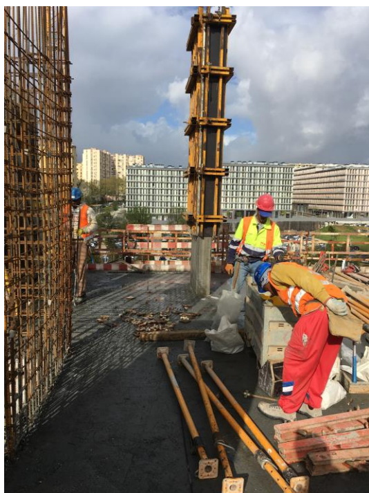
Figura 2-53 - Descofragem de pilares
