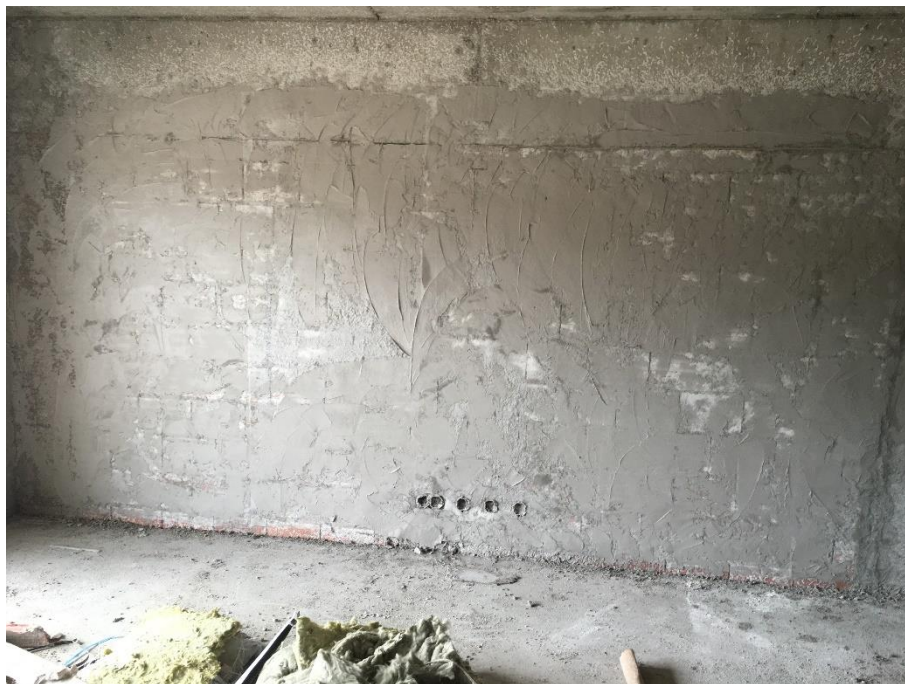
Figura 2-23 – Camada de argamassa de enchimento
