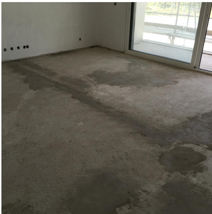
Figura 2-41 – Reparação de betonilhas
