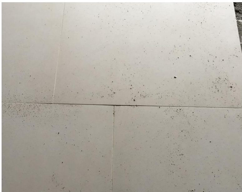
Figura 2-40 – Empenamento das peças cerâmicas
