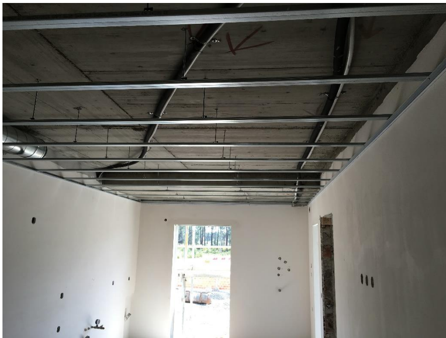
Figura 2-31 – Estrutura metálica de suporte para teto falso
