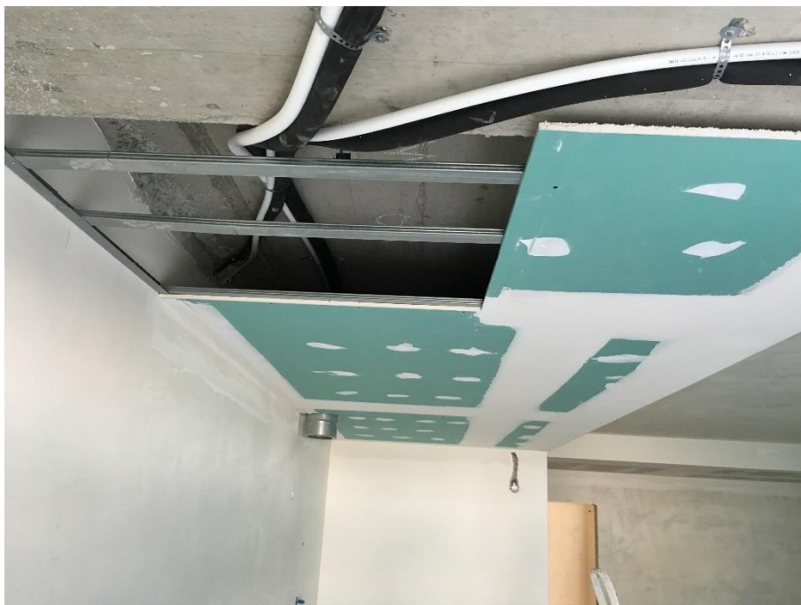
Figura 2-32 – Colocação dos painéis e tratamento de juntas do teto falso
