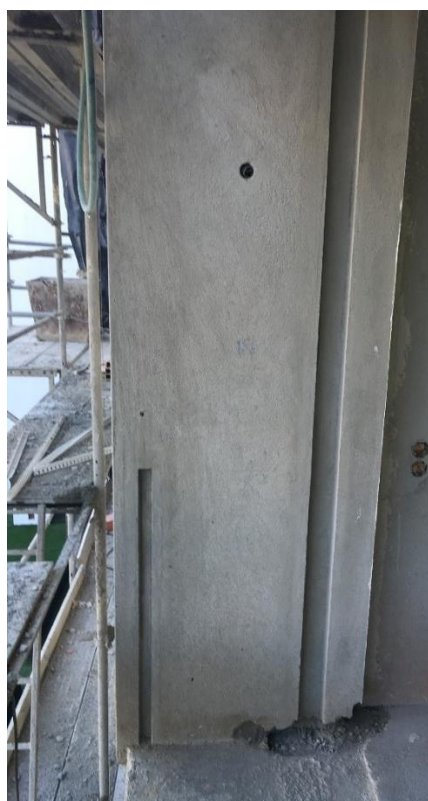
Figura 2-69 – Negativos deixados no reboco para a guarda de vidro e estores
