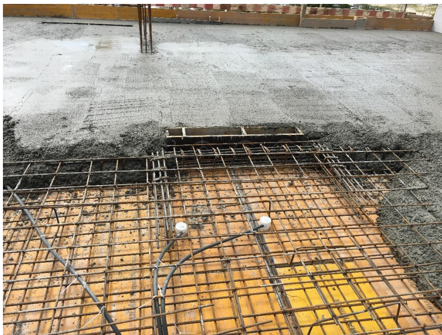
Figura 2-55 – Betonagem da laje e localização de negativos
