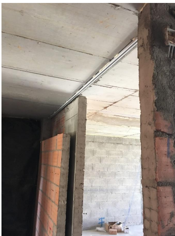
Figura 2-82 – Colocação da calha para as portadas
