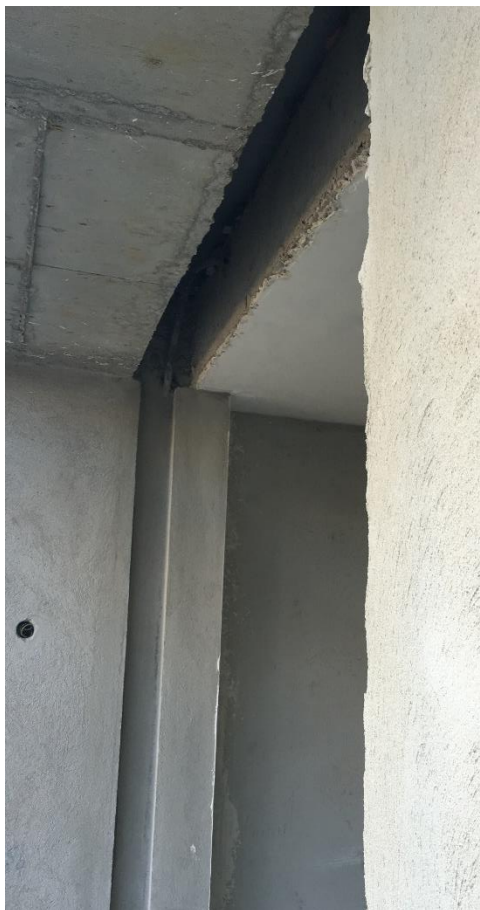
Figura 2-68 – Aspecto do negativo na laje para a caixa de estore
