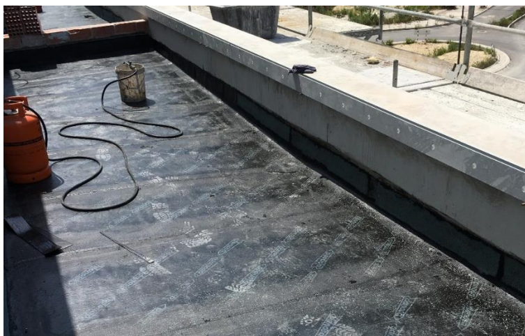
Figura 2-20 – Colocação da tela de impermeabilização
