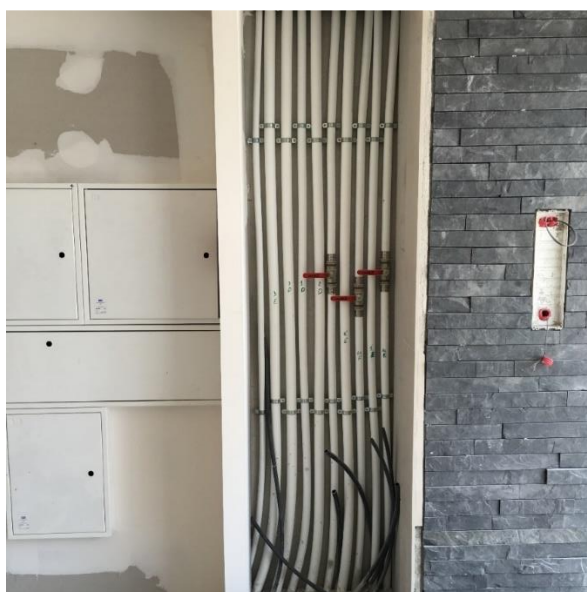
Figura 2-14 - Coluna de distribuição de águas
