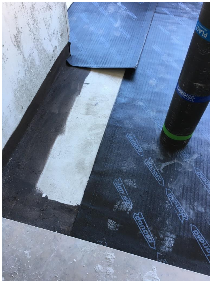
Figura 2-21 - Impermeabilização de uma varanda
