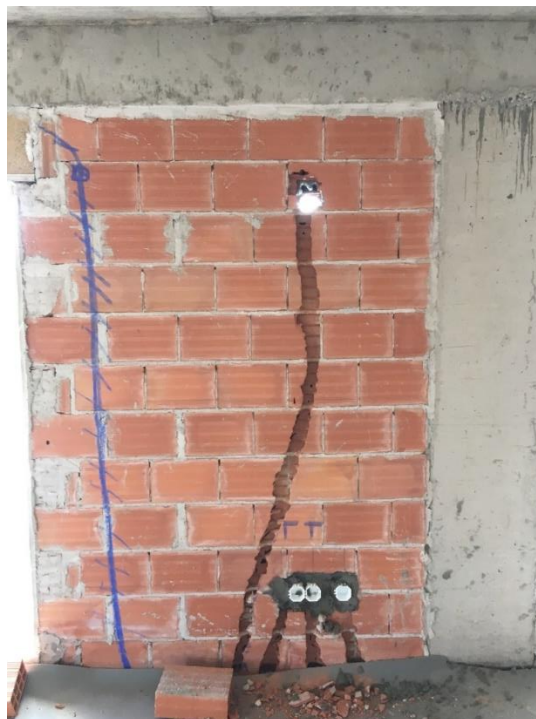
Figura 2-18 - Abertura de roço para colocação das instalações elétricas
