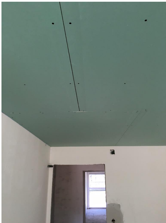
Figura 2-33 – Aspeto do teto falso sem barramento das juntas
