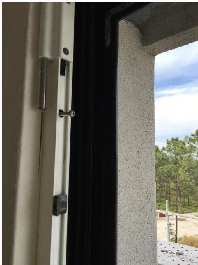
Figura 2-22 – Fixação do caixilho
