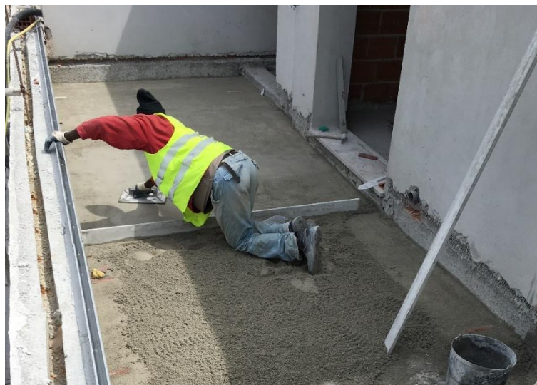
Figura 2-19 – Operação de acabamento final da betonilha com taloça
