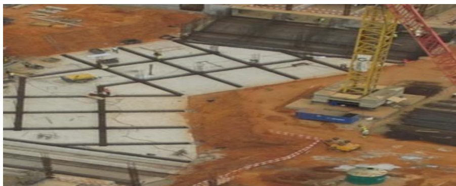
Figura 4.52 – Armação do Troço-A da Culvert da CCC do Soyo.
