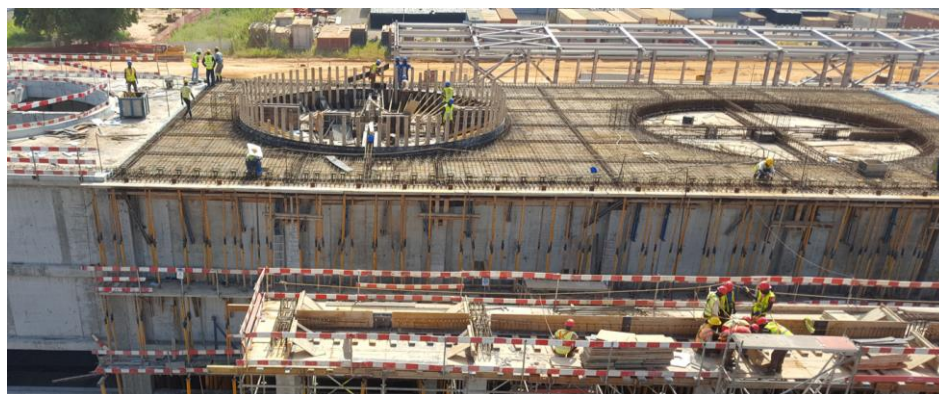
Figura 4.43 – Pormenor da armação e cofragem da laje do topo e vigas circulares ao nível 11,80m para o bloco E da torre de arrefecimento #2 da CCC do Soyo.
