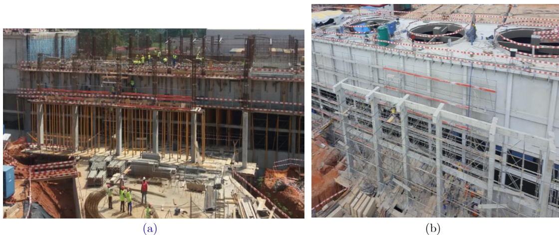
Figura 4.59 – (a) Execução dos pórticos da comporta ao 1º nível da CCC do Soyo; (b) Execução dos pórticos da comporta ao 2º nível da CCC do Soyo.
