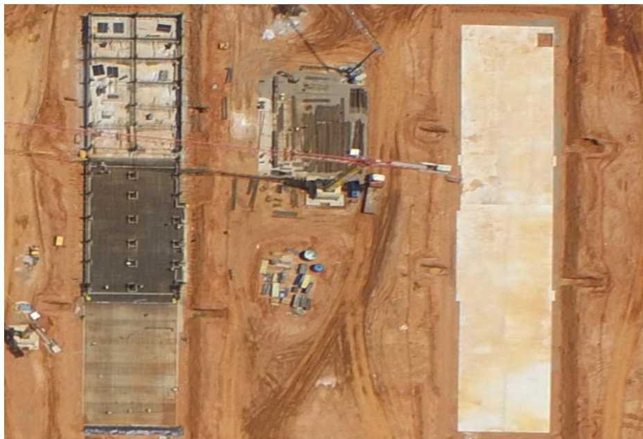
Figura 4.40 – Pormenor de cura para a laje do fundo, paredes e pilares para o bloco A da torre de arrefecimento #1 da CCC do Soyo.
