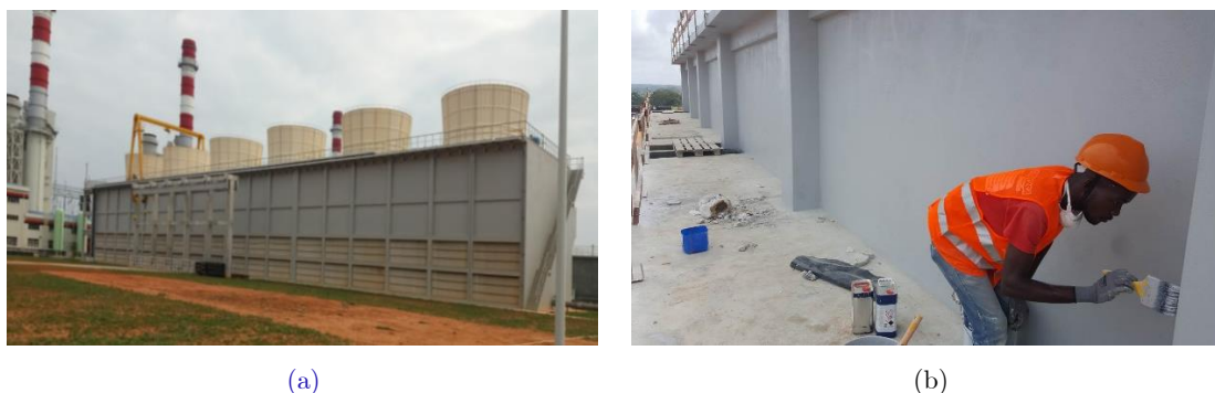
Figura 4.64 – (a) Aspetto final da CCC do Soyo; (b) Utilização de pincel para os cantos numa das Torres da CCC do Soyo.
