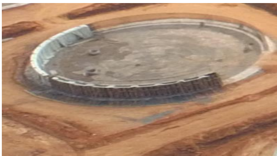
Figura 4.10 – Troco ja betonado e em fase de cura de um anel de fundacao para a CCC do Soyo.
