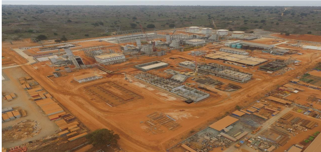
Figura 1.2 – Vista aérea da Central de Ciclo Combinado do Soyo durante a fase de construção, foto tirada à 28.08.2017
