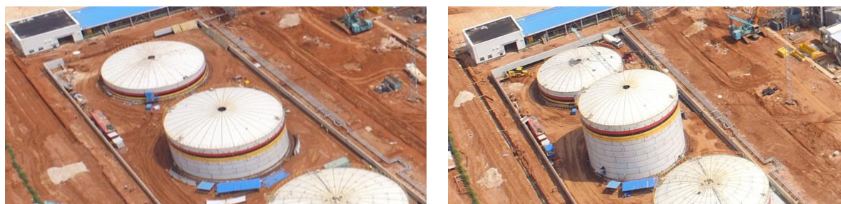
Figura 4.17 – Impermeabilização das paredes e aterro e compactação do terreno.
