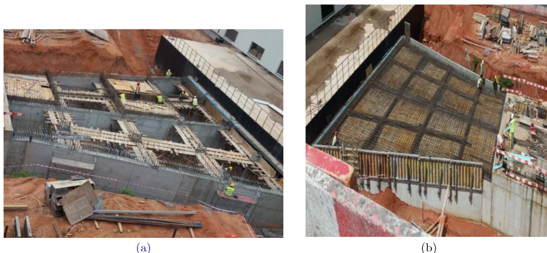
Figura 4.54 – (a) Fase inicial da cofragem e armação do Troço-D da Culvert da CCC do Soyo; (b) Armação do Troço-D da Culvert da CCC do Soyo.
