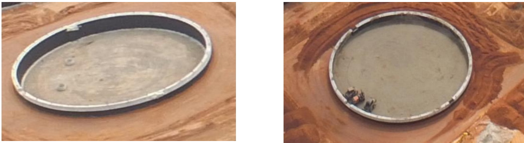
Figura 4.11 – Anel de fundação para a CCC do Soyo com pintura impermeabilizante e compactação de tout-venant no interior.
