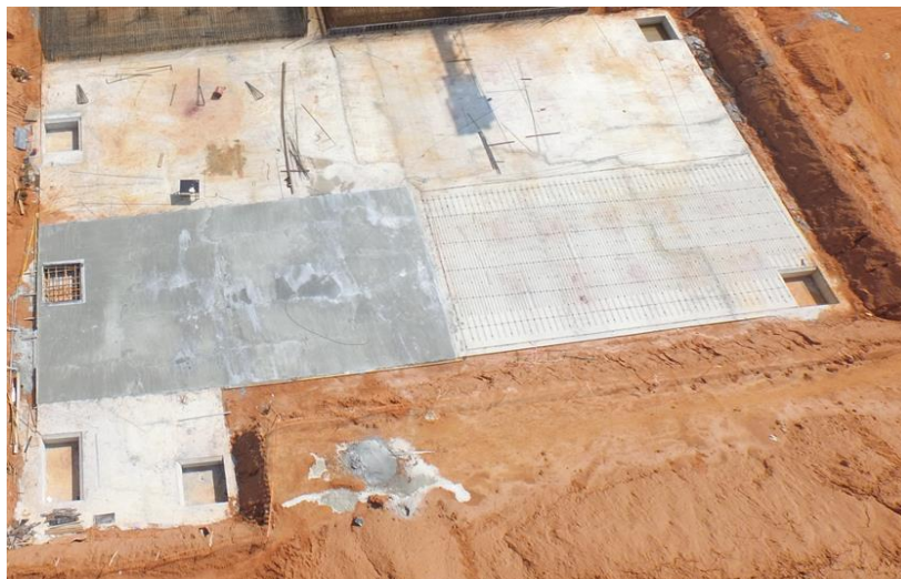
Figura 4.25 – Betão de limpeza colocado para os tanques de água de combate a incêndio e água reutilizada da CCC do Soyo.
