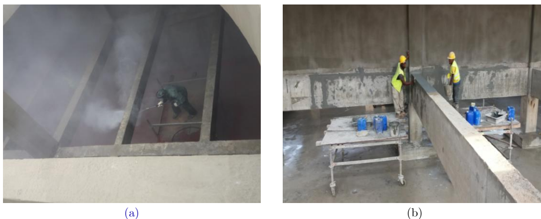
Figura 4.62 – (a) Limpeza à 500 bar em uma das Torres da CCC do Soyo; (b) Regularização de uma das vigas da CCC do Soyo.
