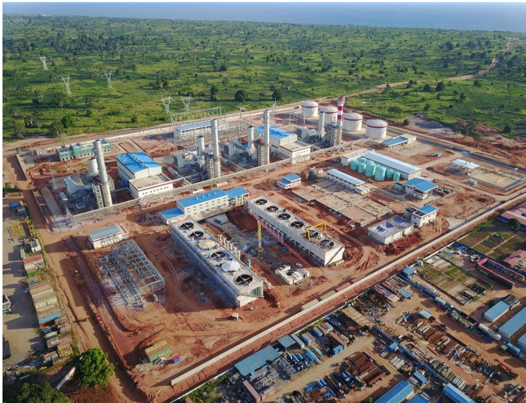
Figura 1.1 – Vista aérea da Central de Ciclo Combinado do Soyo durante a fase de construção, foto tirada à 21.04.2018.
