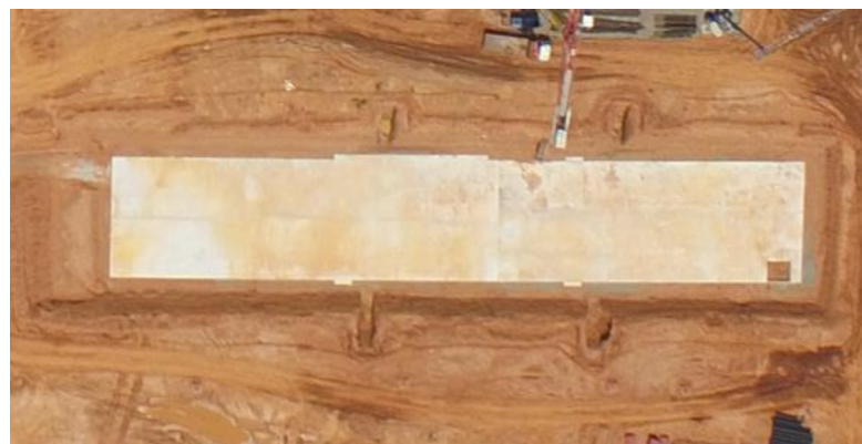
Figura 4.38 – Colocação do betão de limpeza para uma das torres de arrefecimento da CCC do Soyo.
