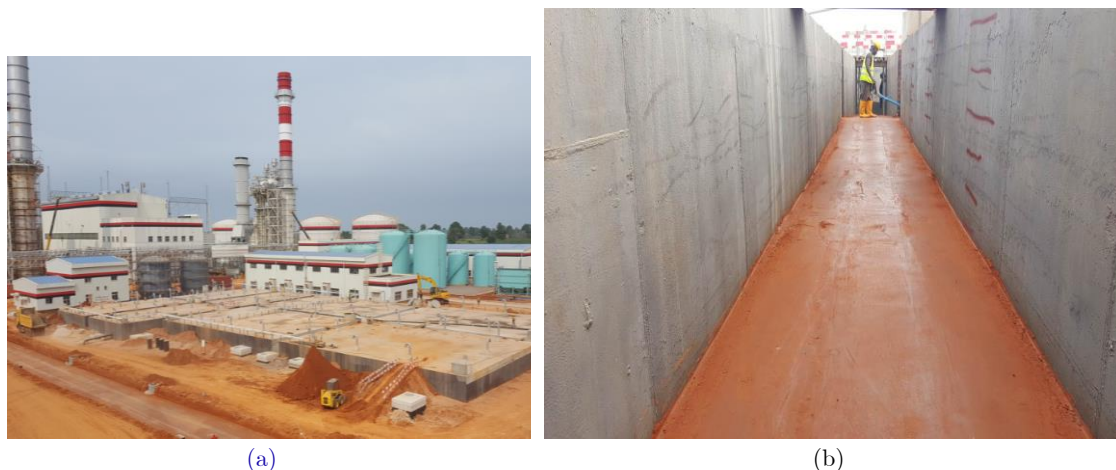
Figura 4.29 – (a) Impermeabilização dos tanques de água CCC do Soyo; (b) Compactação dos tanques de água da CCC do Soyo.
