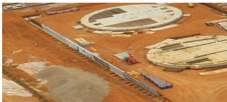
Figura 4.16 – Troço de paredes de contenção betonados e em cura para a CCC do Soyo.
