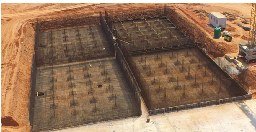
Figura 4.26 – Colocação de armadura para os 4 tanques de água bruta da CCC do Soyo.
