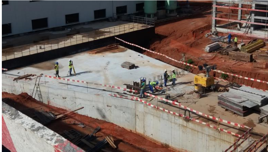
Figura 4.55 – Armação e cofragem dos pilares-guia do Troço-D da Culvert da CCC do Soyo.
