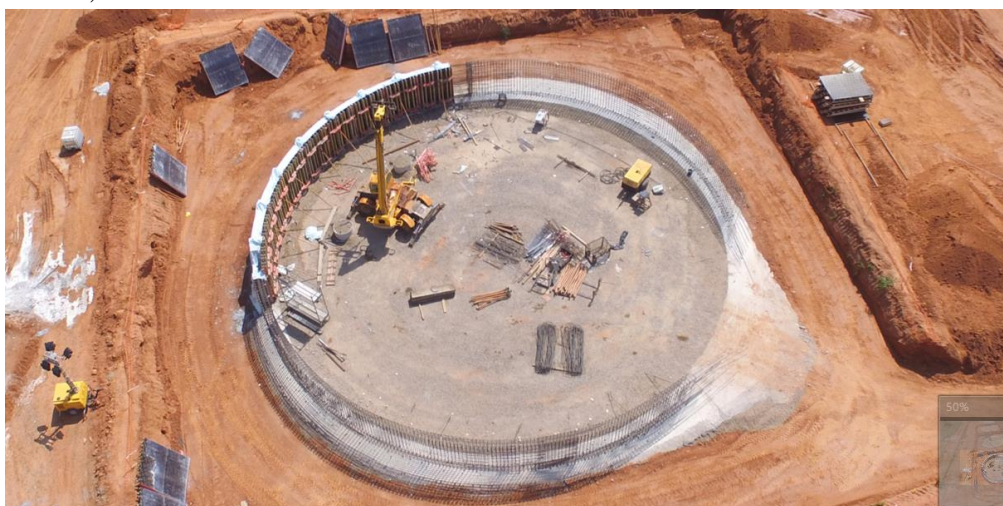
Figura 4.9 – Armação e cofragem de um anel de fundação para a CCC do Soyo.
