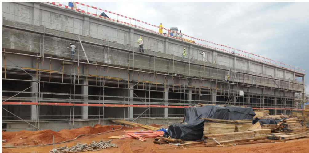
Figura 4.61 – Aplicação da primeira camada de reboco à uma das Torres de Arrefecimento da CCC do Soyo.
