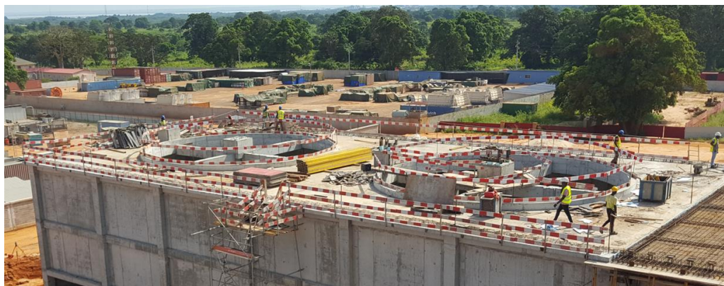
Figura 4.44 – Pormenor da cura da laje do topo e vigas circulares ao nível 11,80m para o bloco E da torre de arrefecimento #2 da CCC do Soyo.
