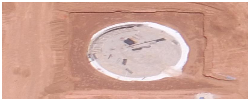
Figura 4.8 – Colocação de betão de limpeza e 1ª camada de « tout-venant » em um anel de fundação para a CCC do Soyo.
