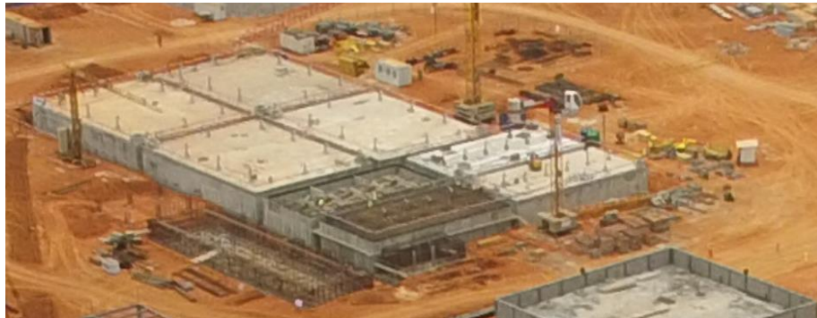
Figura 4.28 – Betonagem e cura para a laje de topo dos tanques de água da CCC do Soyo.
