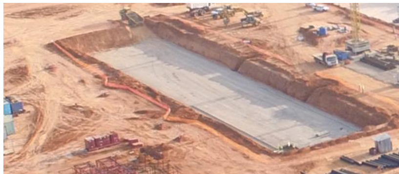
Figura 4.37 – Colocação e compactação de aterro em tout-venant para uma das torres de arrefecimento da CCC do Soyo.
