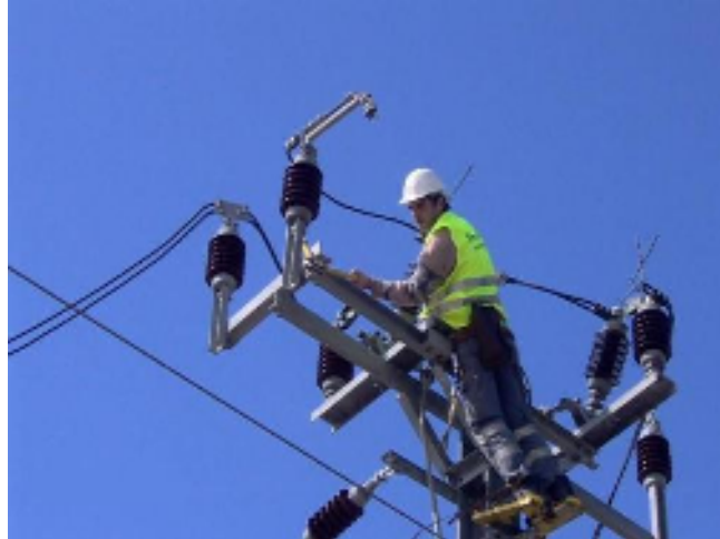
Figura 3-26 - Montagem de Seccionadores [35]
