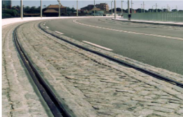
Figura 2-5 - Via em carril embebido no Metro do Porto [35]
