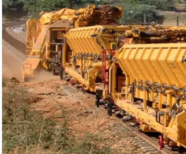
Figura 3-3 - Desguarnecimento mecânico pesado [35]
