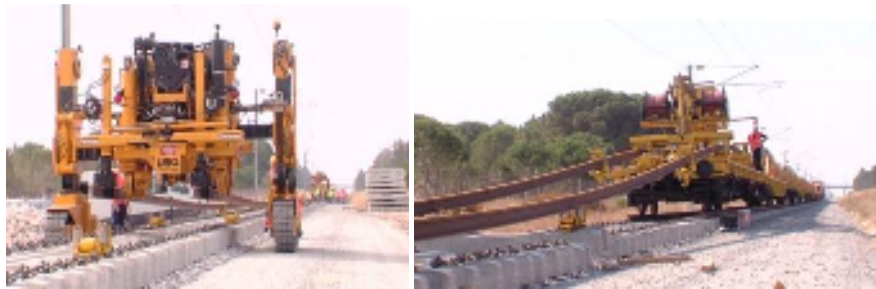
Figura 5-2 - Comboio Carrileiro - Descarga longitudinal do carril [35]
