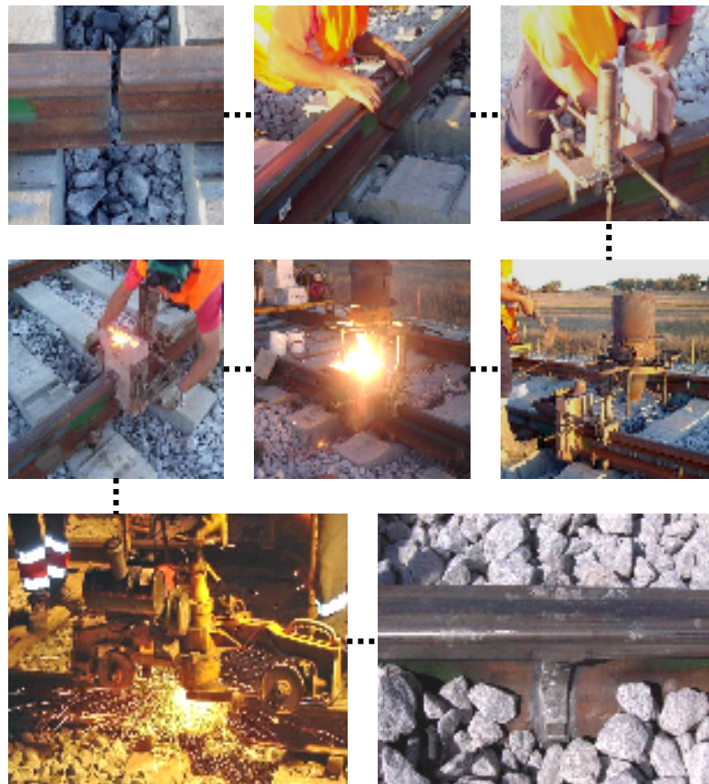
Figura 3-12 - Execução de uma soldadura aluminotérmica [32]
