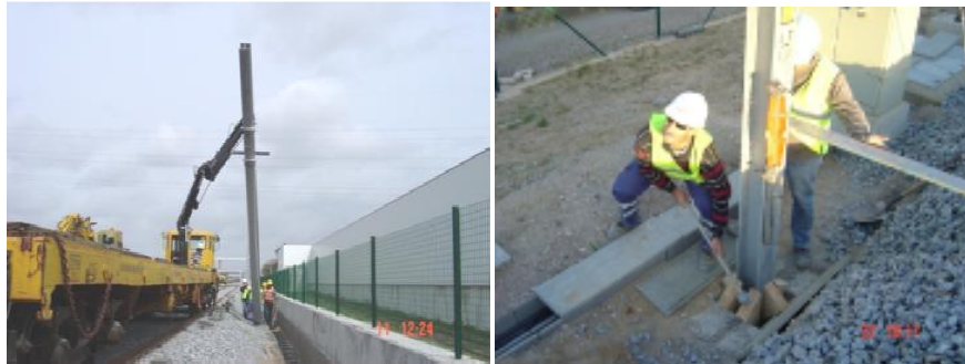
Figura 3-21 - Montagem do poste [35]
