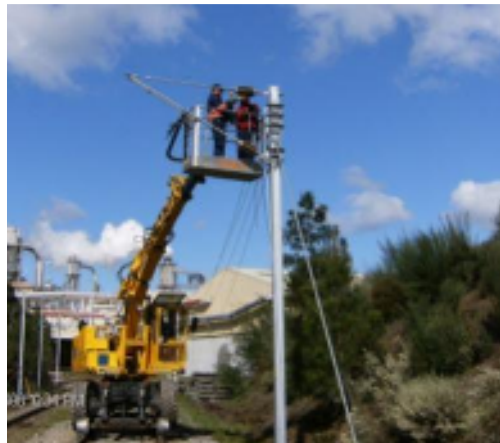
Figura 3-22 - Montagem de Consola [35]
