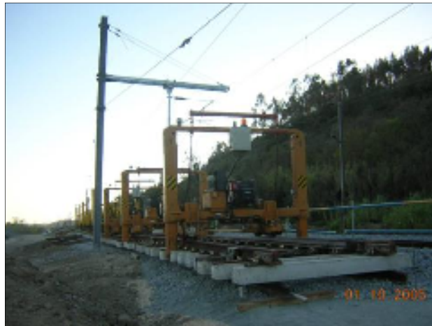
Figura 5-5 - Ripagem de aparelho com pórticos de AMV [35]
