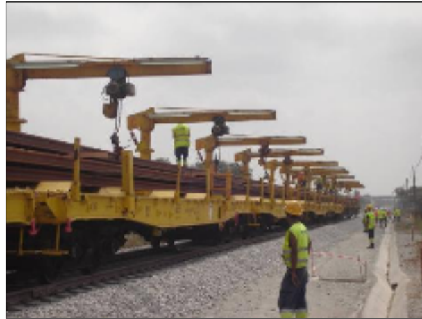
Figura 5-1 - Comboio com pórticos - Descarga lateral de carril [35]
