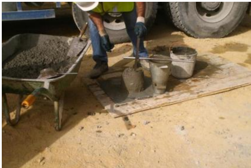
Figura 4.9. Ensaio de trabalhabilidade do betão – “Slump Test”
