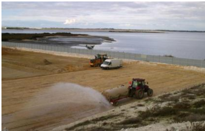
Figura 4.7. Pormenor do aterro da ETAR (rega da camada)
