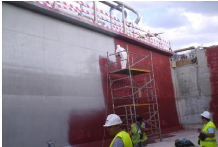
Figura 6.3. – Pormenor do revestimento das paredes de betão com produto impermeabilizante
