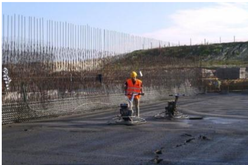
Figura 4.12. – Pormenor do acabamento do betão, após a betonagem de uma laje
