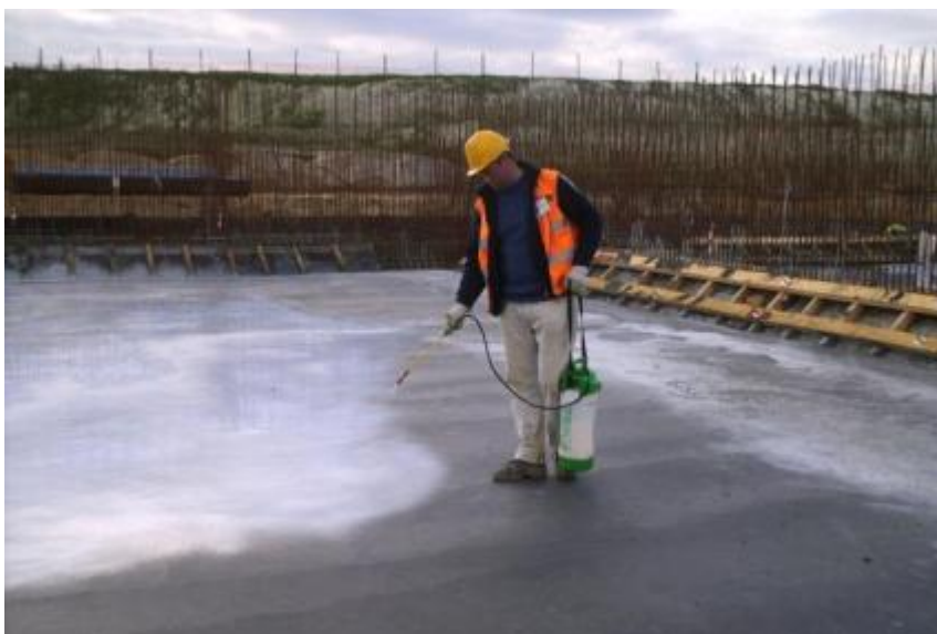
Figura 4.13. – Pormenor do tratamento para cura do betão (colocação de antisol)
