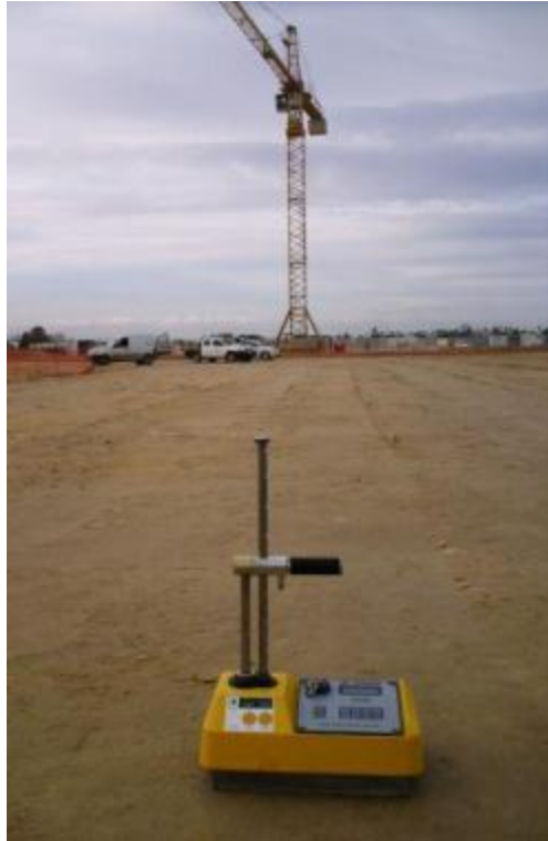
Figura 4.15. - Ensaio “in situ” de controlo de compactação do tipo “troxler”, de uma camada de aterro
