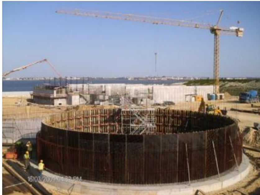
Figura 4.10. – Pormenor da cofragem circular de um dos digestores
