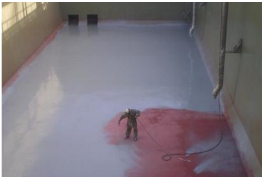
Figura 6.4. - Pormenor do revestimento das paredes de betão com produto impermeabilizante
