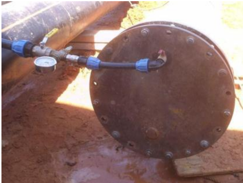
Figura 4.14. – Pormenor de um ensaio de condutividade hidráulica de uma conduta
