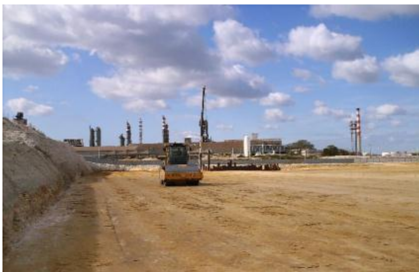
Figura 4.8. Compactação de uma camada de aterro com cilindro vibratório
