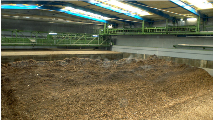
FIGURA 2.8 – NAVE DE MATURAÇÃO/FERMENTAÇÃO, (VALOR AMBIENTE, (2013)).
