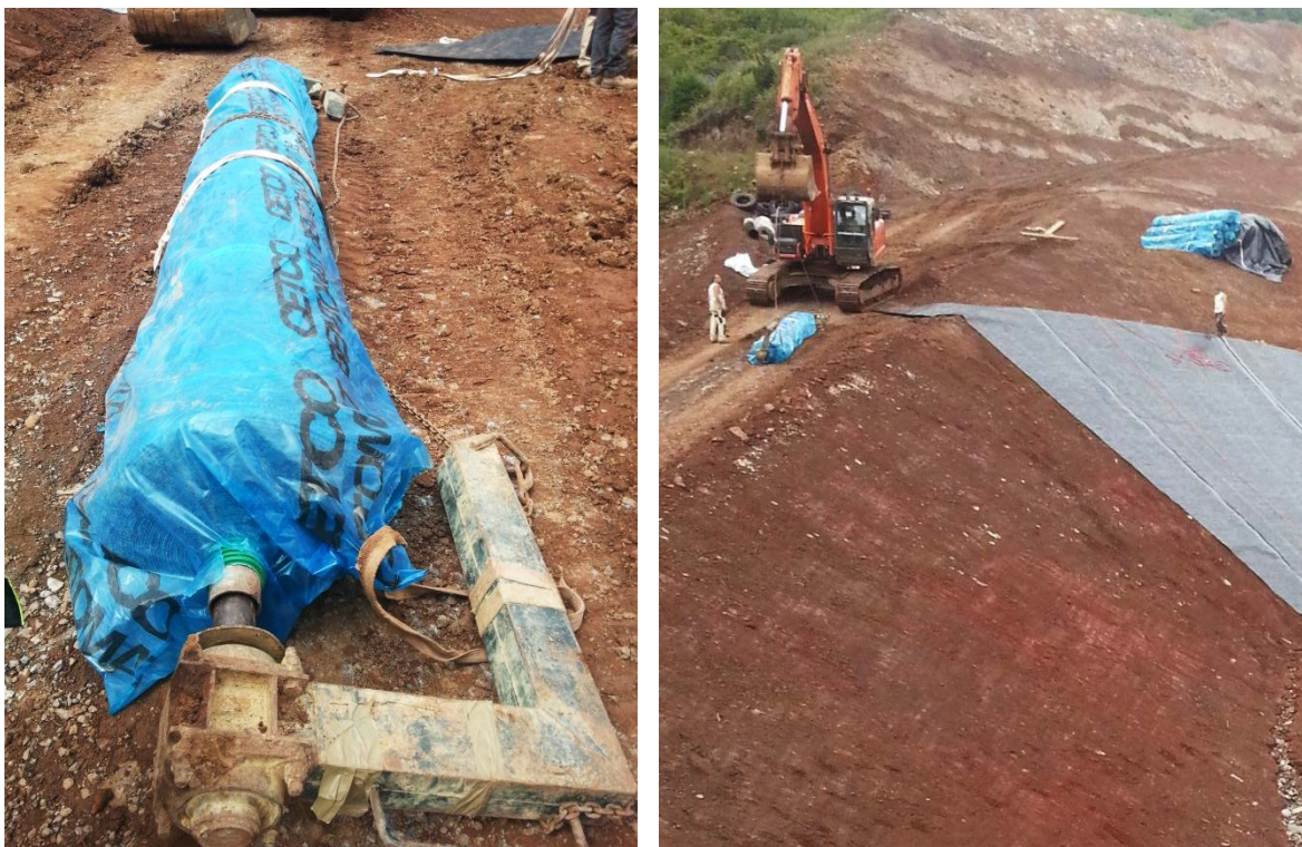
FIGURA 4.10 – APLICAÇÃO DE GEOCOMPÓSITOS BENTONÍTICOS RECORRENDO AO AUXÍLIO DE UMA ESCAVADORA E EQUIPAMENTO AUXILIAR DE ELEVAÇÃO, (ARQUIVO PESSOAL).
