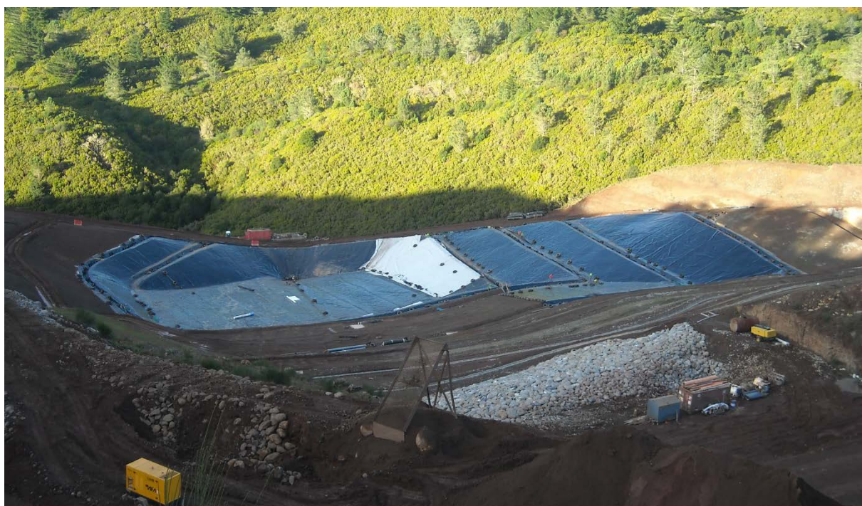
FIGURA 4.9 – VISTA GERAL DA CÉLULA A1 NA FASE DE INSTALAÇÃO DA GEOMENBRANA, (ARQUIVO PESSOAL).
