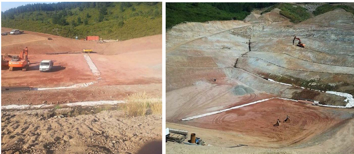
FIGURA 4.26 – SISTEMA DE DRENAGEM ÁGUA DE NASCENTE NO FUNDO DA CÉLULA A1 E BANQUETAS, (ARQUIVO PESSOAL).
