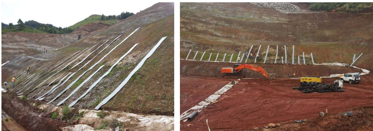
FIGURA 4.13 – APLICAÇÃO DE BANDAS DE GEOCOMPÓSITO DRENANTE NA REGULARIZAÇÃO DE TALUDES, (ARQUIVO PESSOAL).
