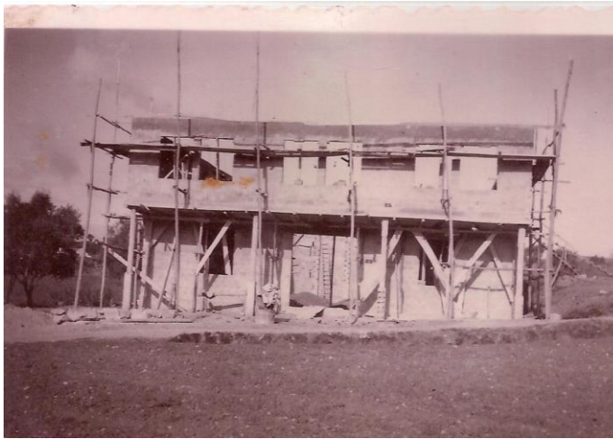
FIGURA 4 - A estrutura do edifício já montada Fonte: Arquivo da ADRC
