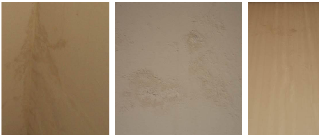
Figura 144: P1_EMP_08, P1_EMP_09 e P1_EMP_10 (Fonte: Autor, 2016)
