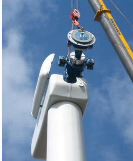
Figura 2.10 - Instalação de uma caixa de engrenagens (Anderson 2008).
