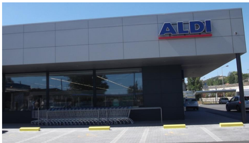
Figura 70 - Fachada lateral poente
