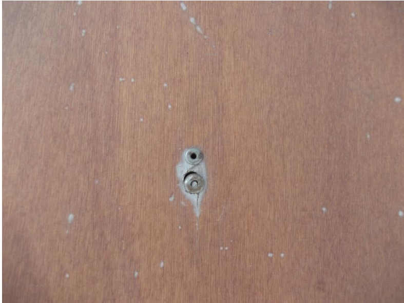
Figura 31 - Colocação de rebites
