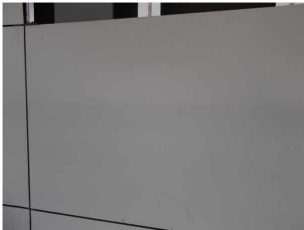
Figura 66 - Painel colocado na fachada
