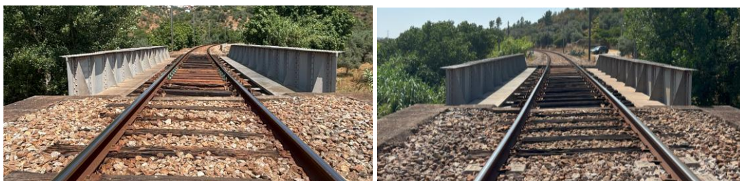
Figura 4.51 – Ponte da Várzea, sentido NE-SO
