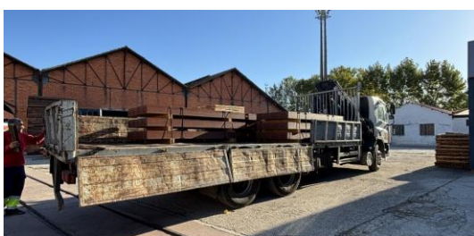
Figura 4.14 – Travessas acomodadas no camião de transporte e sua chegada ao Estaleiro (Antiga estação das Mouriscas)
