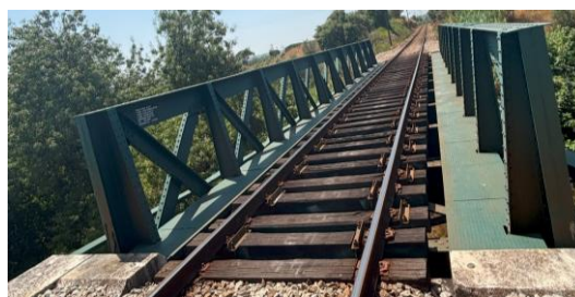
Figura 4.3 – Ponte de Alferrarede, vista superior
