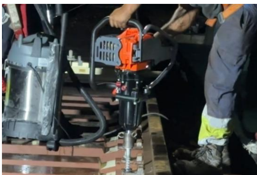
Figura 4.43 – Aperto dos chapins
