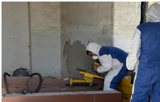
Figura 4.22 – Corte das travessas para acomodar as cantoneiras metálicas
