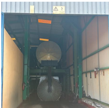
Figura 3.1 – Autoclave utilizada no processo de creosotagem
