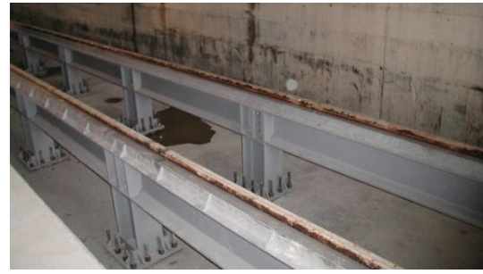
Figura 2.3 – Via em Dique (Estação de Zaragoza-Delicias)
