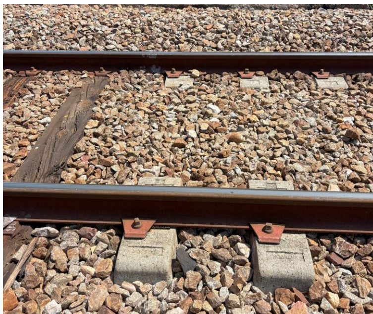
Figura 2.14 – Travessas de betão bi-bloco
