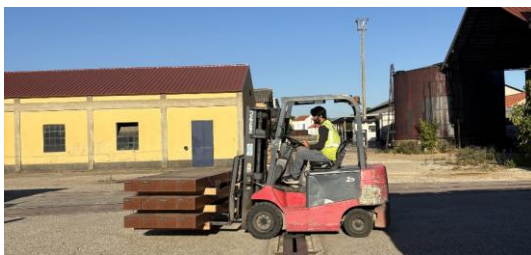
Figura 4.13 – Transporte das travessas entre o armazém e o camião-grua e sua colocação neste
