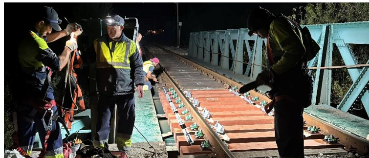
Figura 4.30 – Execução de trabalhos preparatórios
