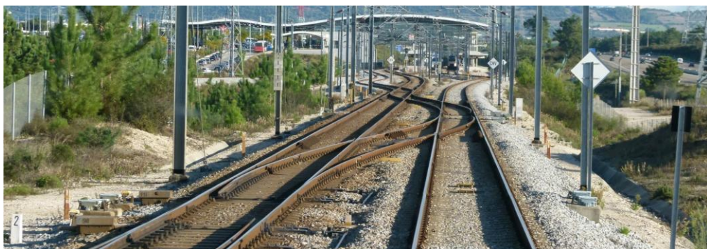
Figura 2.6 – Via balastrada (Estação de Coima)
