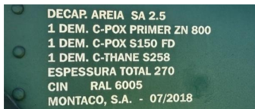
Figura 4.9 – Ponte de Alferrarede, manutenção / reabilitação da componente metálica
