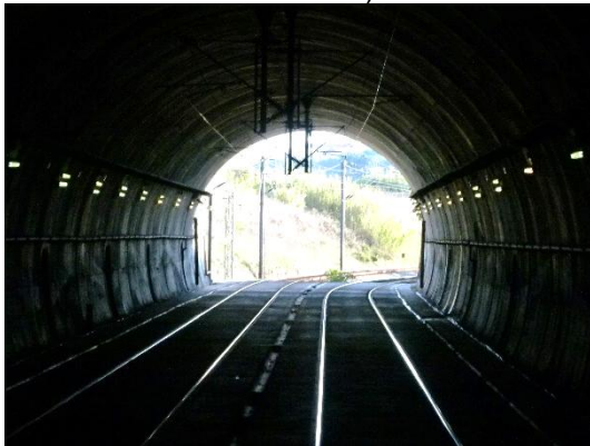
Figura 2.4 – Via em Túnel (Pragal)
