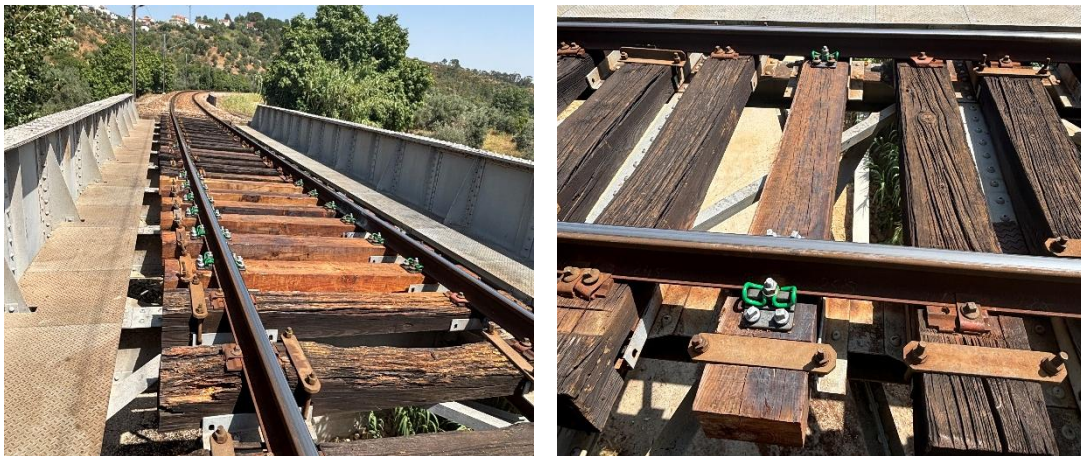
Figura 4.54 – Ponte da Várzea, distribuição das travessas
