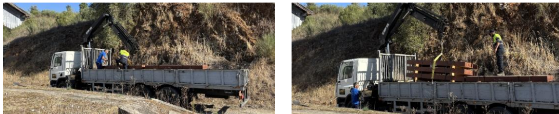
Figura 4.15 – Cintagem e elevação das travessas
