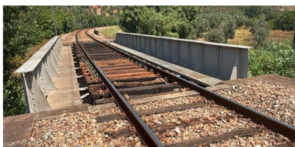
Figura 4.49 – Ponte da Várzea, vista superior
