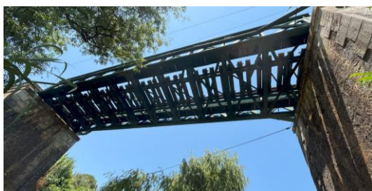
Figura 4.2 – Ponte de Alferrarede, vista inferior
