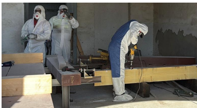
Figura 4.24 – Execução das furações para a ancoragem das cantoneiras
