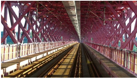
Figura 2.2 – Via em Ponte Metálica (Ponte 25 de Abril)
