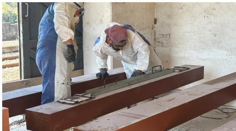
Figura 4.19 – Marcação da mesa de assentamento
