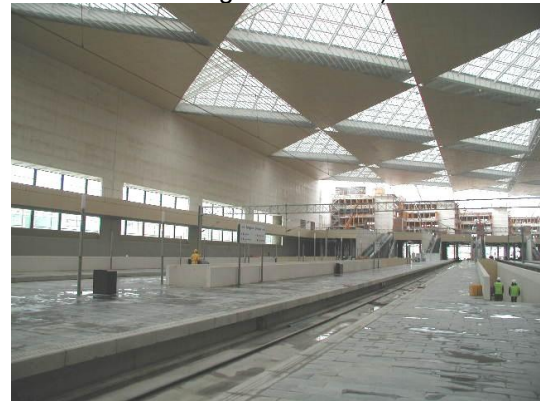
Figura 2.5 – Via betonada (Estação de Zaragoza-Delicias)
