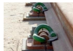
Figura 2.19 – Fixação Pandrol (Pandrol, s.d.)
