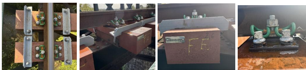
Figura 4.47 – Ponte de Alferrarede, novas cantoneiras e fixações
