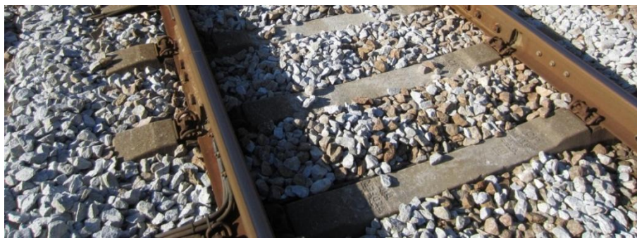
Figura 2.20 – Balastro para encastramento das travessas
