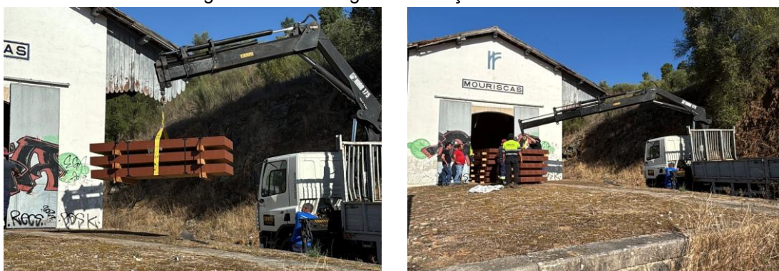
Figura 4.16 – Movimentação das travessas entre o camião e o cais coberto
