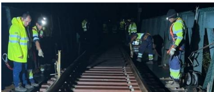
Figura 4.38 – Retirada dos macacos hidráulicos na fila direita
