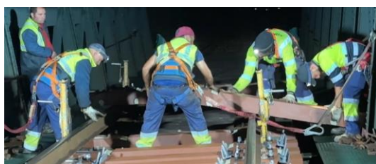
Figura 4.36 – Instalação das novas travessas FFU
