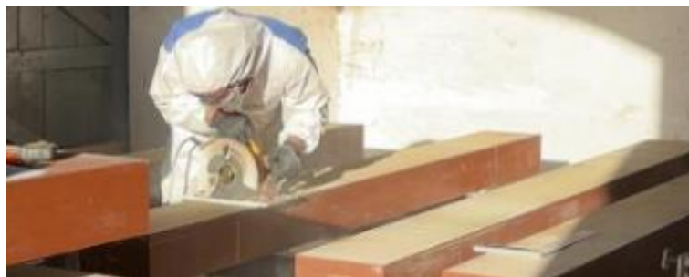
Figura 4.20 – Execução de cortes de referência
