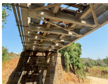
Figura 4.48 – Ponte da Várzea, vista inferior
