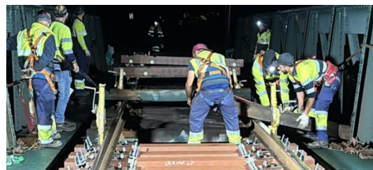
Figura 4.35 – Remoção das travessas a substituir
