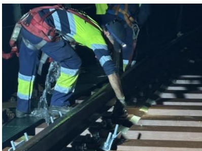
Figura 4.37 – Colocação das palmilhas sobre os chapins
