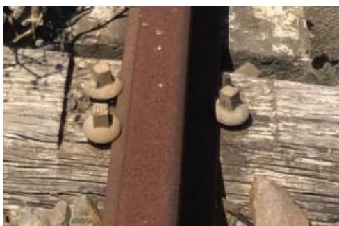
Figura 2.16 – Fixação rígida
