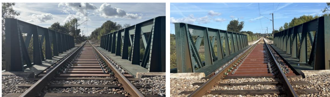
Figura 4.46 – Ponte de Alferrarede Finalizada
