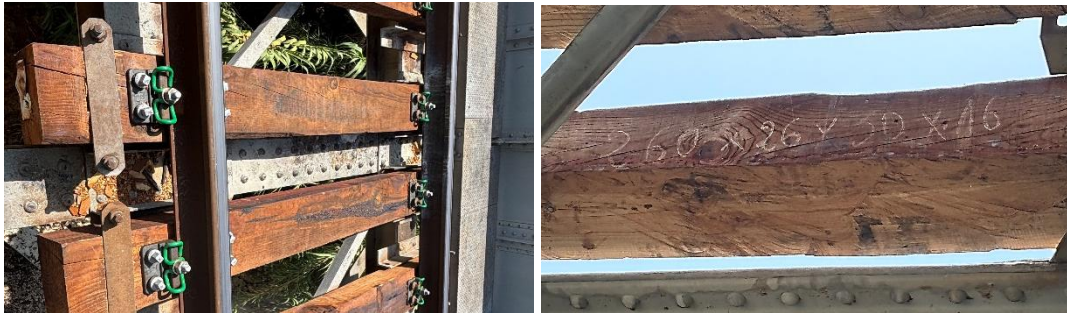
Figura 4.53 – Ponte da Várzea, Travessas trapezoidais
