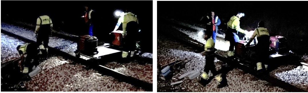
Figura 4.29 – Transporte do material com recurso a dresina de tração manual
