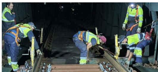
Figura 4.35 – Remoção das travessas a substituir
