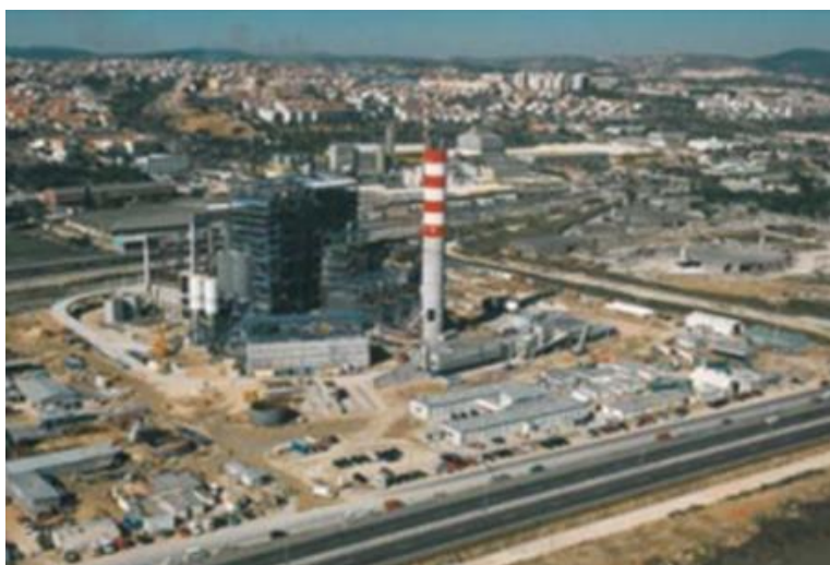
Figura 2.5 - Vista aérea da CTRSU ainda em fase de construção [27]
