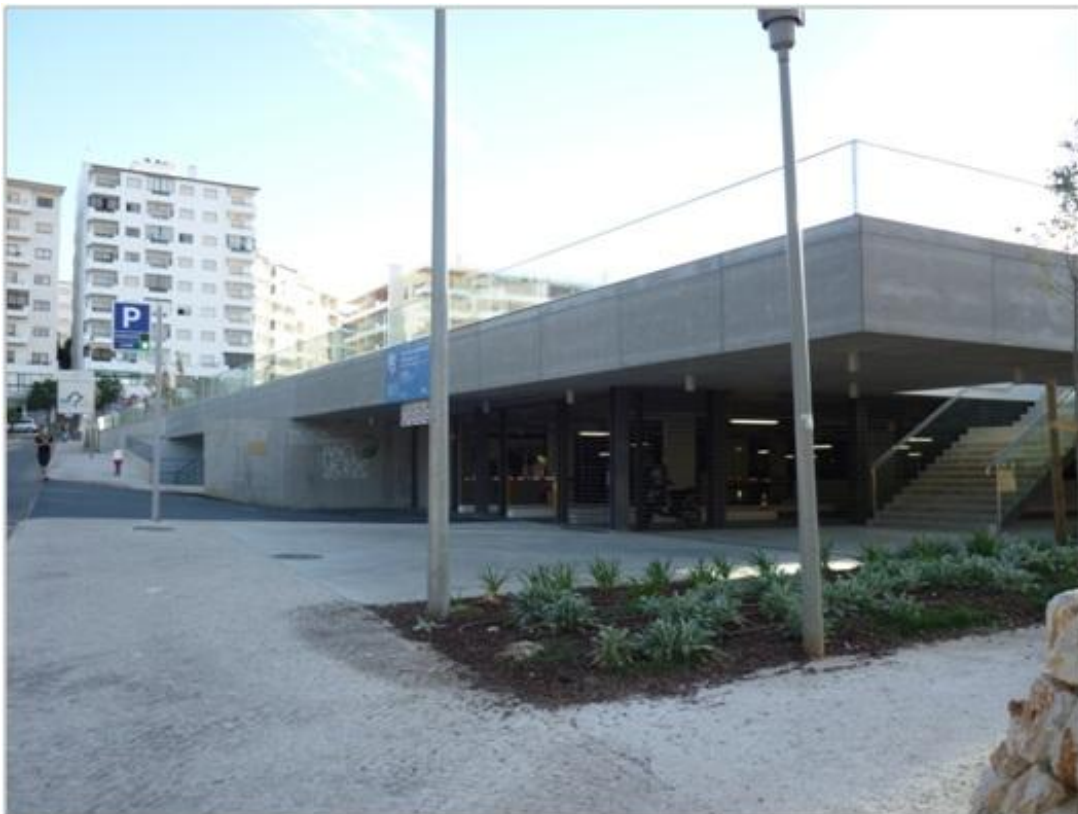
Figura III. Parque de estacionamento do Anel Verde (vista da Estrada da Piedade).
