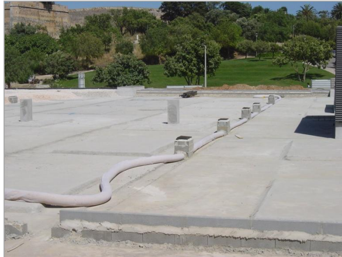
Figura 38. Drenos envoltos em manta geotêxtil e caixas de visita.
