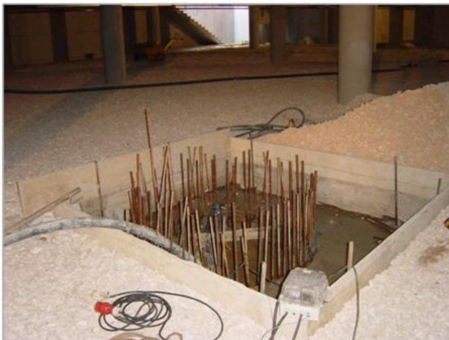
Figura 58. Poço de bombagem provisório desactivado e camada de brita.
