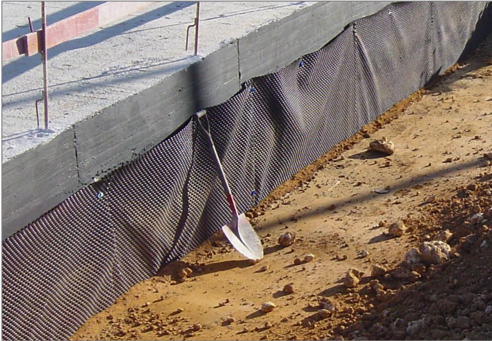
Figura 23. Fixação do painel de drenagem com de tampas de garrafão.
