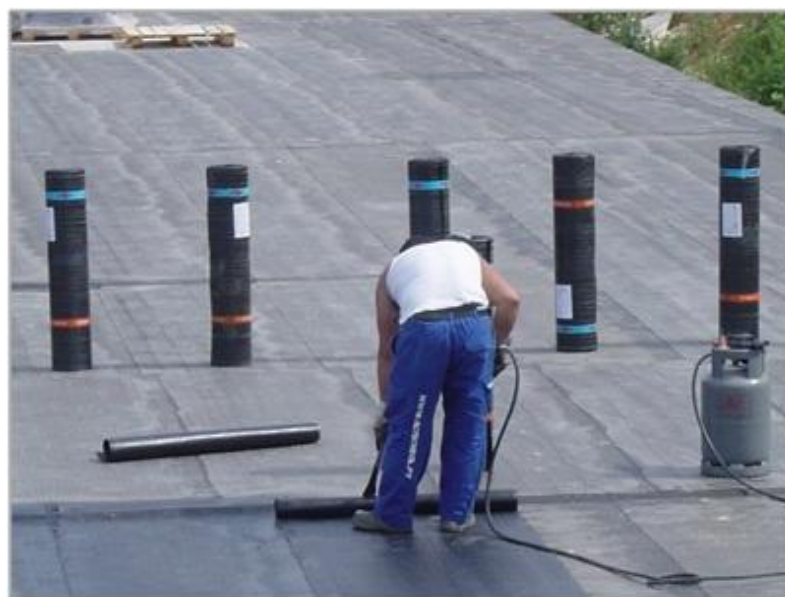
Figura 36. Aplicação da segunda camada do sistema de impermeabilização com juntas desfasadas.
