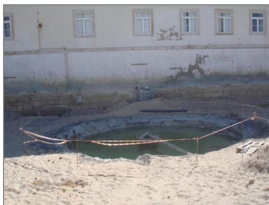
Figura 51. Poço de bombagem provisório antes da fase de escavação.
