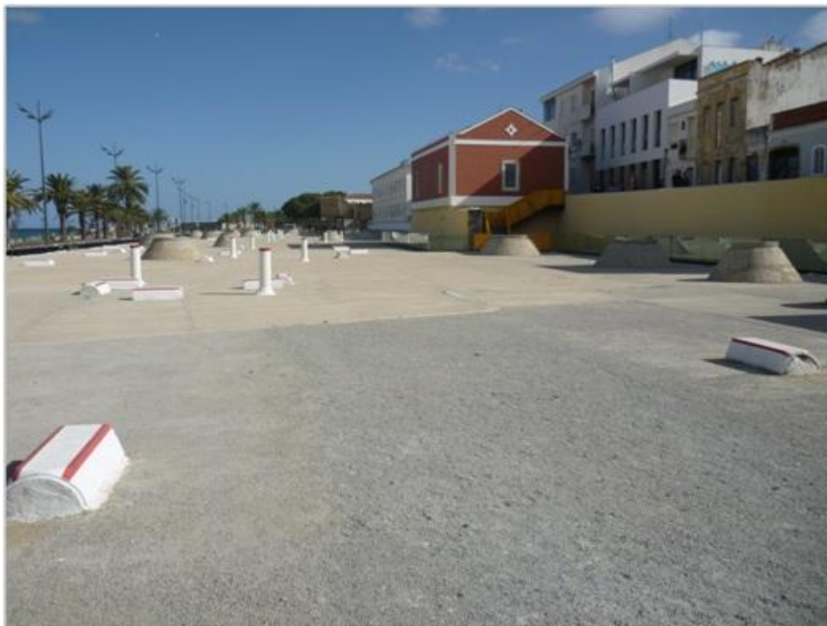
Figura VI. Zona da cobertura depois de terminada sem os arranjos exteriores.
