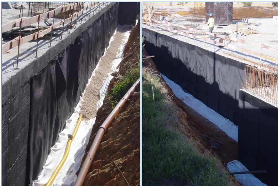
Figura 28. Sistema drenante/filtrante aplicado na base dos muros.
