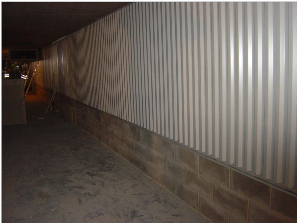
Figura 17. Zona da caleira após colocação das chapas perfiladas caneladas no piso -2.
