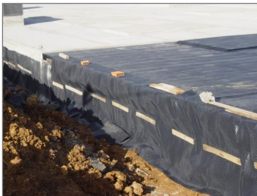
Figura 25. Recolocação dos painéis de drenagem.
