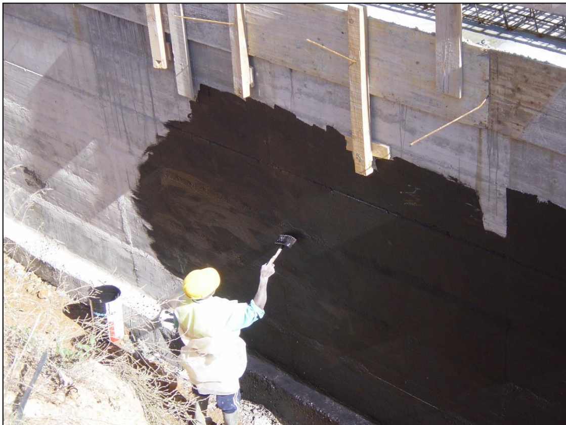
Figura 21. Aplicação da primeira demão no sentido horizontal.
