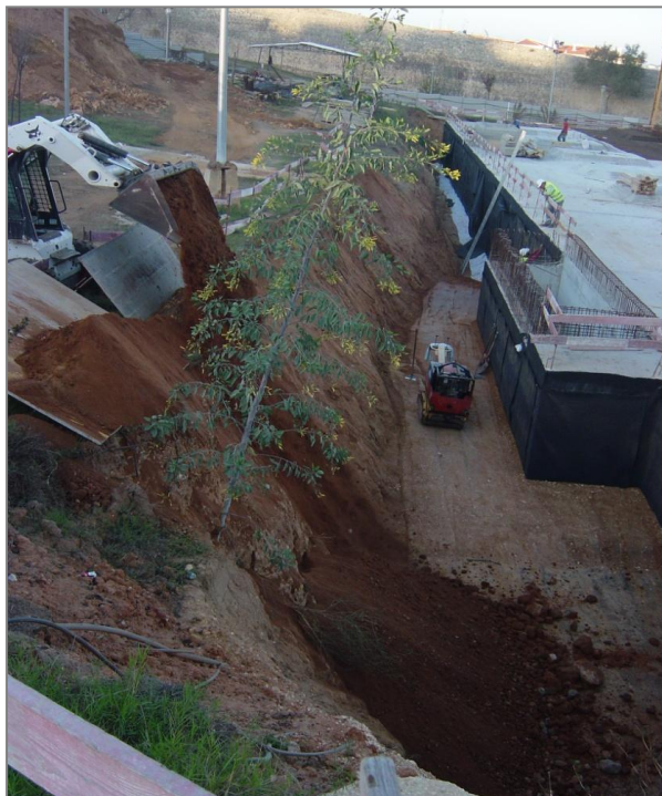
Figura 24. Fase de aterro e compactação por camadas.
