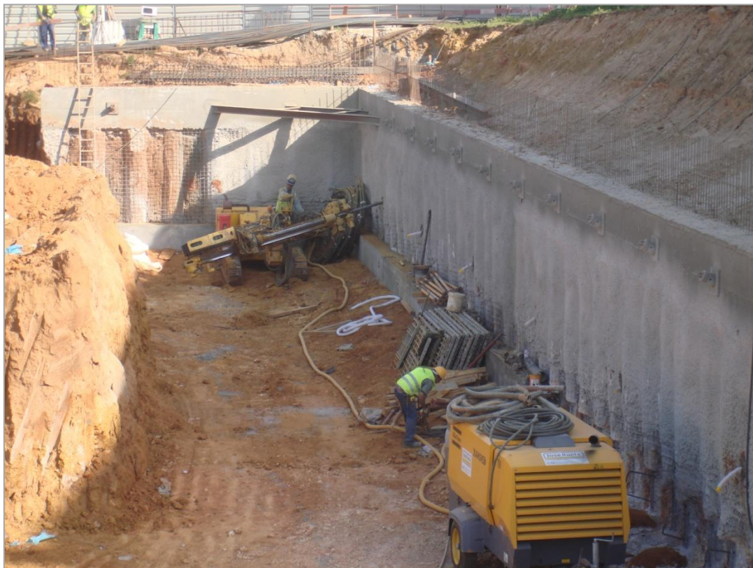
Figura 6. Aplicação em obra dos drenos sub-horizontais.
