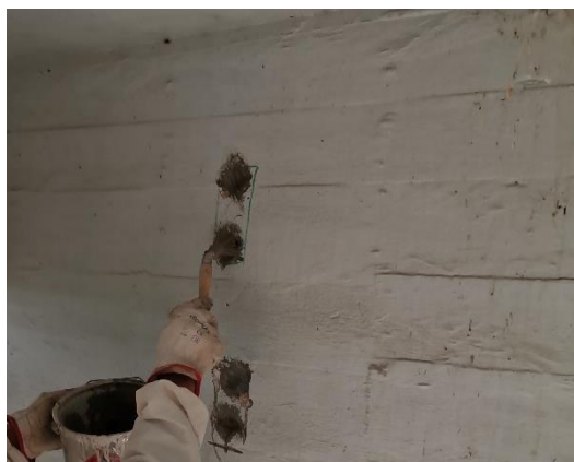
Figura 5-17 Aplicação de Sikatop Armatec-110 EpoCem.
