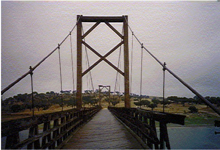
Figura 3-1 Ponte de Ervedal com tabuleiro em madeira.(Ferraz et al., 2002)
