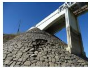
A - REPARAÇÃO DE TALUDES REVESTIDOS A PEDRA ARRUMADA
