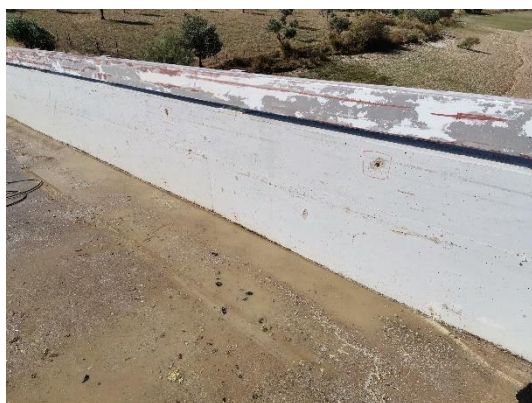
Figura 5-13 Identificação e Delimitação de zonas a serem reparadas.
