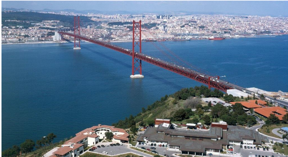
Figura 1-7 Ponte 25 de abril, Lisboa.(TEIXEIRA DUARTE SA, 2020)
