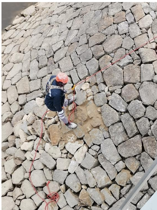
Figura 5-9 Restabelecimento de taludes.
