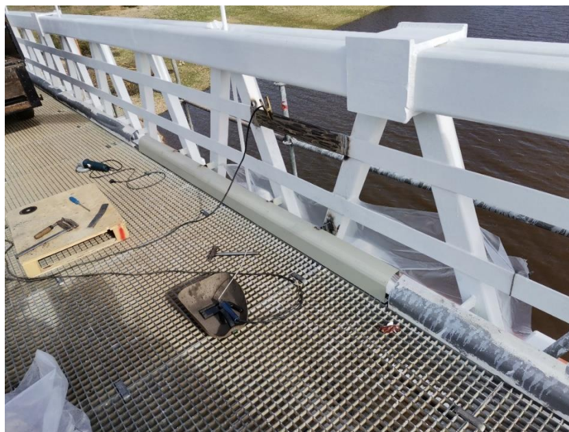
Figura 5-48 Elementos já substituídos.
