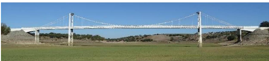
Figura 3-6 Vista geral (2019)(Edgar Cardoso - Engenharia e Laboratório de Estruturas, 2020)
