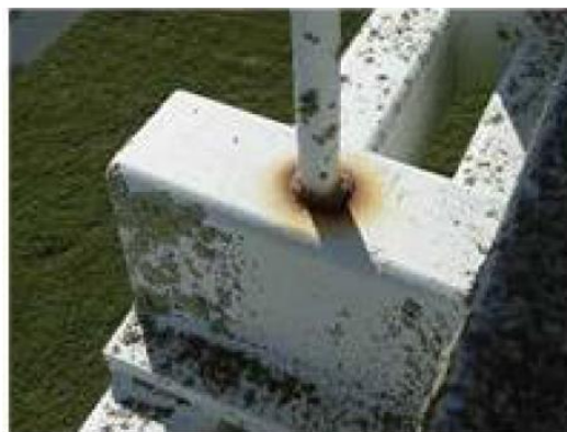
Figura 3-34 e 3-35 Indícios de corrosão pontual nas ligações dos pendurais ao tabuleiro (Edgar Cardoso - Engenharia e Laboratório de Estruturas, 2020).
