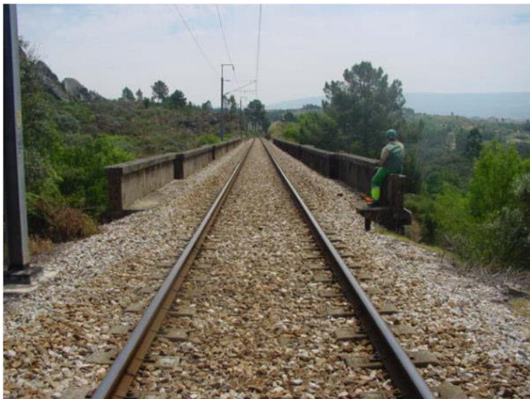
Figura 2-71 Guarda corpos em alvenaria. (Lopes, 2016)
