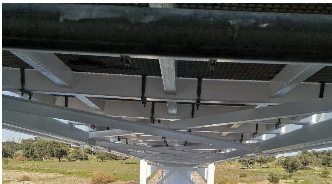
Figura 5-58 Tabuleiro montado e devidamente fixo.
