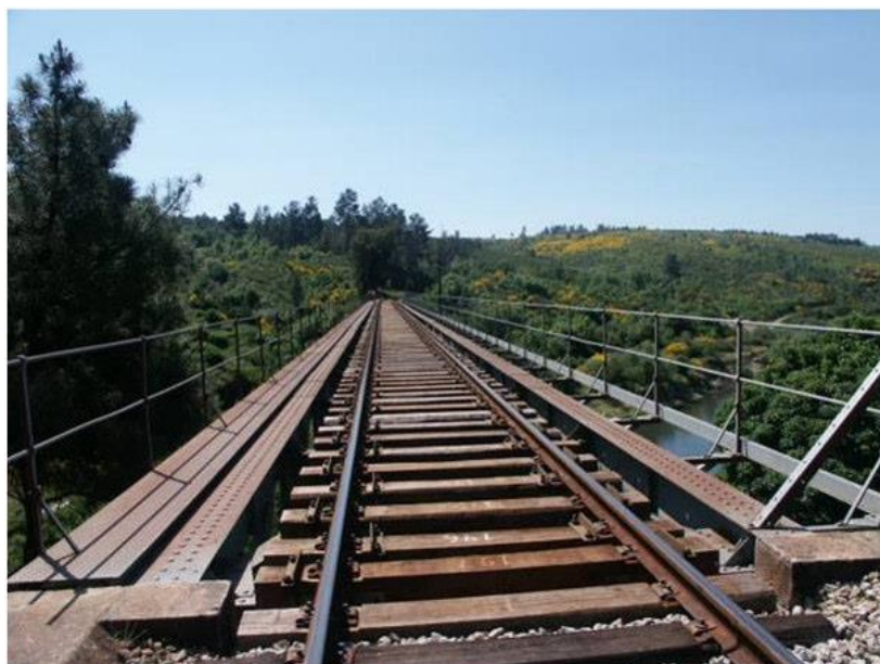
Figura 2-69 Passeio de inspeção. (Lopes, 2016)
