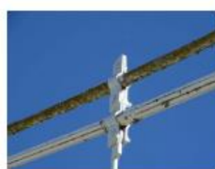
G - LIMPEZA E PINTURA DOS CABOS PRINCIPAIS
