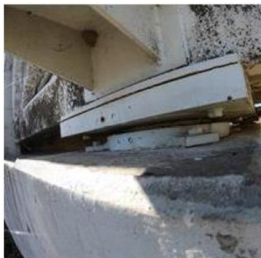
Figura 3-15 Aparelho de apoio existente. (Edgar Cardoso - Engenharia e Laboratório de Estruturas, 2020)
