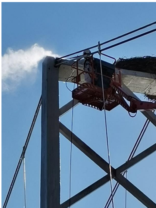
Figura 5-11 Lavagem do pilar.
