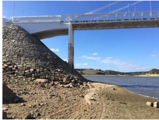
Figura 3-13 Vista geral do Encontro de Ervedal. (2020) (cedido por SLM)
