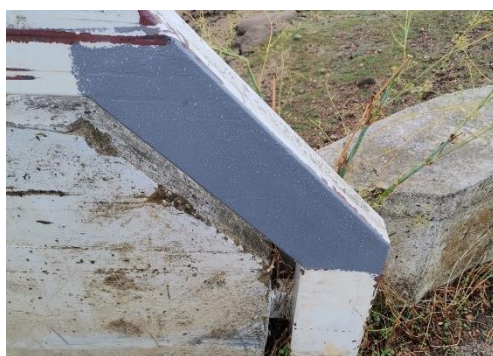
Figura 5-34 Tinta com 48 horas de cura.
