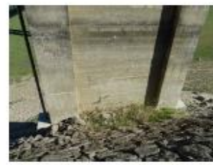
B - LIMPEZA E DESMATAÇÃO DE TALUDES
