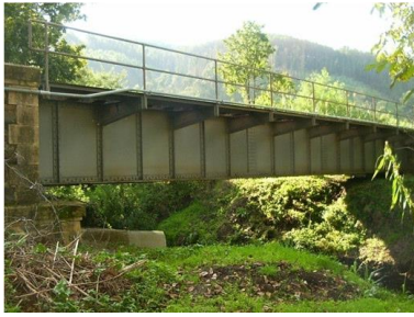
Figura 2-60 Viga de alma cheia. (Lopes, 2016)
