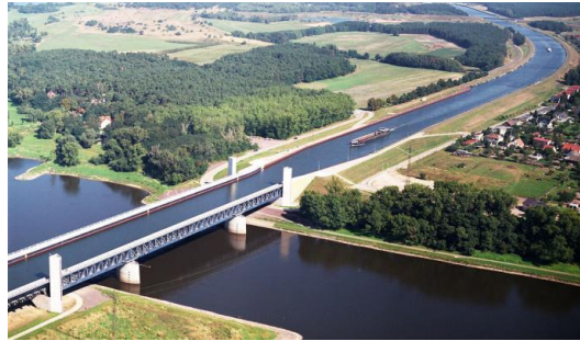
Figura 2-6 Ponte – canal sobre o Rio Elba (Alemanha) (Wittfoht, 2015)
