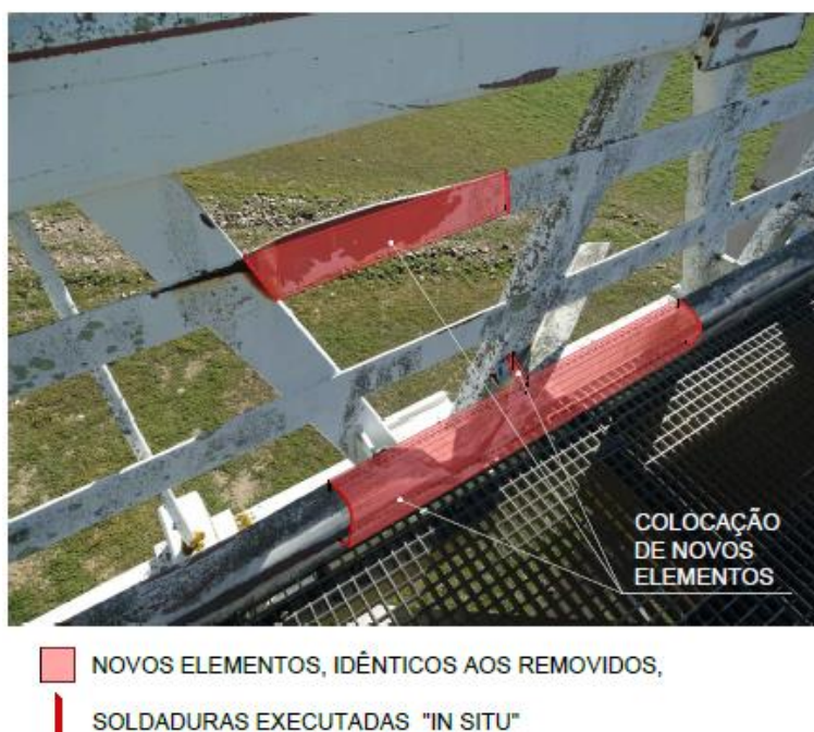
Figura 5-47 Pormenor dos elementos metálicos a substituir. (Edgar Cardoso - Engenharia e laboratório de estruturas, 2020)
