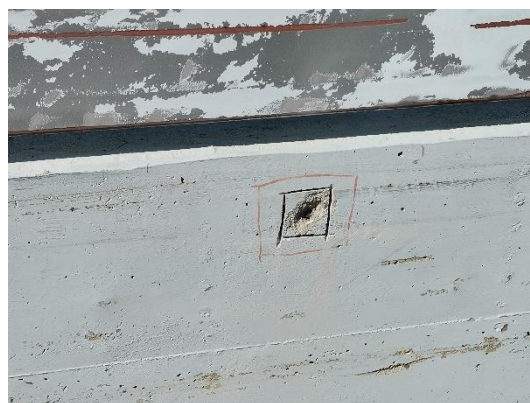
Figura 5-14 Delimitação através de corte.
