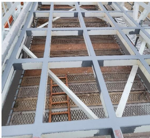
Figura 5-41 Primário de alumínio aplicado.
