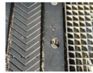
D - LIMPEZA DA JUNTA DE DILATAÇÃO, VERIFICAÇÃO DE APERTO E SUBSTITUIÇÃO DE TAMPAS DAS RESPECTIVAS FIXAÇÕES
