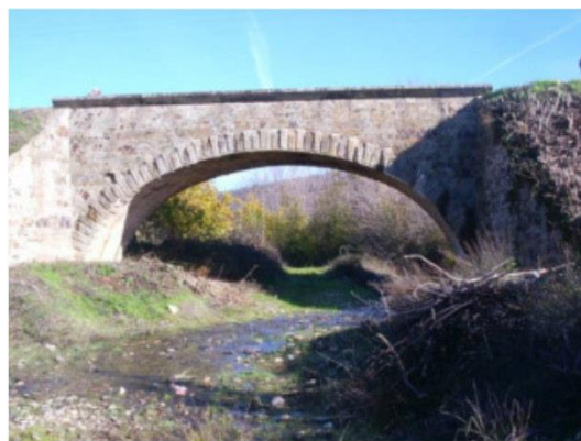
Figura 2-27 Muro tímpano (Lopes, 2016)
