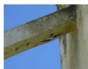
H - REPARAÇÃO DO BETÃO EM PROFUNDIDADE
