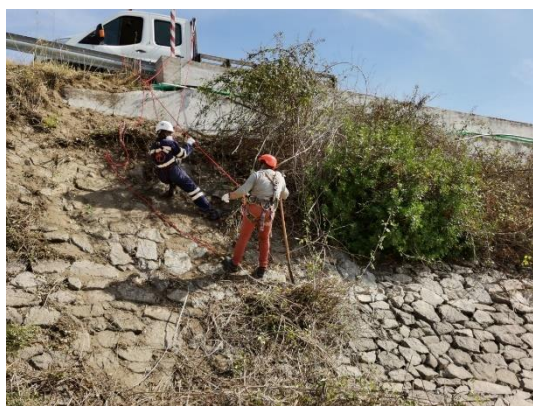
Figura 5-7 Limpeza de taludes
