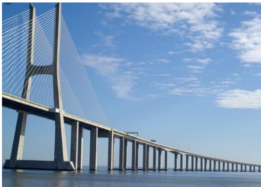
Figura 1-8 Ponte Vasco da Gama, Lisboa. (cedido por SLM)
