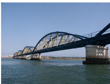
Figura 2-66 Viga Pratt (N) Parabólica (Lopes, 2016)
