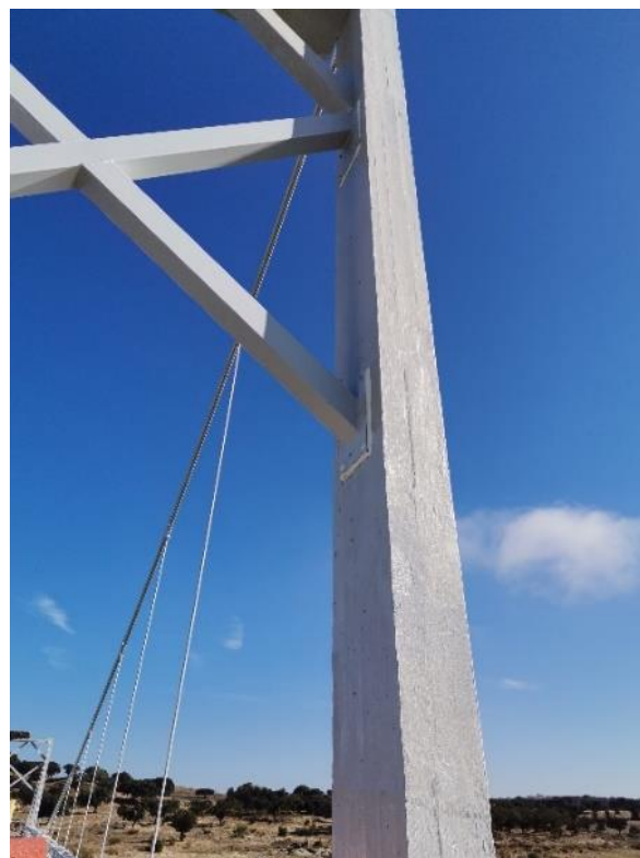
Figura 3-11 Contraventamento metálico no pilar do lado de Ervedal. (cedido por SLM)
