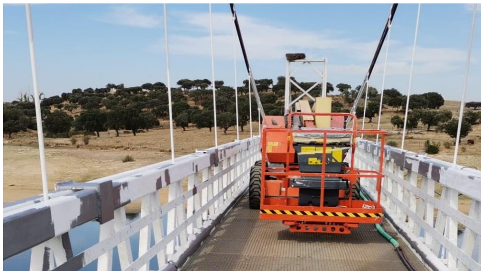
Figura 5-3 Plataforma elevatória utilizada nos trabalhos acima do tabuleiro
