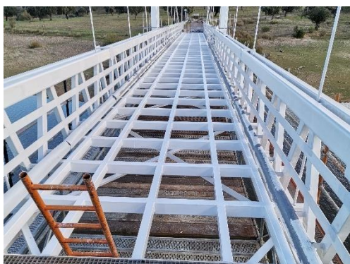
Figura 5-43 Suporte do tabuleiro já concluído a nível de pintura.
