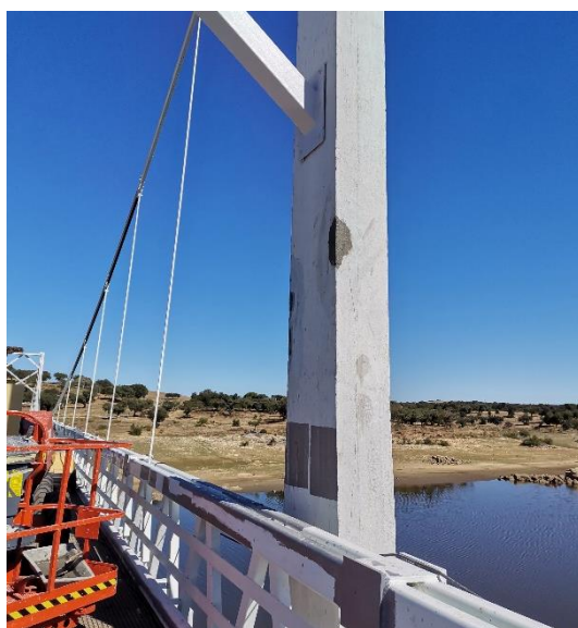
Figura 5-20 Superfície talochada e esponjada.
