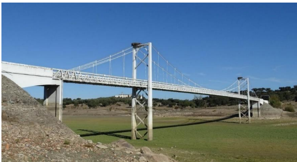
Figura 1-1 Ponte de Ervedal. (Edgar Cardoso - Engenharia e Laboratório de Estruturas, 2020)
