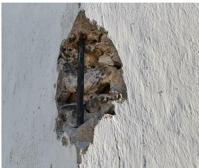
Figura 5-15 Varão de armadura limpo através de escovagem mecânica
