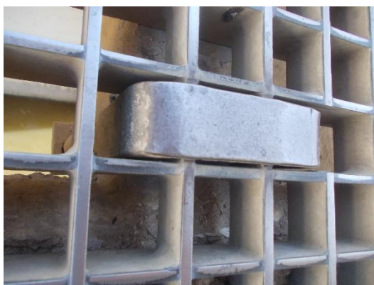
Figura 3-33 Fixações do gradil com folga (cedido por SLM)
