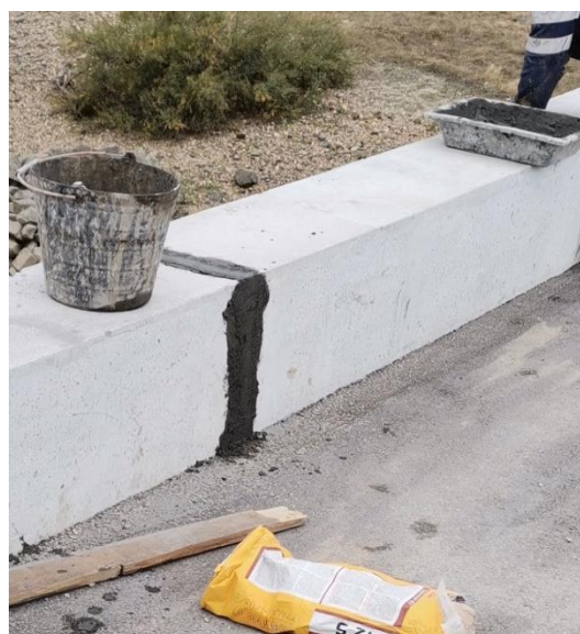
Figura 5-21 Aplicação manual de Sika Monotop 412 S.
