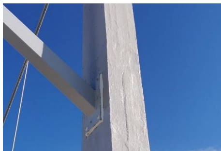
Figura 5-26 Juntas seladas.
