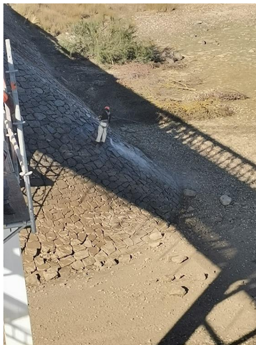
Figura 5-10 Lavagem dos taludes.
