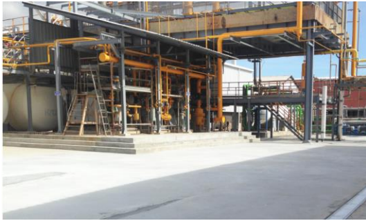
Figura 1-4 Central compressor de hidrogénio parcialmente rehabilitada. (SLM, 2015a)
