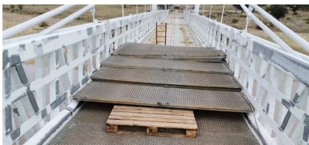
Figura 5-37 Gradis de tabuleiro da fase 1 acondicionados.
