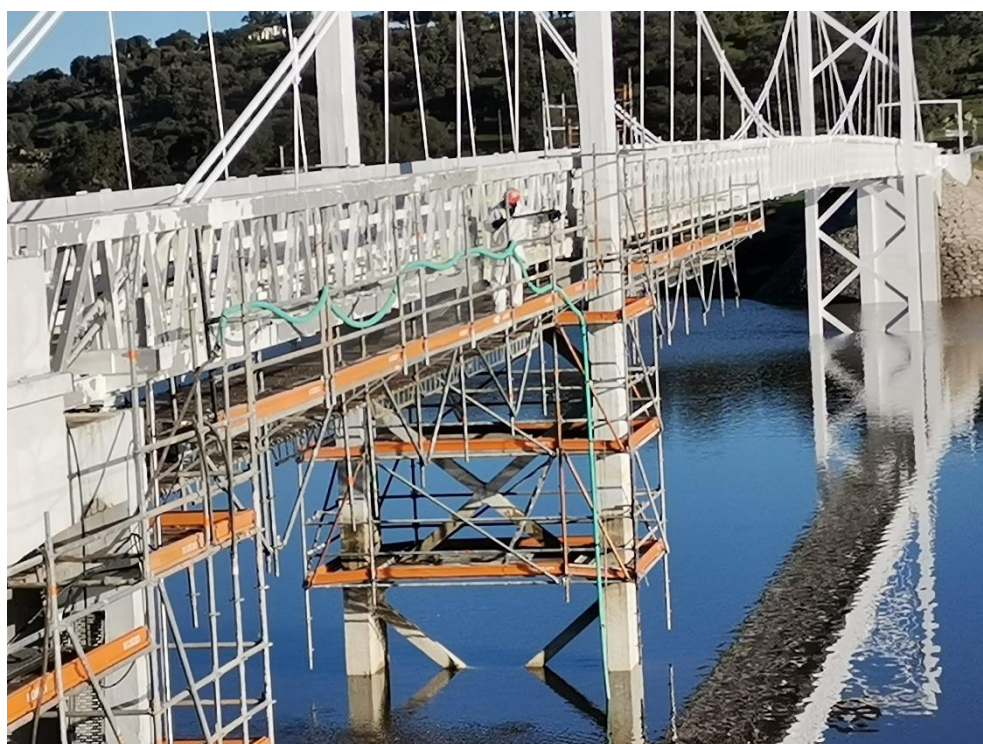
Figura 5-6 Meios de acesso montados na 3ª fase.
