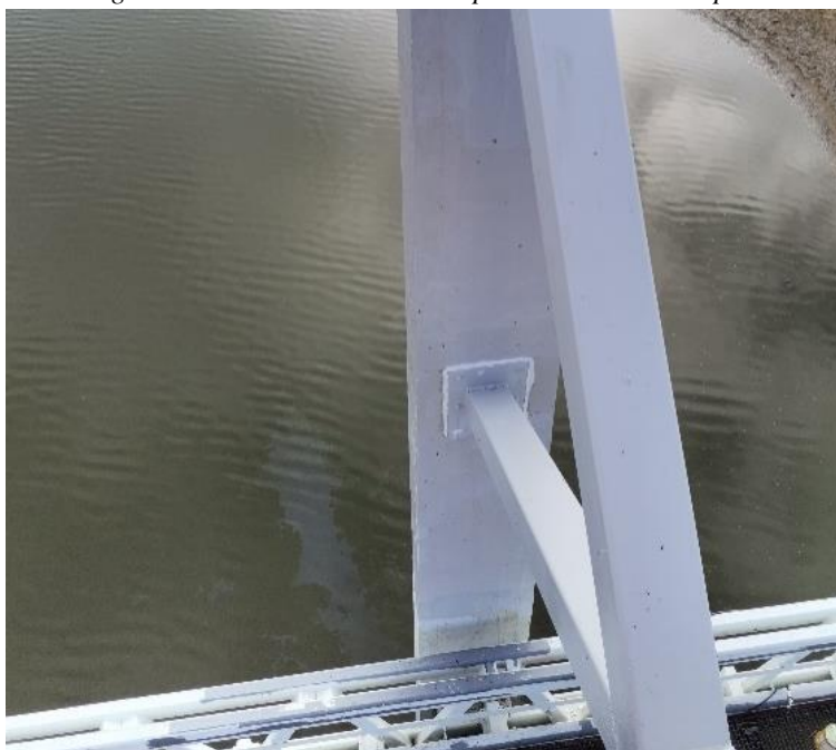
Figura 5-28 Preenchimento completo com a resina epóxi.
