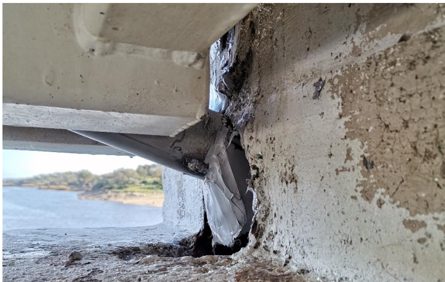
Figura 5-57 Selagem dos cabos nos encontros.
