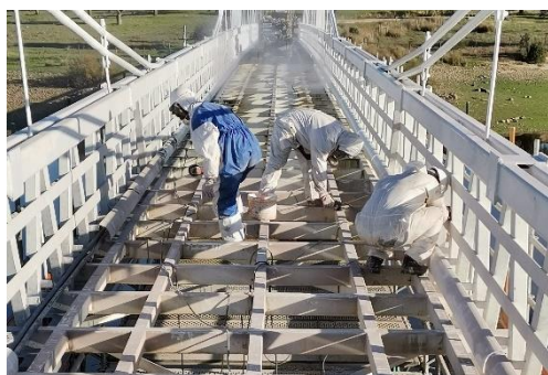
Figura 5-39 Colaboradores na preparação de superfície.
