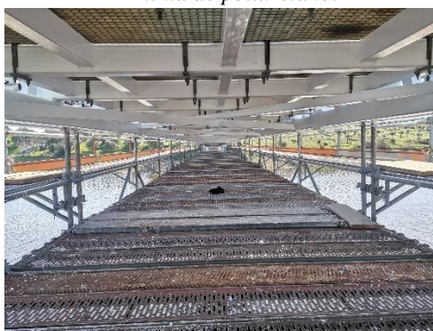
Figura 5-44 Vista inferior do tabuleiro já montado.
