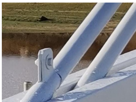
Figura 5-53 Bainha em meia cana de proteção dos cabos principais reparada.
