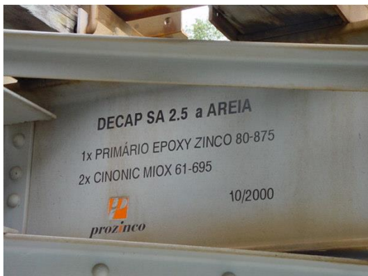
Figura 2-74 Proteção anti corrosiva de elementos metálicos. (Lopes, 2016)
