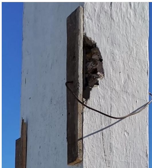
Figura 5-18 Zona a reparar com auxílio de cofragem.
