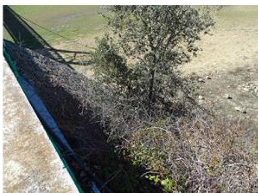
Figura 3-16 Vegetação existente na zona do encontro de Figueira de Barros (Edgar Cardoso - Engenharia e Laboratório de Estruturas, 2020)
