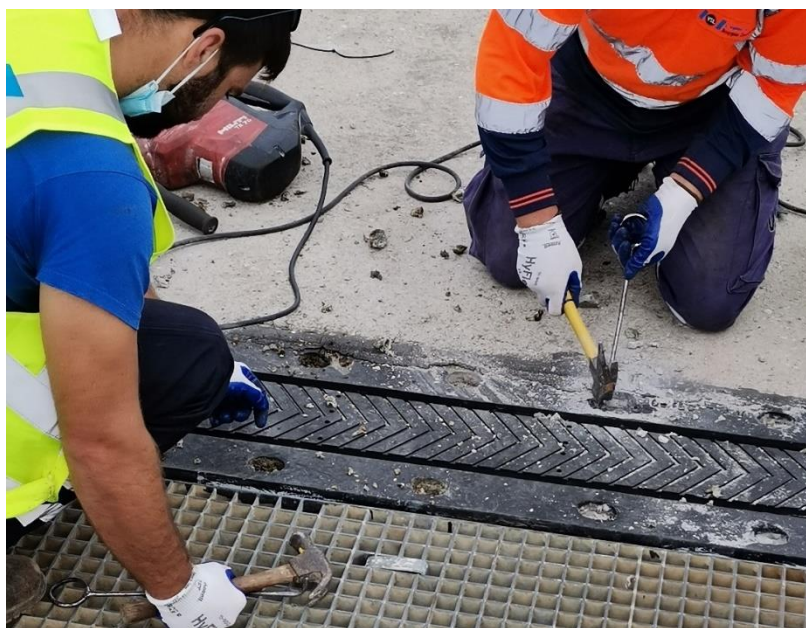
Figura 5-66 Remoção da argamassa de preenchimento das cavidades de aperto.
