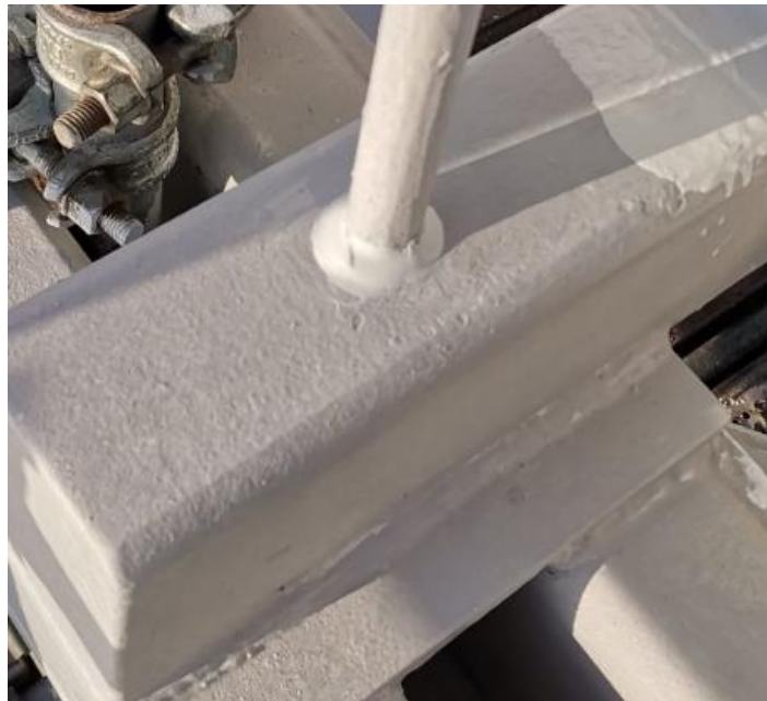
Figura 5-70 Pendural selado com mástique branco.
