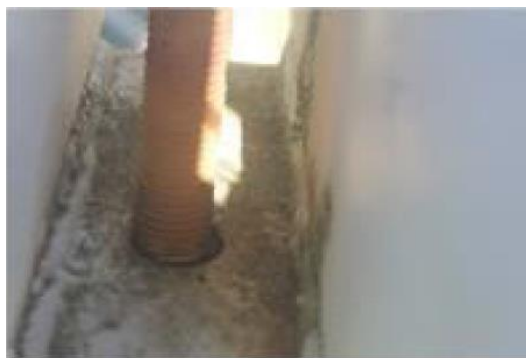
Figura 3-34 e 3-35 Indícios de corrosão pontual nas ligações dos pendurais ao tabuleiro (Edgar Cardoso - Engenharia e Laboratório de Estruturas, 2020).
