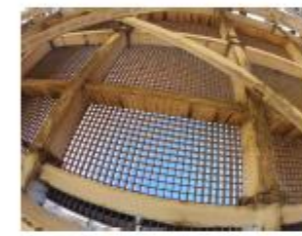
E - LIMPEZA E PINTURA DE SUPERFÍCIES METÁLICAS E REAPERTO DAS FIXAÇÕES DO PAVIMENTO AO TABULEIRO
