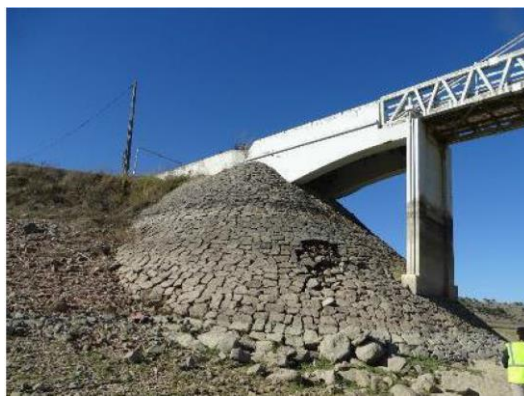
Figura 3-17 Encontro de Ervedal com talude em pedra com algumas deficiências (Edgar Cardoso - Engenharia e Laboratório de Estruturas, 2020) .
