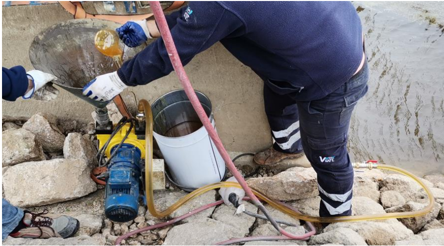
Figura 5-63 Remoção do material com auxílio da máquina de injeção invertida.
