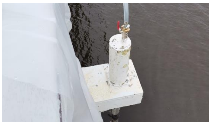
Figura 5-62 Utilização de ar comprimido para expulsar ao material de injeção.
