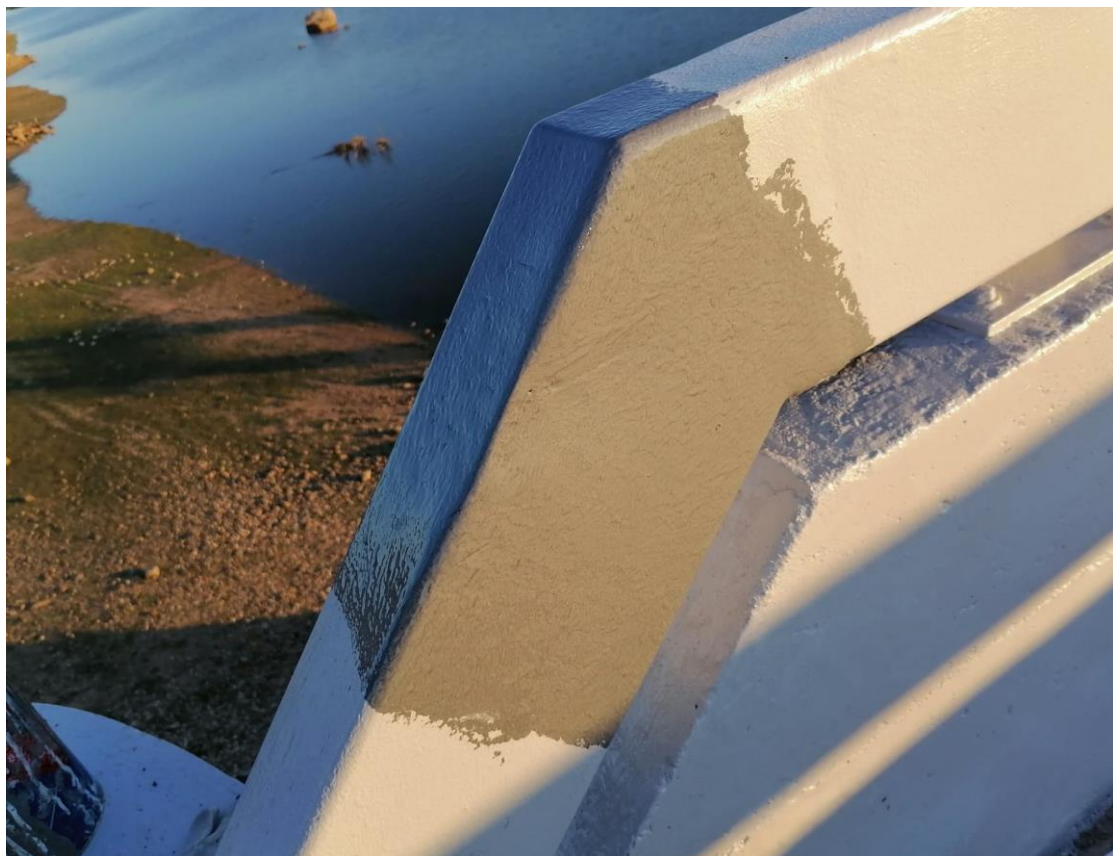
Figura 5-54 Reparação com primário de alumínio aplicado.
