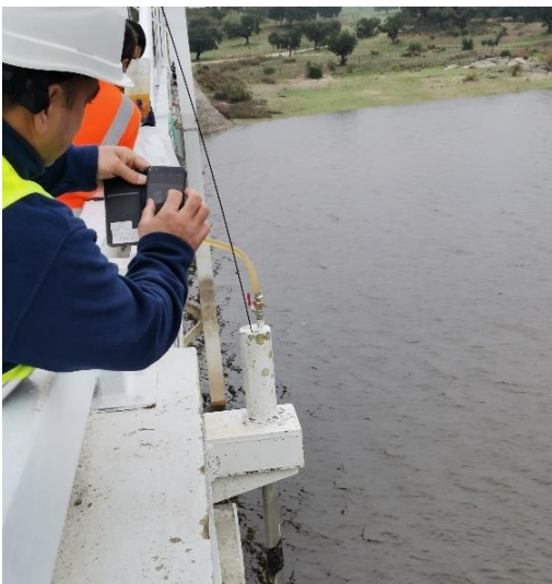
Figura 5-64 Aplicação do material de injeção do tirante.
