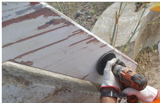
Figura 5-32 Teste de preparação de superfície através de meios mecânicos.
