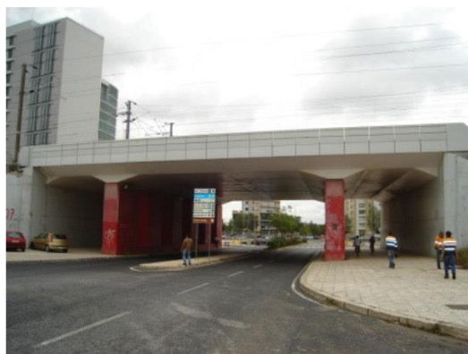
Figura 2-75 Pintura de elementos de betão. (Lopes, 2016)
