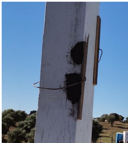
Figura 5-19 Aplicação manual Sika Monotop 412 S de com auxílio de cofragem.
