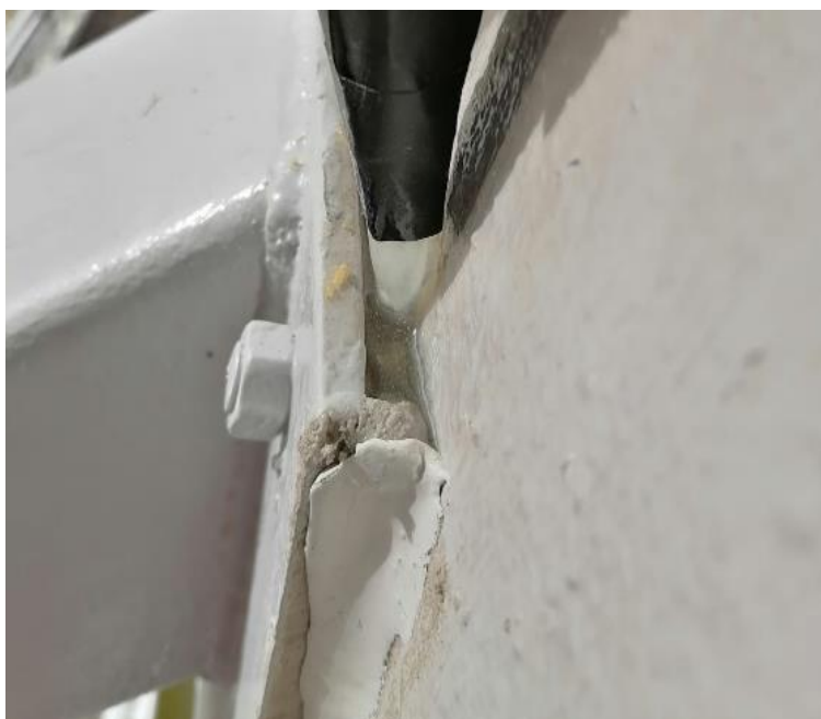
Figura 5-28 Preenchimento completo com a resina epóxi.
