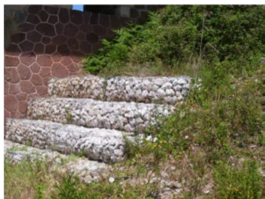
Figura 2-26 Muros de contenção (Lopes, 2016)
