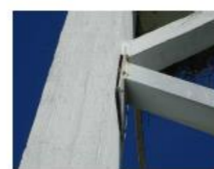
J - REPARAÇÃO DA LIGAÇÃO ENTRE AS CHAPAS DOS CONTRAVENTAMENTOS METÁLICOS E OS PILARES
