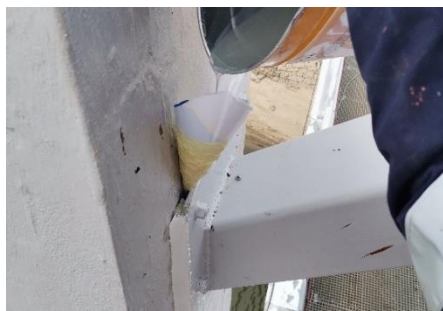
Figura 5-27 Aplicação da resina epóxi sikadur-52 Injection.
