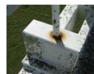
K - SELAGEM DAS FIXAÇÕES DOS PENDURAIS
