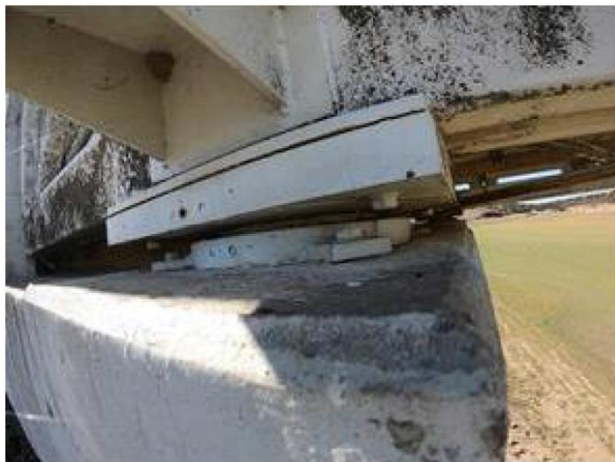
Figura 3-38 Aparelhos de Apoio (Edgar Cardoso - Engenharia e Laboratório de Estruturas, 2020)..
