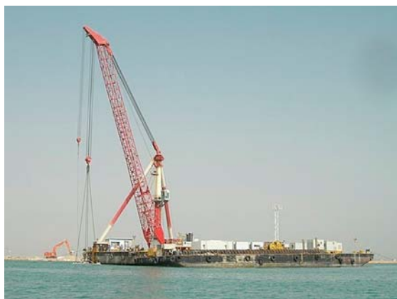
Figura 3-56 – Guindaste em plataforma [40]
