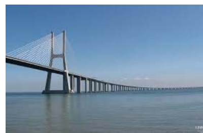
Figura 3-13 – Ponte Vasco da Gama [28]
