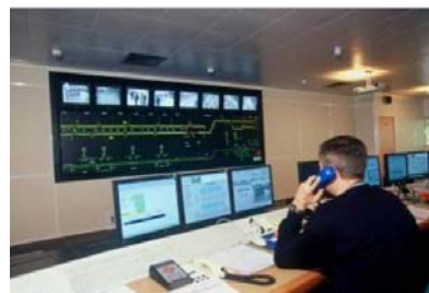
Figura 3-89 – Posto de Comando Central [43]
