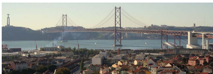
Figura 3-12 – Ponte 25 de Abril [27]
