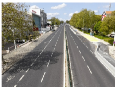
Figura 3-25 – Av a . Marechal Gomes da Costa (Nascente / Poente)
