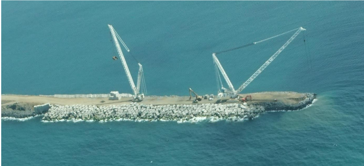
Figura 11 - Disposição aplicada no extradorso na “2.ª Fase de ampliação do Molhe Leste do Porto de Sines”.
