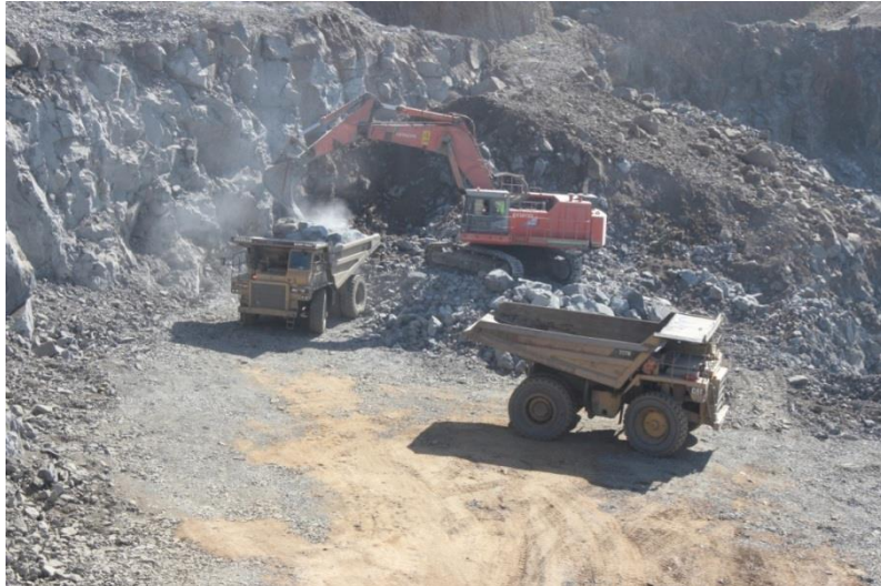
Figura 25 - Dumpers modelo CAT 775/B carregamento de enrocamento.
