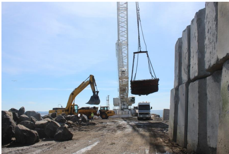
Figura 26 - Pesagem e deposição de enrocamento com auxílio de Grua Liebherr LR 11350 com caçamba.
