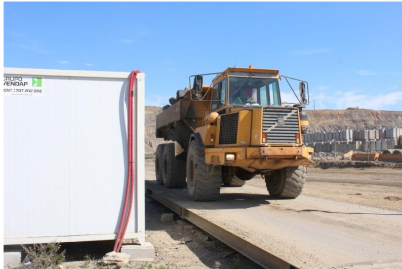
Figura 23 - Pesagem de enrocamento com recurso a báscula-ponte.
