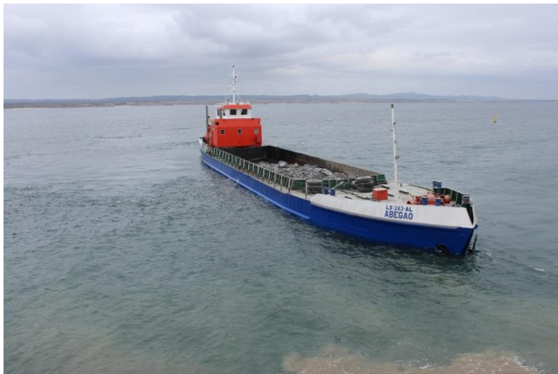
Figura 28 - Deposição de enrocamento no Molhe Leste de Sines, via marítima.
