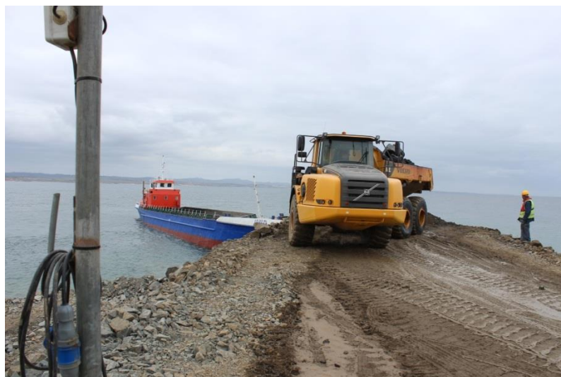
Figura 24 - Deposição de enrocamento, via terrestre.
