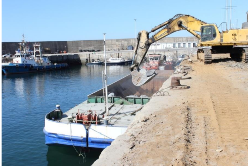
Figura 27 - Trásfega de enrocamento para o Batelão, Cais Norte do Porto de Sines.
