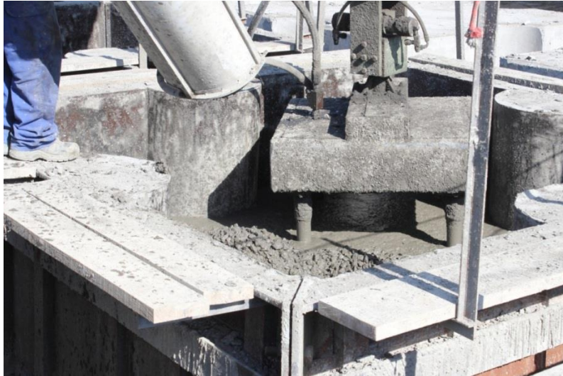
Figura 31 - Betonagem e vibração do bloco Antifer.
