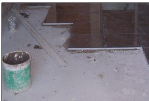
Fig. 33 – Assentamento de pedra azulino Cascais polida através de adesivo de cor cinza
