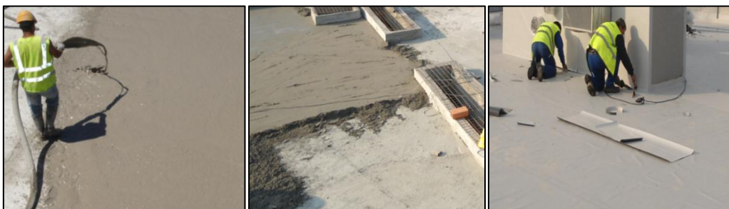
Fig. 32 – Aplicação de betão celular, betonilha e tela impermeabilizante (PVC)
