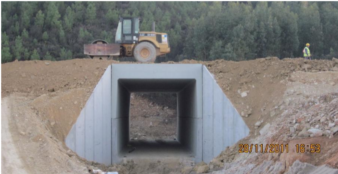
Box-culvert já montada e aterrada.
