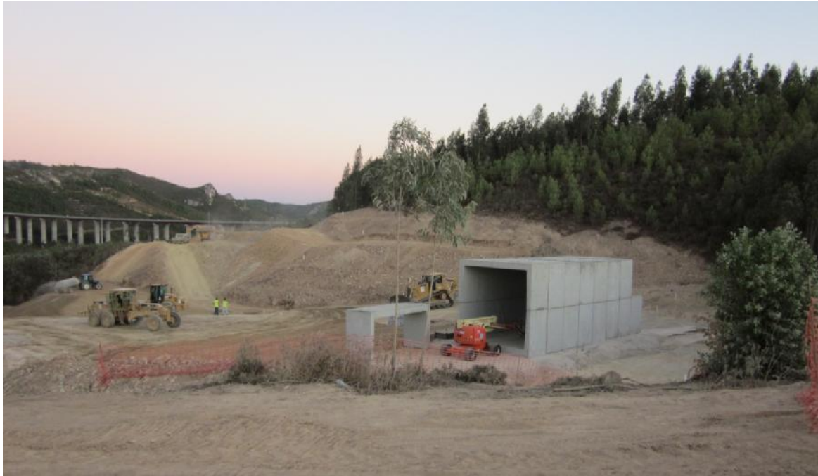
Montagem / colocação das box-culvert.
