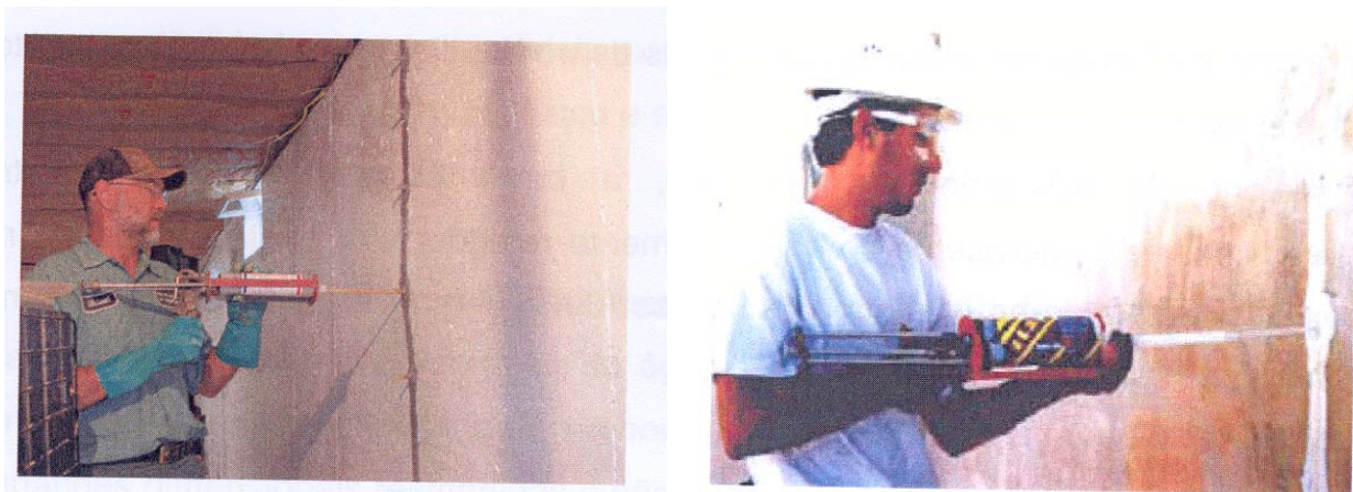
Figura 63 – Injecção de resinas de preenchimento na reparação de fendas [38]
