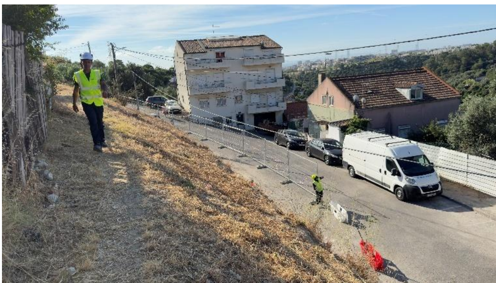
Figura 3 – Vedação tipo Bekaert e PMP, para acesso de veículos
