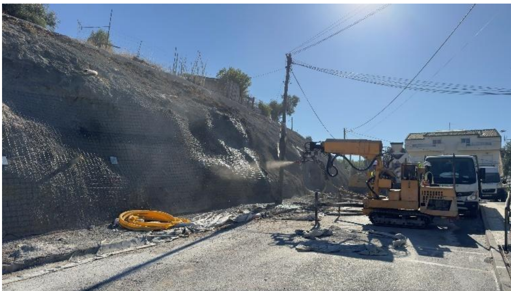
Figura 9 – Projeção de betão
