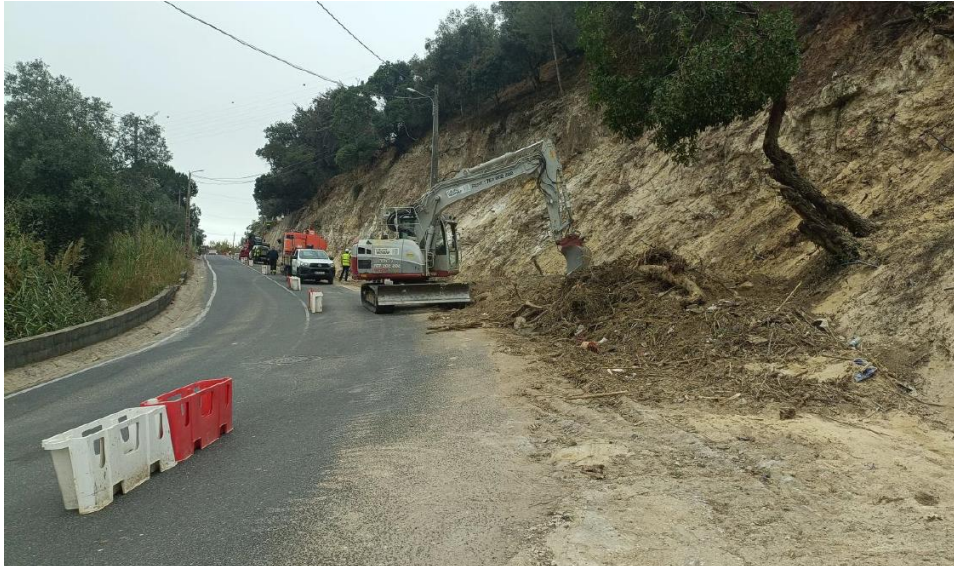
Figura 5 – Remoção de solos de cobertura acumulados na base do talude
