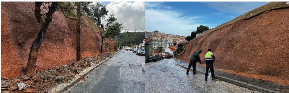
Figura 12 – Execução da limpeza
