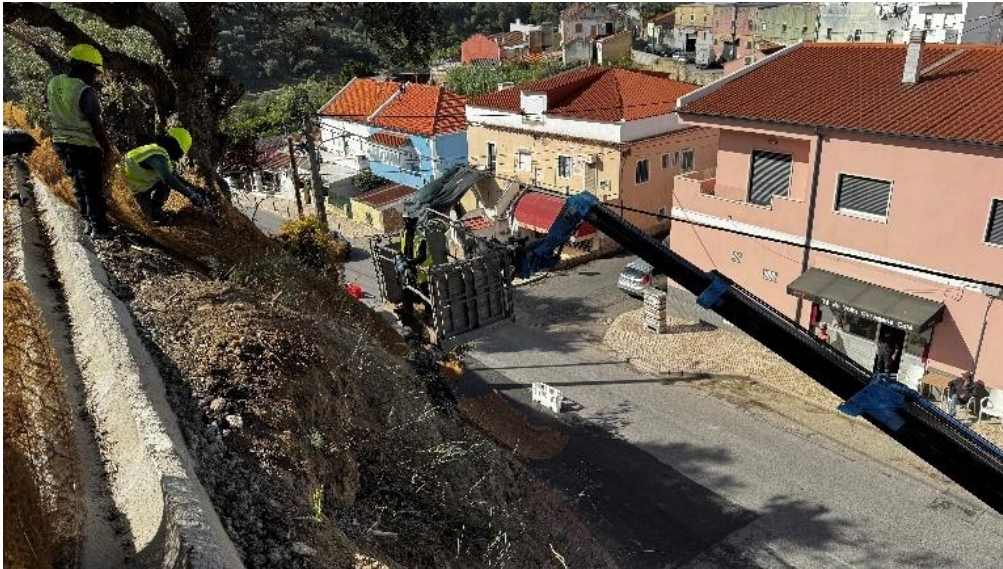
Figura 11 – Colocação da geomanta com apoio de alpinistas e equipamento multifunções
