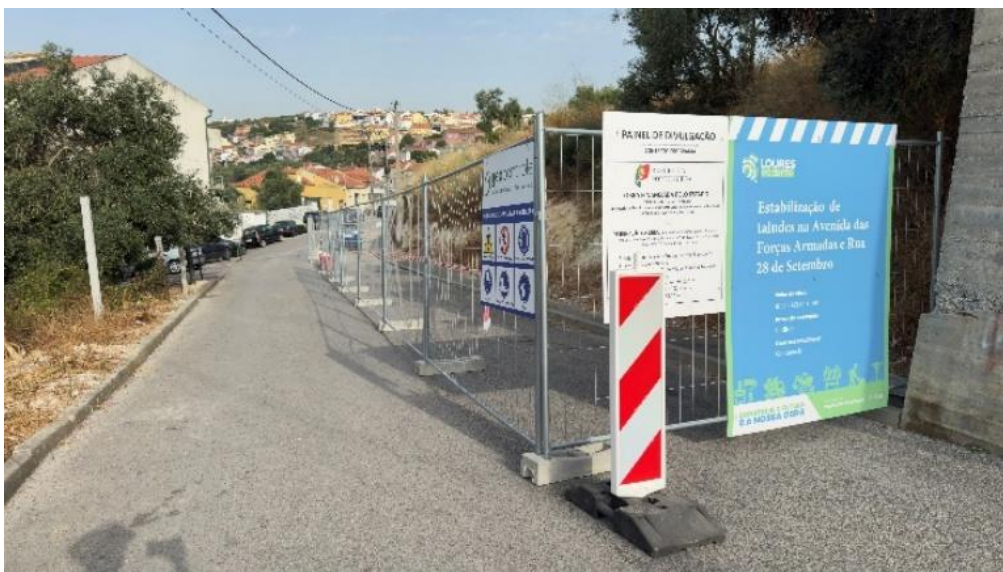
Figura 2 – Vedação tipo Bekaert e sinalização da obra
