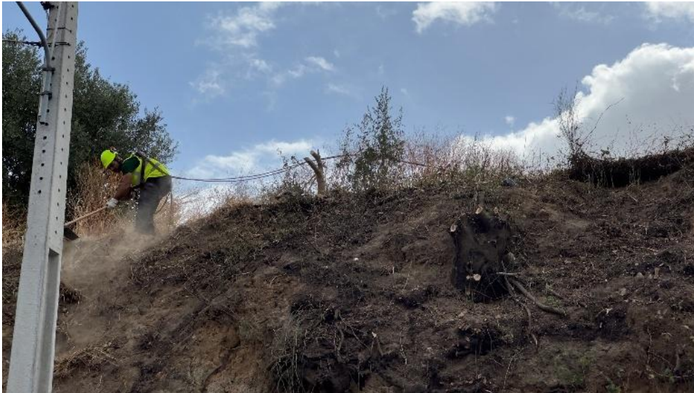
Figura 6 – Execução de desmatamento no topo do talude
