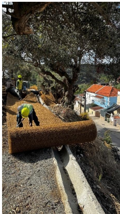
Figura 10 – Abertura da geomanta
