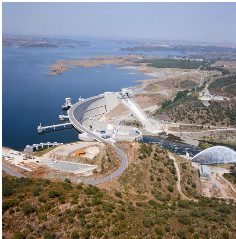
Figura 1.1: Barragem do Alqueva.
