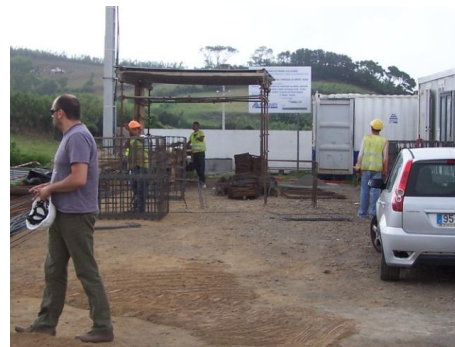
Fig. 3.20 – Área de execução das armaduras
