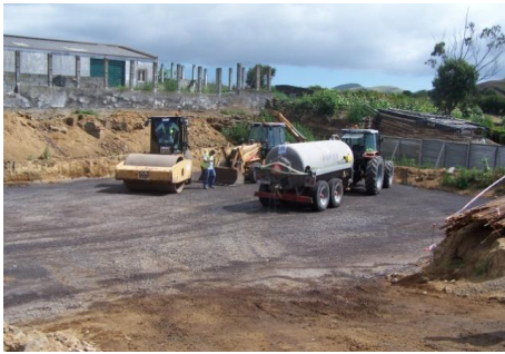
Fig. 3.24 – Aterro, cilindro vibrador, retroescavadora e autotanque
