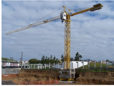
Fig. 3.21 – Grua de torre
