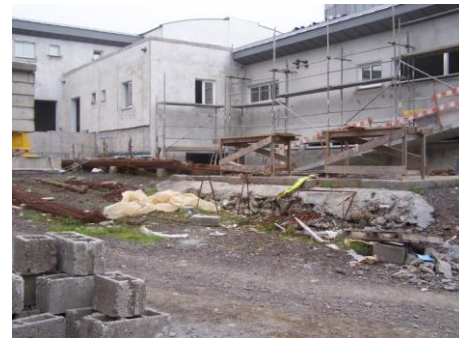
Fig. 2.37 – Área de execução das armaduras
