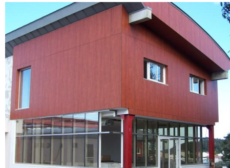
Fig. 2.82 – Fachada ventilada no Alçado Poente
