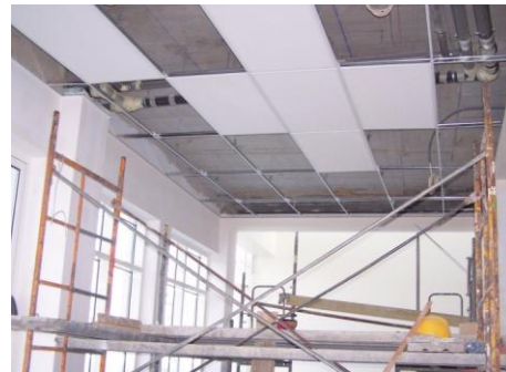
Fig. 2.69 – Execução do tecto falso em painéis de gesso cartonado acústicos
