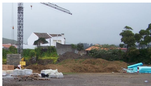
Fig. 2.38 – Material resultante da escavação e posto em depósito no estaleiro
