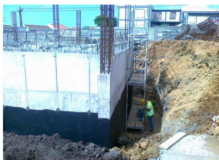
Fig. 3.31 – Impermeabilização da Cave com “ Flintkote ”
