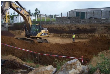
Fig. 3.26 – Escavação de mais 60cm na zona nascente do terreno
