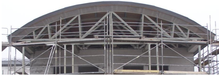
Fig. 2.43 – Asna metálica do Corpo B
