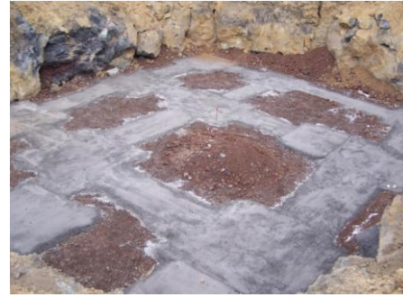
Fig. 3.29 – Betão de limpeza na zona da Cave
