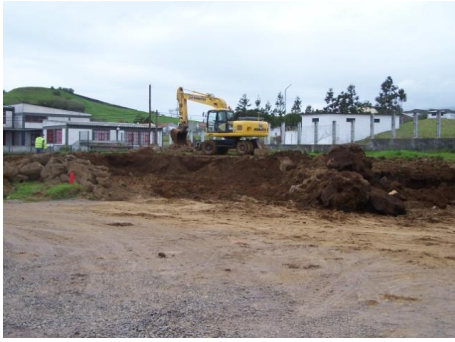
Fig. 3.22 – Escavação com escavadora hidráulica de pneus
