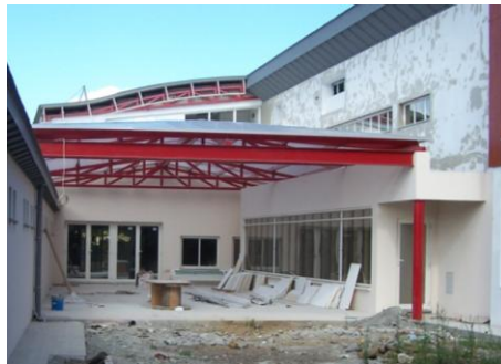
Fig. 2.73 – Estrutura metálica pintada de vermelho
