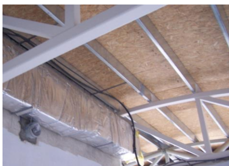
Fig. 2.47 – Chapas de suporte da cobertura
