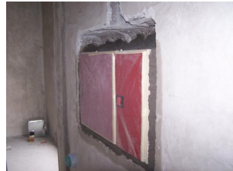
Fig. 2.62 – Equipamento técnico para segurança contra incêndios
