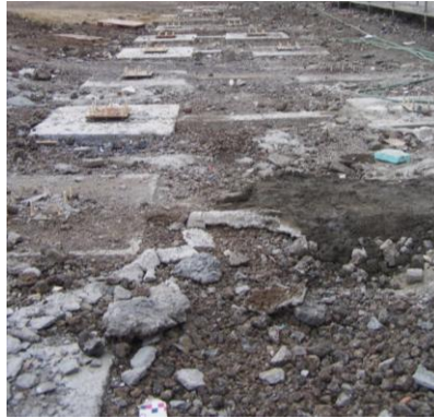
Fig. 2.34 – Sapatas da rampa de acesso e bancada Poente para receber colunas metálicas
