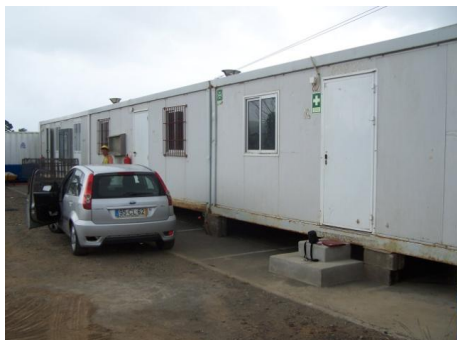
Fig. 3.19 – Contentores do estaleiro
