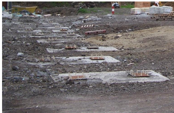
Fig. 2.39 – Sapatas e vigas de fundação
