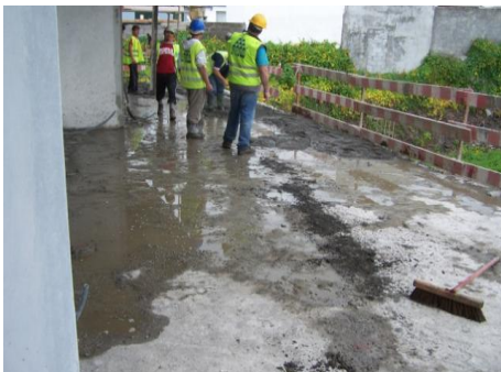
Fig. 2.50 – Execução do betão celular
