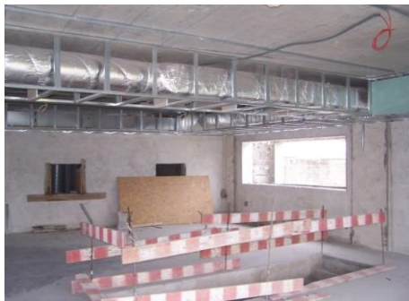
Fig. 2.61 – Rede de AVAC e execução do revestimento
