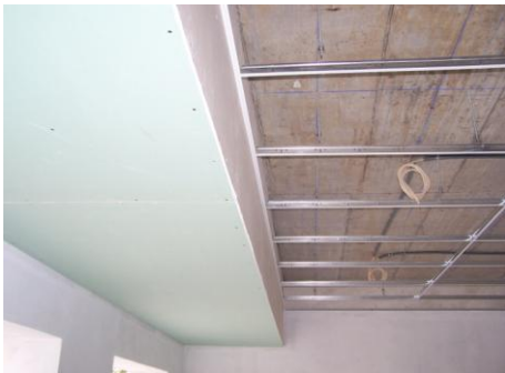
Fig. 2.68 – Tectos falsos em gesso cartonado e estrutura para os painéis acústicos
