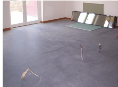
Fig. 2.71 – Pavimento em PVC de cor azulada
