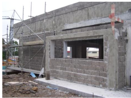
Fig. 2.53 – Alvenarias em blocos de betão leve
