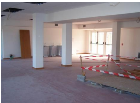
Fig. 2.70 – Pavimento em PVC de cor avermelhada
