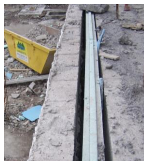
Fig. 2.33 – Junta estrutural entre o Corpo A e B
