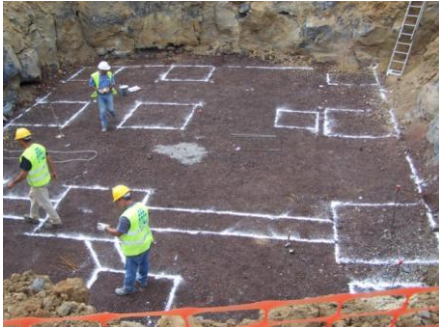
Fig. 3.28 – Marcação das sapatas e vigas de fundação
