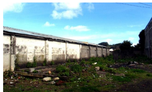
Fig. 2.7 – Armazéns do lado poente da parcela ( Fonte: Processo de licenciamento )
