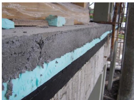
Fig. 2.52 – Aspecto final das camadas da cobertura plana
