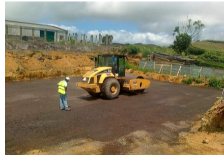
Fig. 3.25 – Compactação dos aterros
