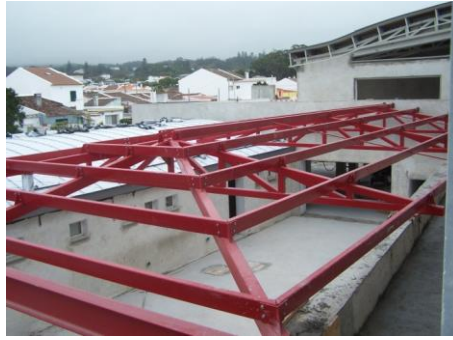
Fig. 2.78 – Estrutura metálica dos ensombramentos
