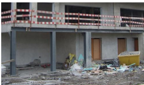
Fig. 2.45 – Pilares e vigas metálicas
