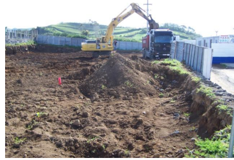
Fig. 3.23 – Escavação e carregamento de camião com escavadora de rastros
