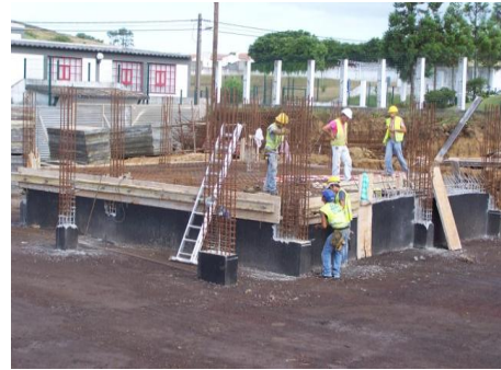
Fig. 3.33 – Montagem das armaduras da laje
