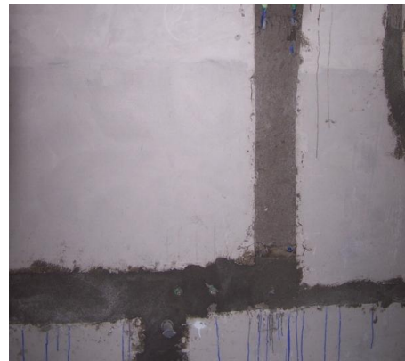
Fig. 2.56 – Roços tapados com argamassa
