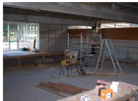
Fig. 2.80 – Execução das carpintarias do anfiteatro
