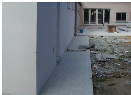
Fig. 2.72 – Pavimentos exteriores em cerâmica
