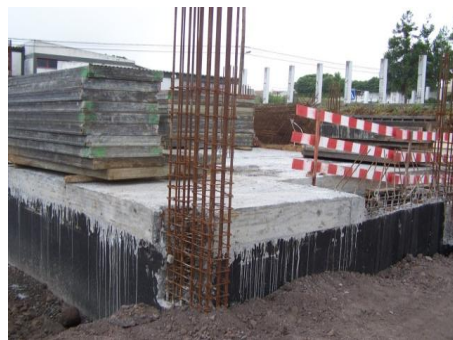
Fig. 3.34 – Estrutura da Cave já executada
