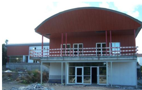
Fig. 2.83 – Fachada ventilada no Alçado Sul
