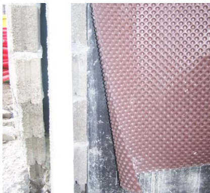
Fig. 2.57 – Impermeabilização da parede de contenção
