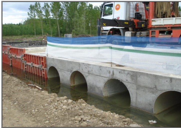
Figura 4 – 2ª fase da construção da travessia do rio Vouga
