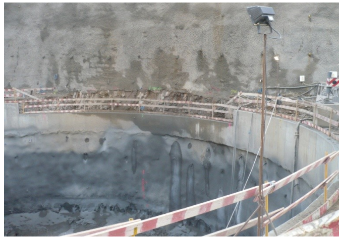
Figura 32 – Viga de bordadura do poço da central
