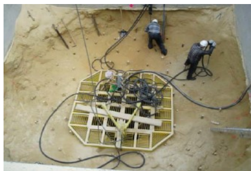
Figura 30 – Proteção da boca da escavação
