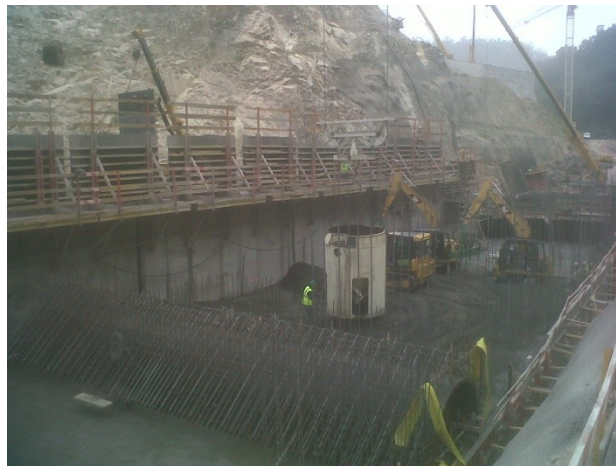
Figura 54 – Descarga do balde de betão
