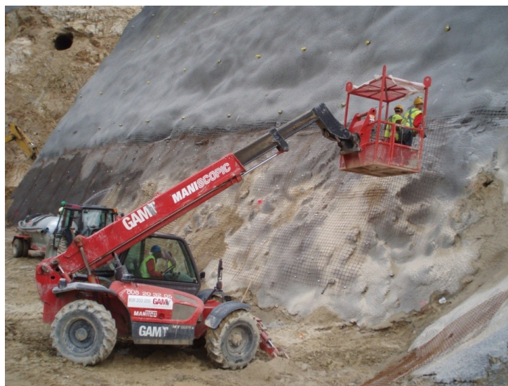
Figura 13 – Colocação de rede malhasol para posterior projeção de betão
