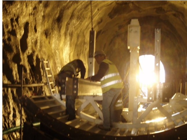
Figura 20 – Montagem do molde
