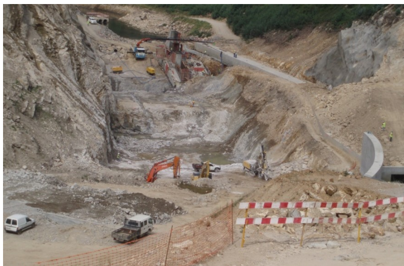
Figura 12 – Escavação da barragem
