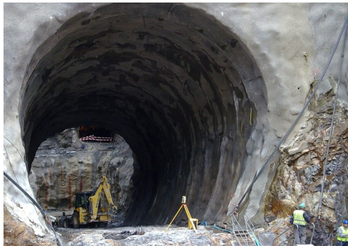
Figura 37 – Galeria de restituição
