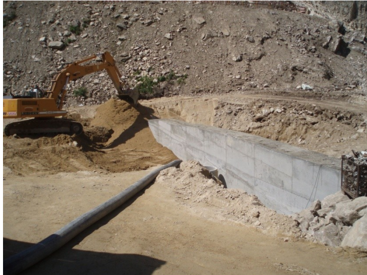
Figura 9 – Muro de betão da enscadeira montante
