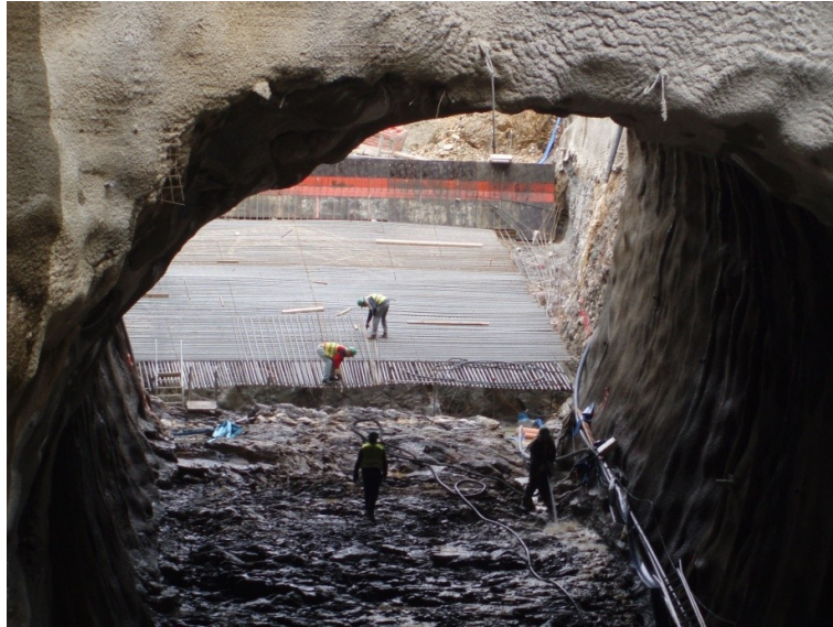
Figura 39 – Armaduras inferiores da soleira da saída da galeria de restituição
