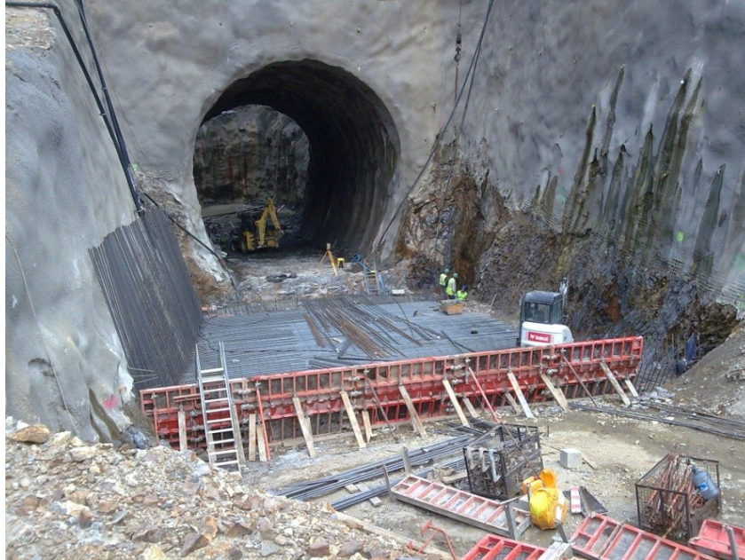
Figura 41 – Cofragem da soleira
