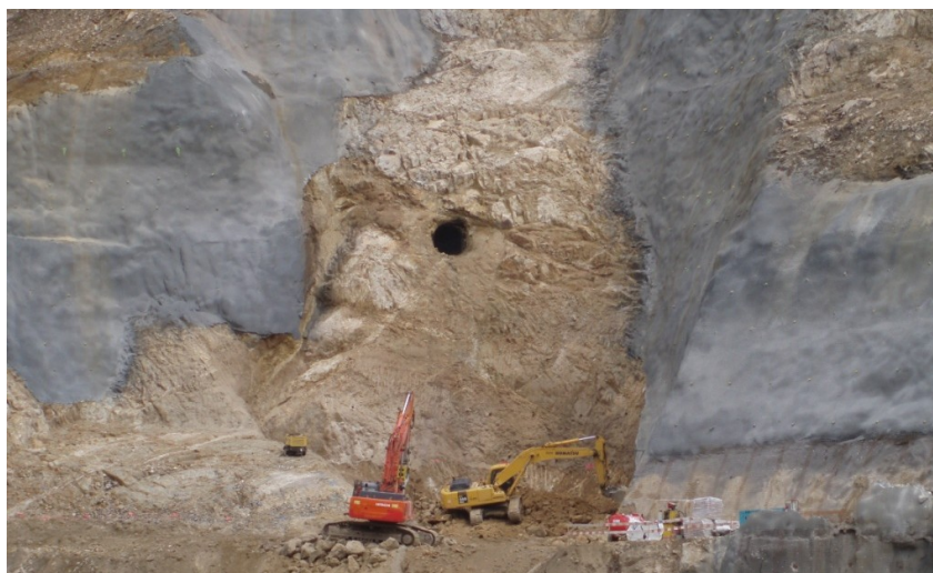
Figura 10 – Escavação da margem direita
