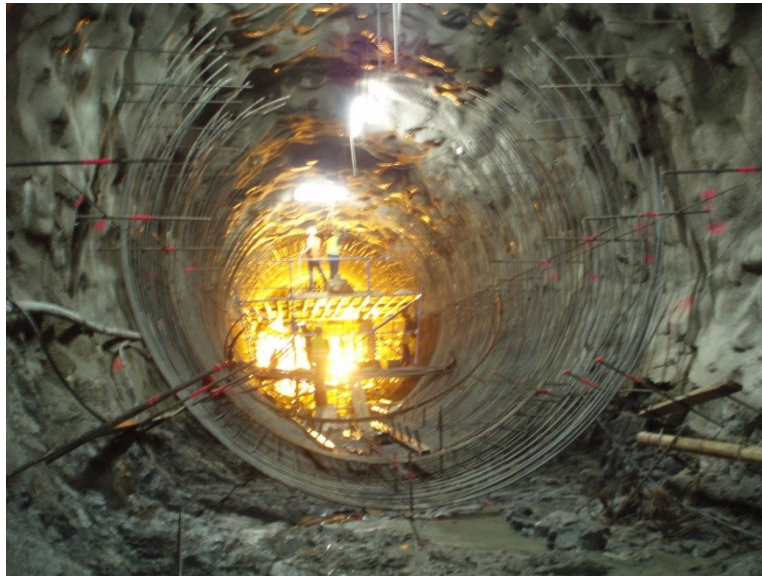
Figura 24 – Montagem das armaduras na galeria de adução
