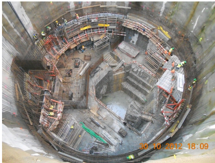
Figura 36 – Cofragem da sapata do poço de drenagem
