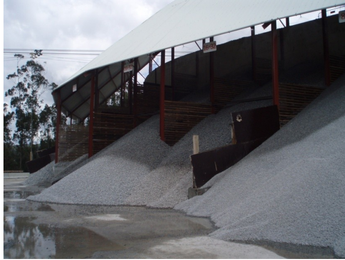
Figura 44 – Stockagem de agregados
