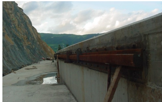
Figura 51 – Escoramento dos carris antes da soldadura
