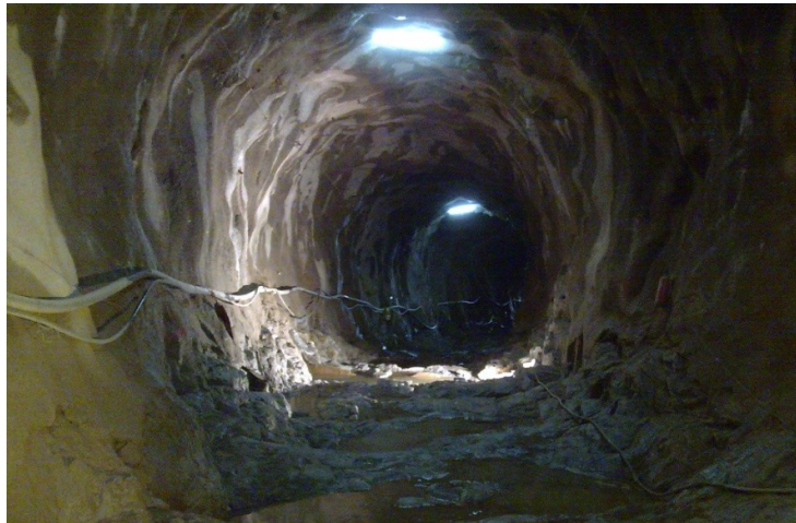
Figura 19 – Secção do túnel depois de aplicado betão projetado
