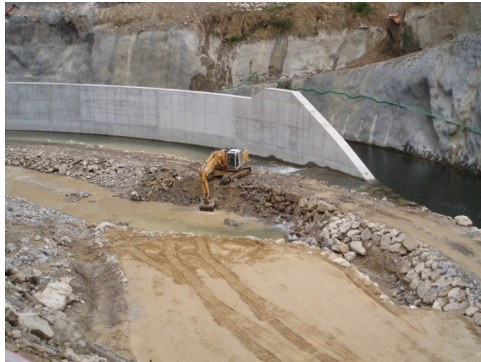
Figura 7 – Muro de desvio do rio
