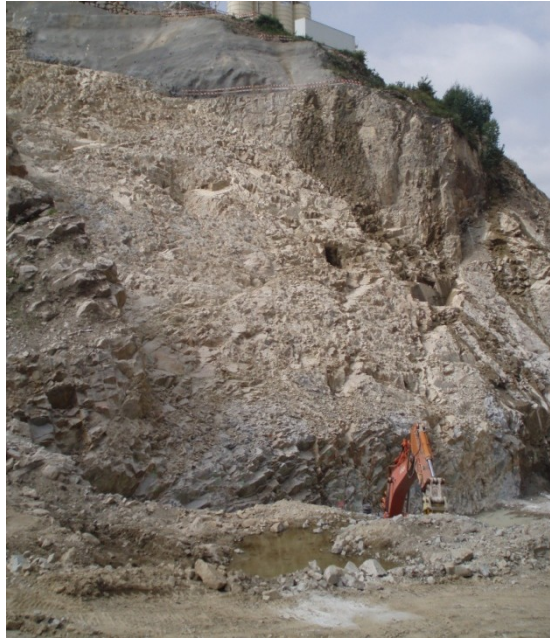
Figura 11 – Escavação da margem esquerda
