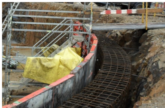
Figura 31 – Armaduras da viga de bordadura
