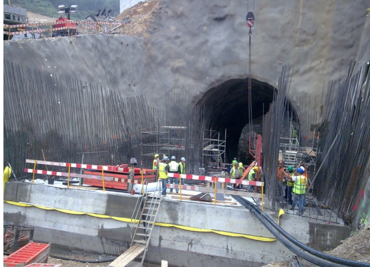
Figura 42 – Soleira em betão e armaduras das paredes
