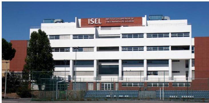
Figura 4.1. Edifício C do ISEL.
