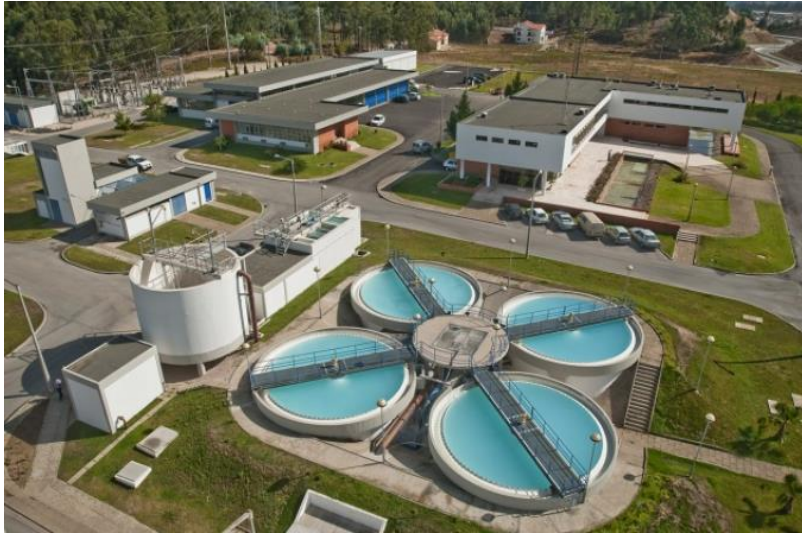
Figura 4.5. Fotografia aérea da ETA de Asseiceira.
