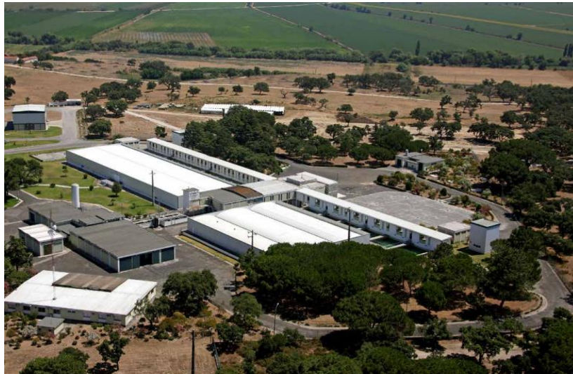
Figura 4.6. Fotografia aérea da ETA de Vale da Pedra.
