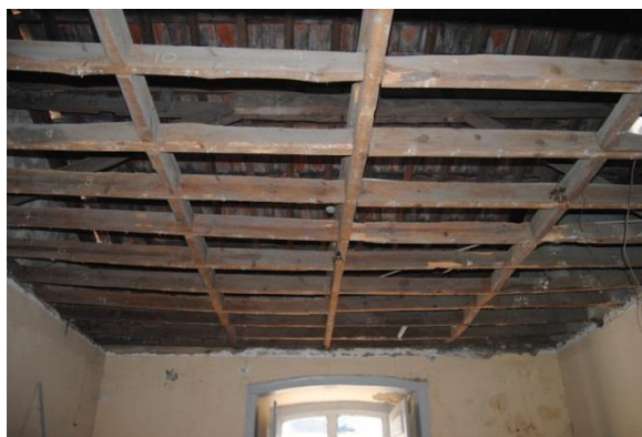
Figura 6.5- Zona a inspecionar
