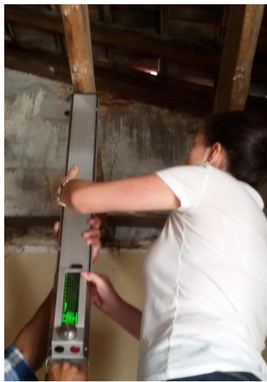
Figura 4.13- Utilização do Resistógrafo IML Resi em elementos horizontais
