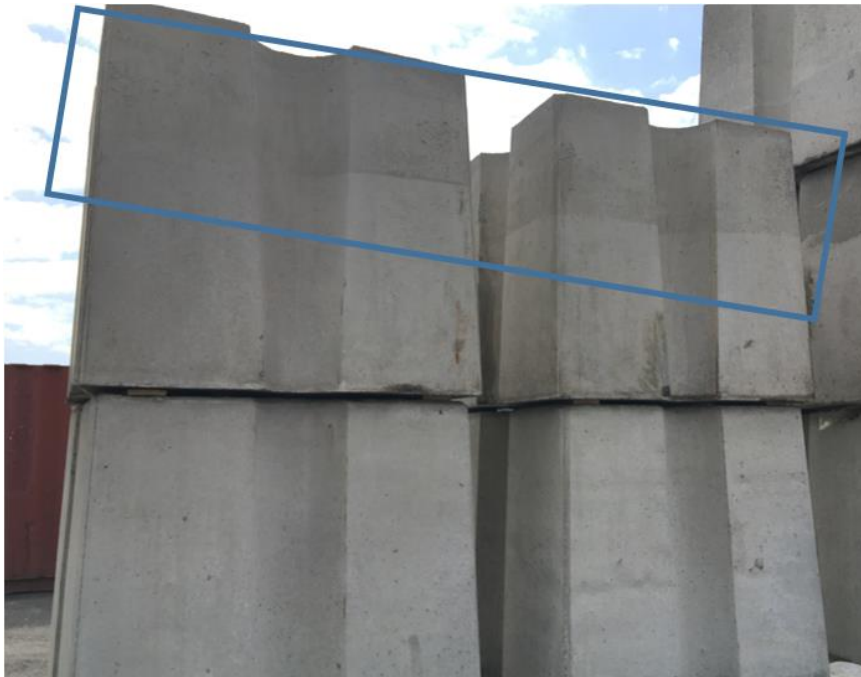
Figura 65: Antifer com juntas de betonagem
