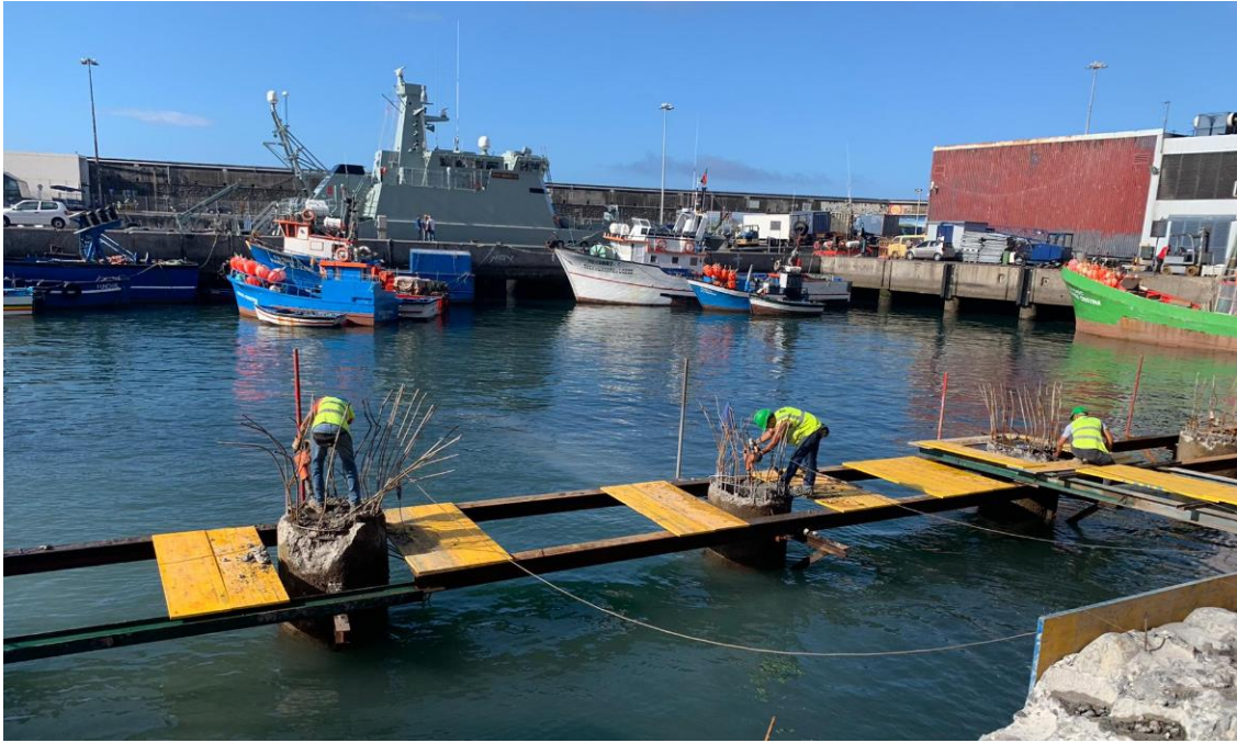
Figura 76: Demolição manual dos pilares até à cota pretendida
