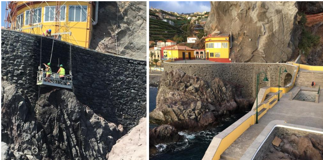
Figura 80: Trabalhos de preenchimento de juntas nos paramentos exteriores do cais da Ponta do Sol
