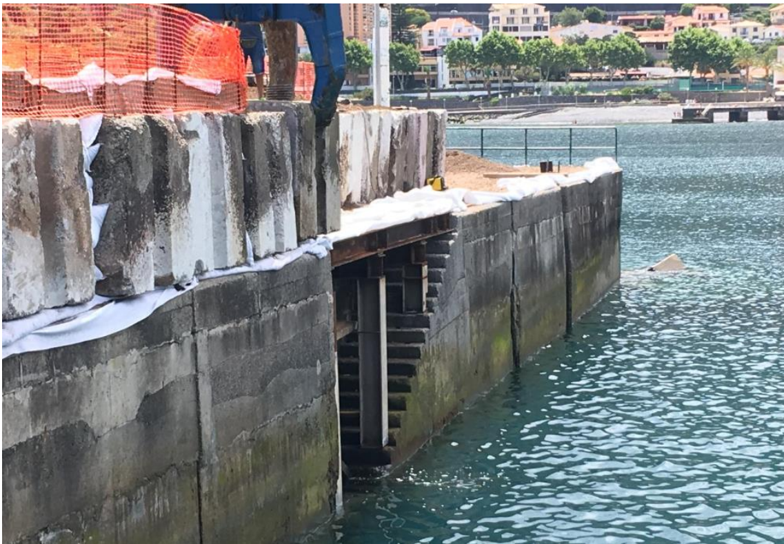
Figura 49: Estrutura metálica montada para permitir continuação da "pista de blocos"
