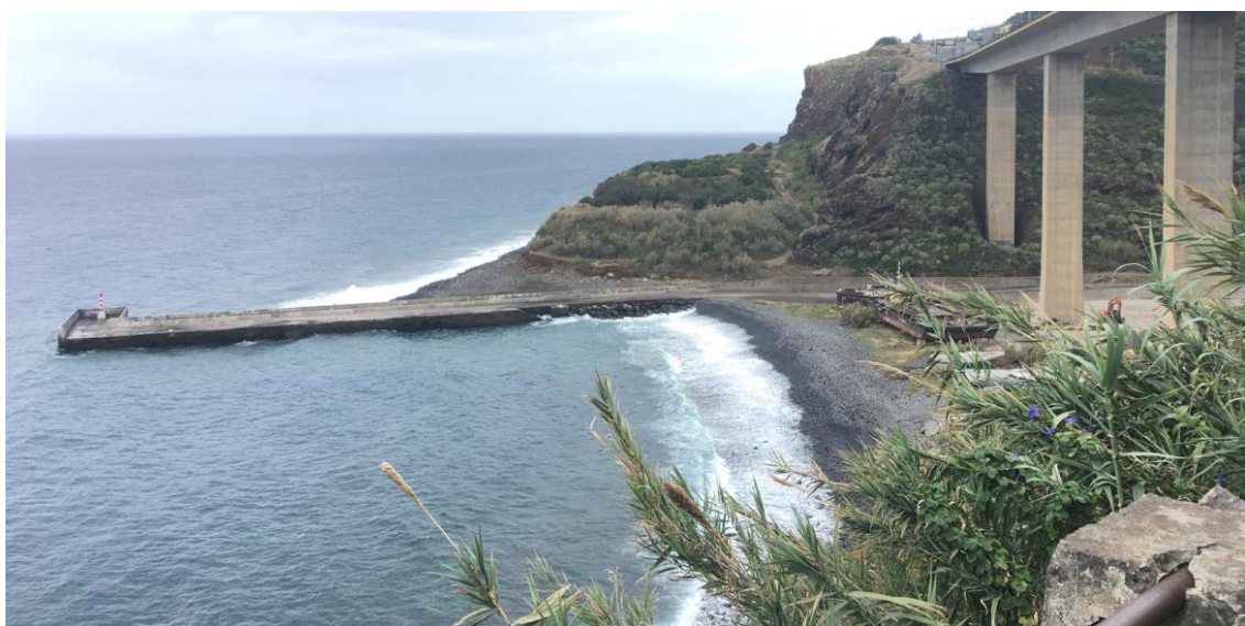
Figura 37: Fotografia do potencial estaleiro de pré-fabricação
