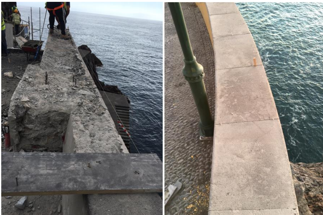
Figura 82: Colocação de cantarias
