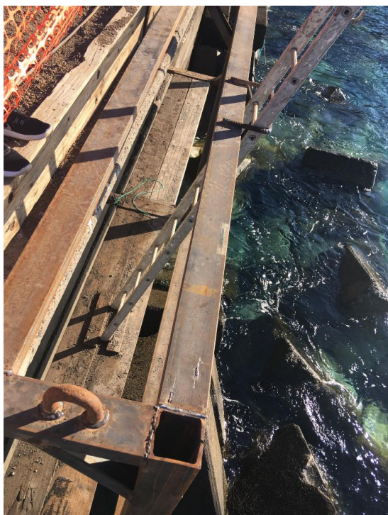
Figura 71: Bailéu montado no lado exposto do cais para reparação de armaduras e betão danificado
