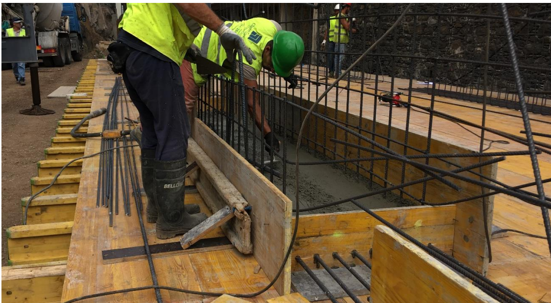
Figura 77: Trabalhos de execução de peças pré-fabricadas
