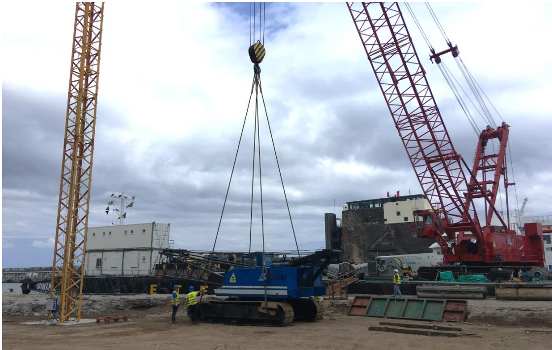
Figura 28: Descarga de grua sobre rastros desmontada que viria a dar apoio na Reabilitação da Lota do Funchal
