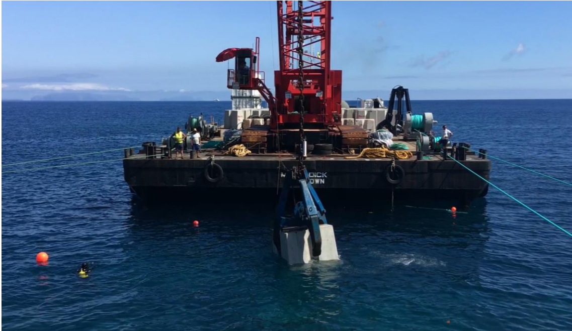
Figura 73: Trabalhos de colocação em zona submersa auxiliados por mergulhador
