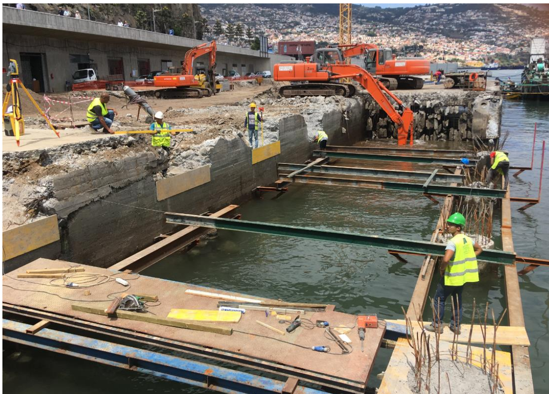
Figura 75: Sistema de "peleias" para manter estáveis os pilares do cais demolido
