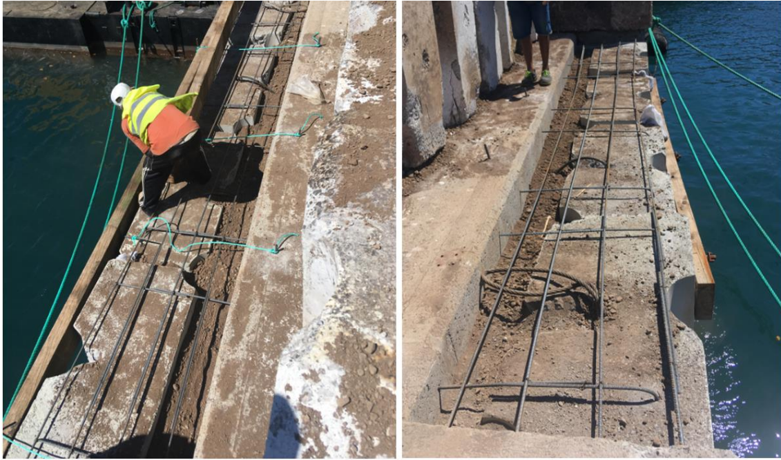
Figura 61: Processo construtivo no topo do preenchimento das escadas de precaução
