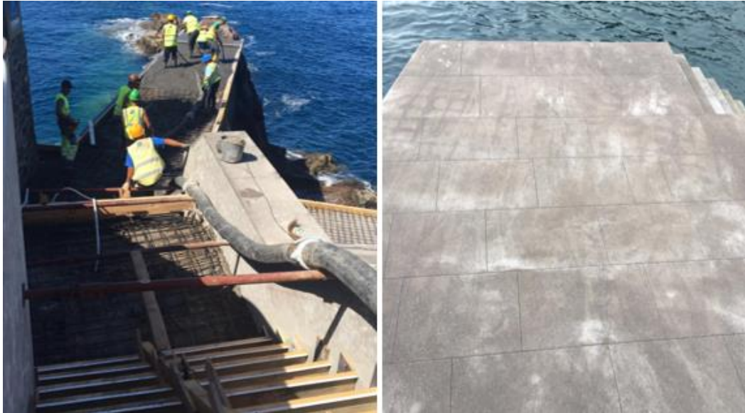
Figura 79: Trabalhos de pavimentação em betão armado com acabamento a imitar cantaria da região
