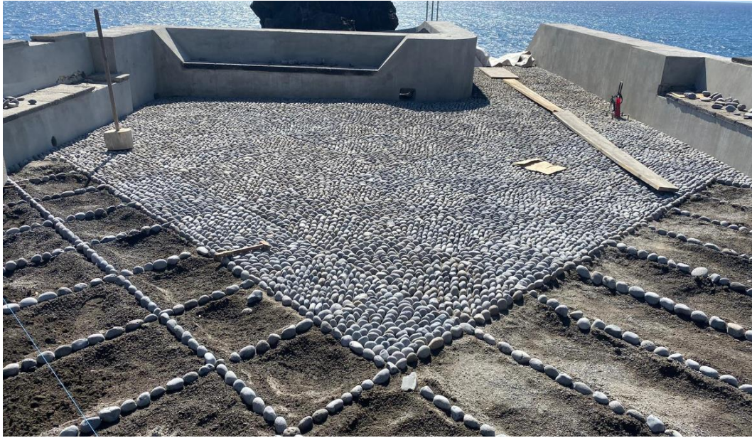
Figura 81: Pavimentação em calçada madeirense com estereotomia pretendida
