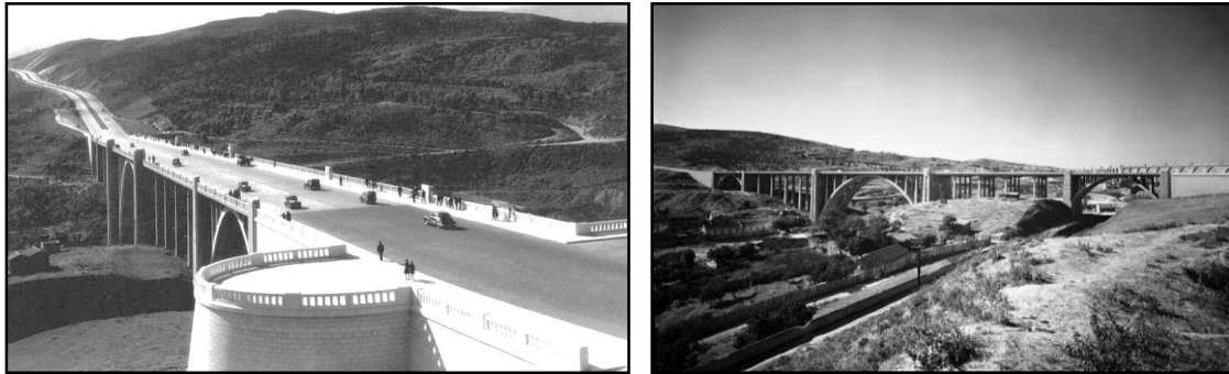
Figura 3.1 – Viaduto Duarte Pacheco (A5) [5]
