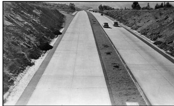
Figura 3.2 - Autoestrada Lisboa/Cascais com 2x2 vias (A5) [5]
