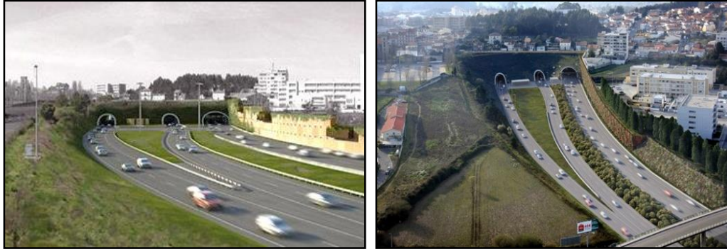
Figura 2.5 - Túnel de Águas Santas (A4) [2]
