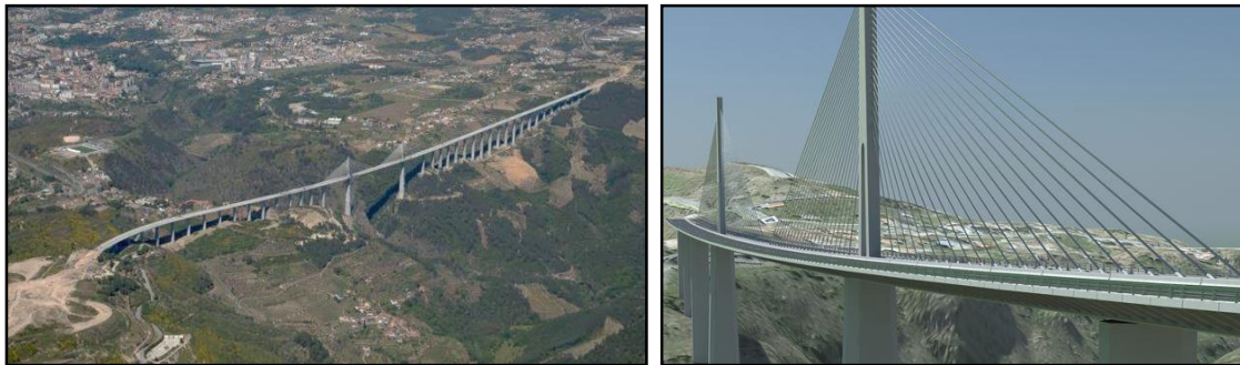
Figura 2.2 – Viaduto sobre o Vale do Rio Corgo (A4) [1]
