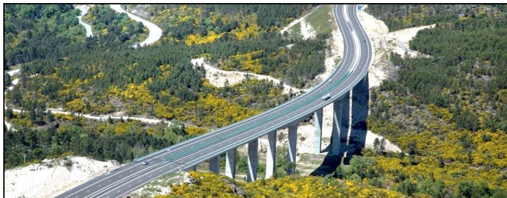
Figura 2.4 - Ponte sobre o rio Ceira [1]
