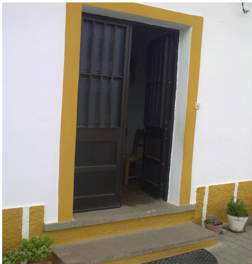
Ilustração 1 - Porta principal (fachada Sul)
