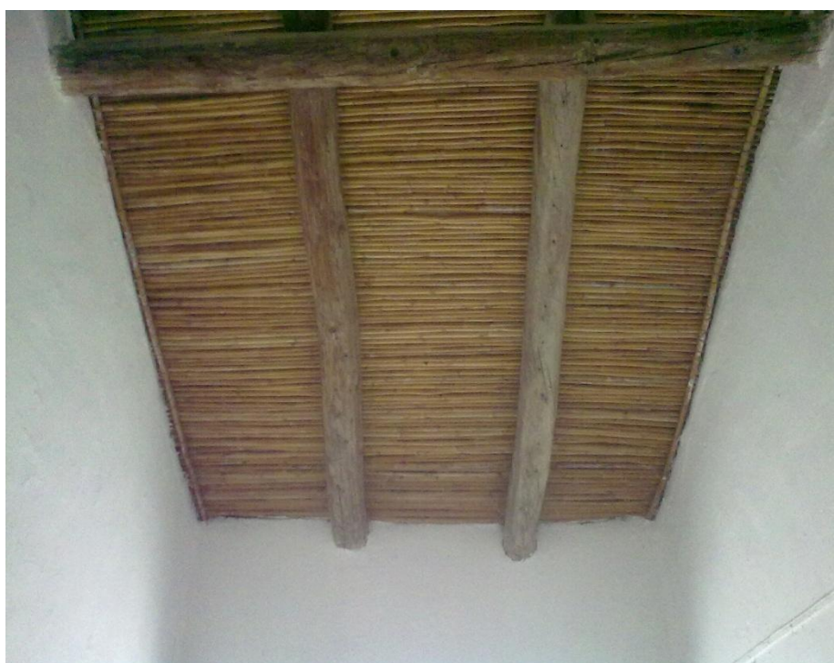
Ilustração 4 - Pormenor da cobertura em caniço (corredor)
