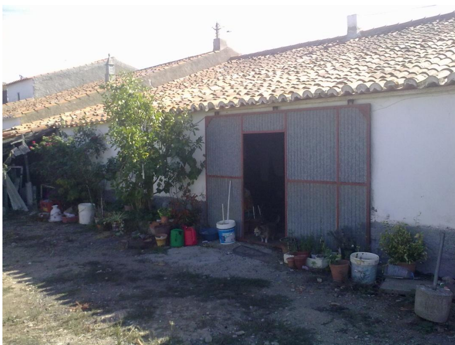
Ilustração 6 - Fachada Norte (porta de acesso ao quintal)
