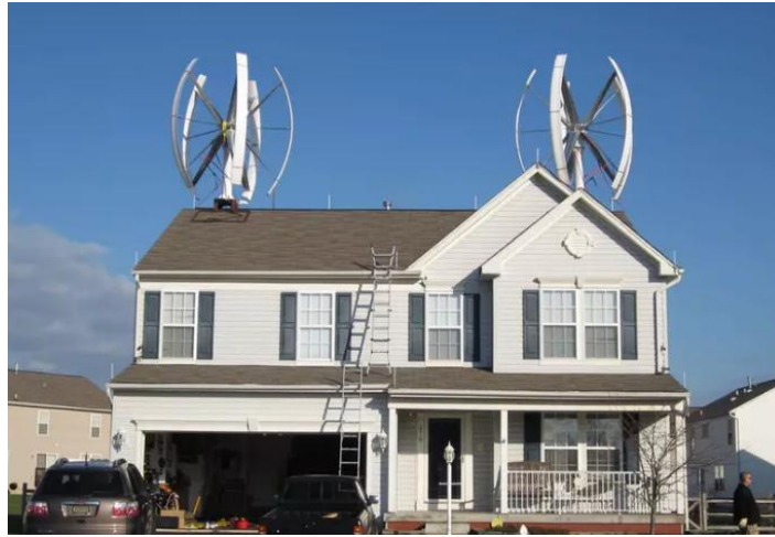
Figura 2.2-Instalação doméstica de turbinas VAWT (EN-5KW-H Vertical Axis Wind Turbine Generator VAWT, 2025)
