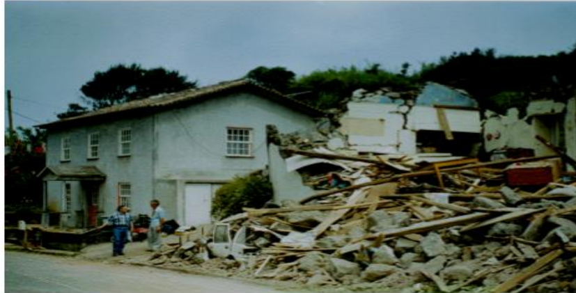
Figura 2.4 – Diferença de vulnerabilidade em edifícios - Sismo do Faial, 9 de Julho de 1998 - Fotografia de Jorge Rodrigues, 1998 in Sousa (2006)
