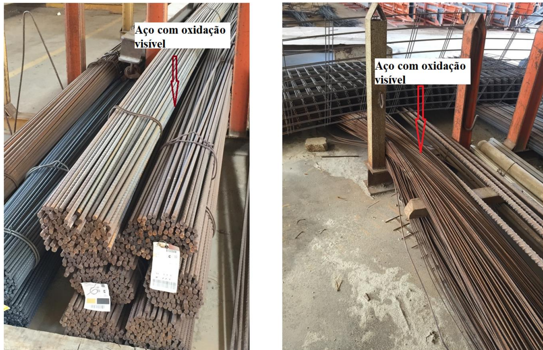
Figura 4.22 - Zona de armazenamento do aço com aço oxidado.
