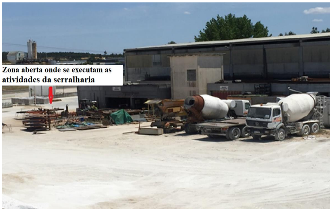
Figura 4.31 - Zona aberta da serralharia.
