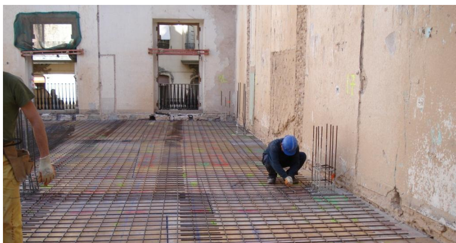
Figura 94 - Montagem da armadura passiva inferior [B6]
