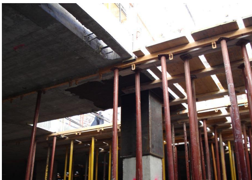
Figura 97 - Reforço ao punçoamento (revestimento do pilar com chapas metálicas) [B6]
