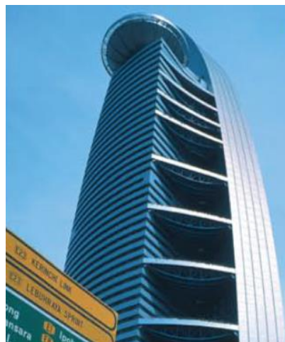
Figura 2 - Edifício de escritórios com lajes em betão armado pré-esforçado. Malaysia Telekom Tower em Kuala Lumpur [B1]
