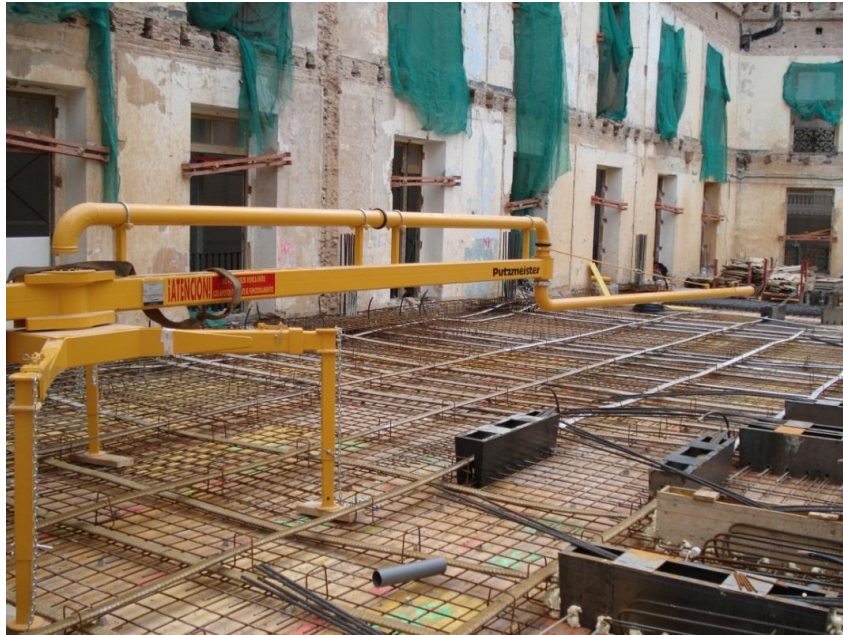
Figura 102 - Vista geral da montagem das bainhas [B6]
