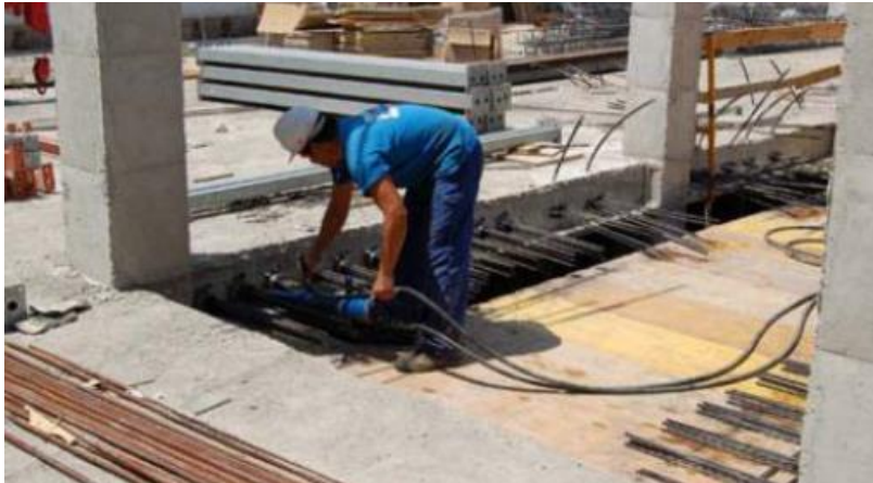
Figura 119 - Aplicação da força de pré-esforço em ancoragens com macaco monocordão [B6]
