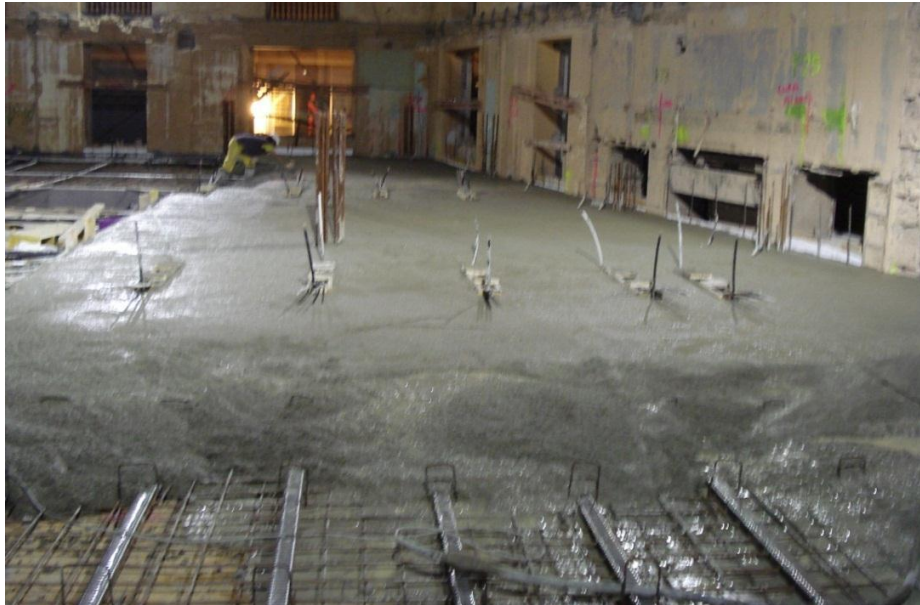
Figura 113 - Trabalhos durante a betonagem [B6]
