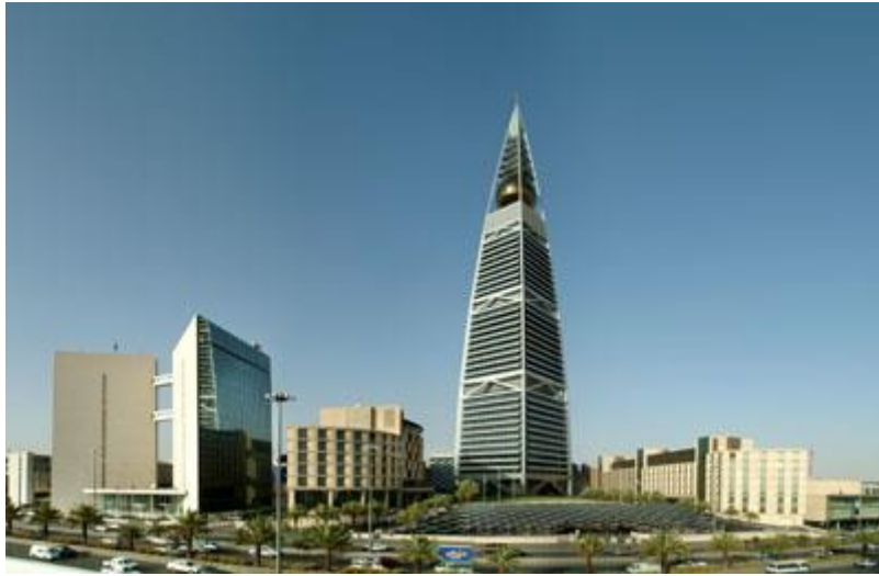
Figura 8 - Edifício Al Faisaliyah Center , Riade, Arábia Saudita [W5]
