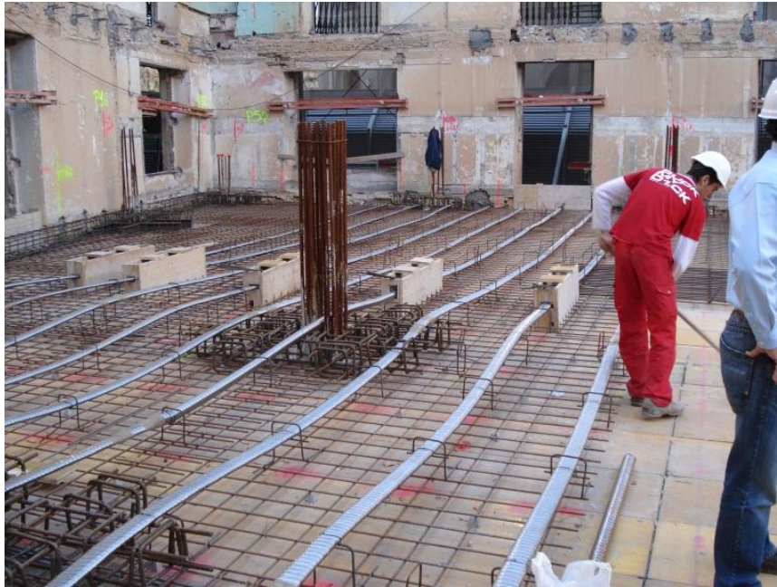
Figura 98 - Trabalhos de montagem das bainhas [B6]
