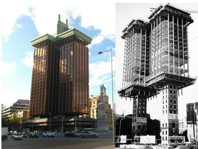
Figura 7 - Torres de Colón , Madrid, Espanha [W4]
