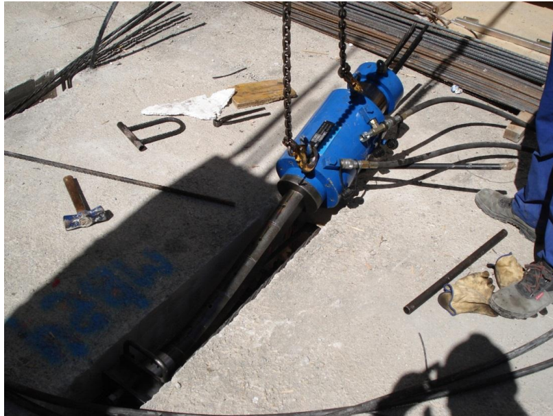
Figura 122 - Aplicação da força de pré-esforço com macaco hidráulico multicordão [B6]
