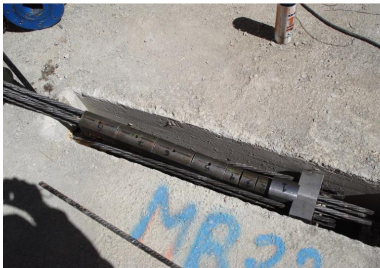
Figura 121 - Preparação de macaco hidráulico multicordão [B6]
