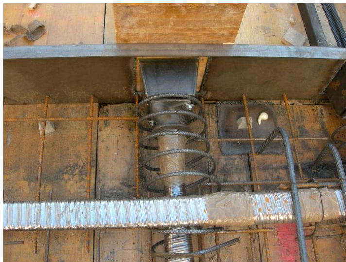
Figura 101 - Pormenor da selagem da bainha e ancoragem ativa [B6]
