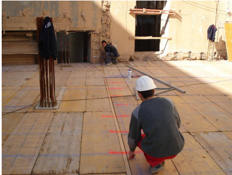
Figura 92 - Trabalhos de marcação dos alinhamentos dos cabos [B6]
