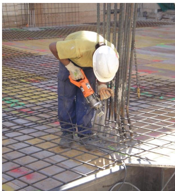
Figura 95 - Trabalhos com a armadura passiva inferior [B6]
