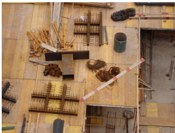
Figura 96 - Reforços ao punçoamento antes da sua instalação [B6]
