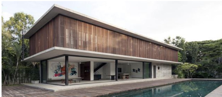
Figura 3 - Moradia unifamiliar com lajes em betão armado pré-esforçado [W1]
