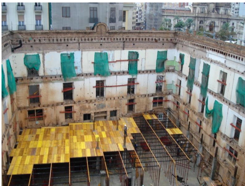
Figura 84 - Interior do edifício. Fachadas pré-existentes. [B6]
