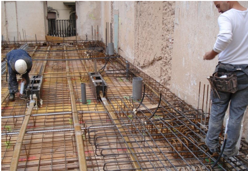
Figura 109 - Selagem e montagem da armadura superior [B6]
