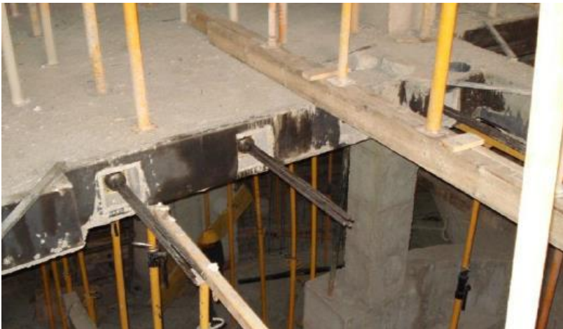
Figura 120 - Ancoragens após a aplicação da força de pré-esforço [B6]
