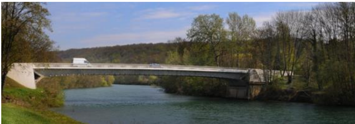
Figura 14 - Ponte sobre o rio Marne , em Luzancy, França [W11]
