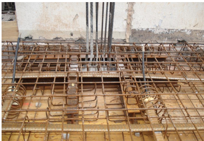
Figura 111 - Tubos de purga na extremidade das ancoragens passivas [B6]
