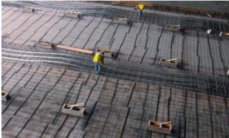
Figura 5 - Instalação dos cabos de pré-esforço numa laje [B1]
