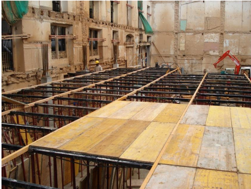
Figura 88 - Remate perimetral da cofragem [B6]
