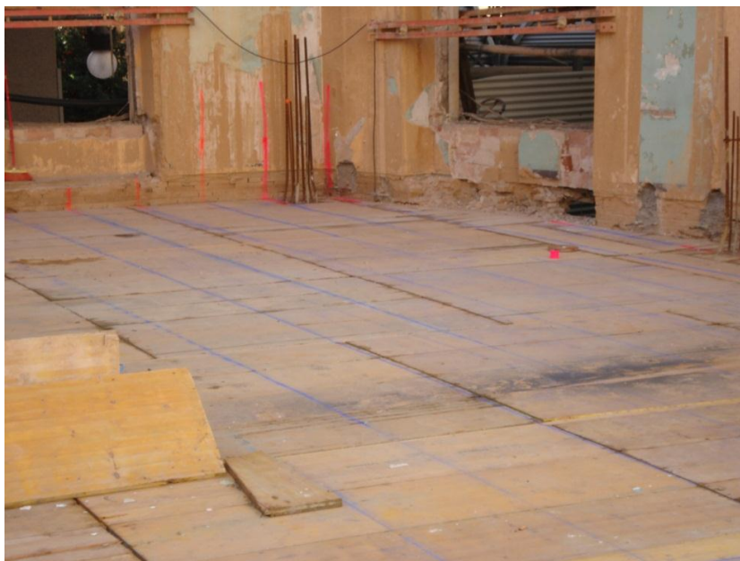
Figura 91 - Marcação dos alinhamentos dos cabos [B6]
