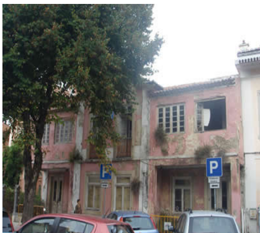
Figura 54: Foto fachada principal
