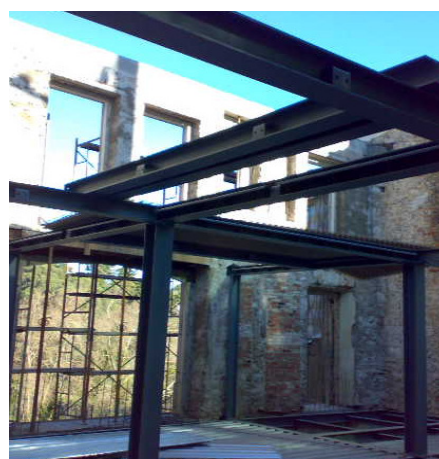
Figura 78: Estrutura metálica ao nível do tecto do rés-do-chão
