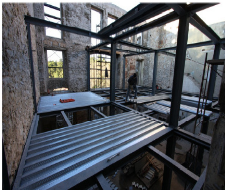
Figura 69: Estrutura metálica e pré-laje
