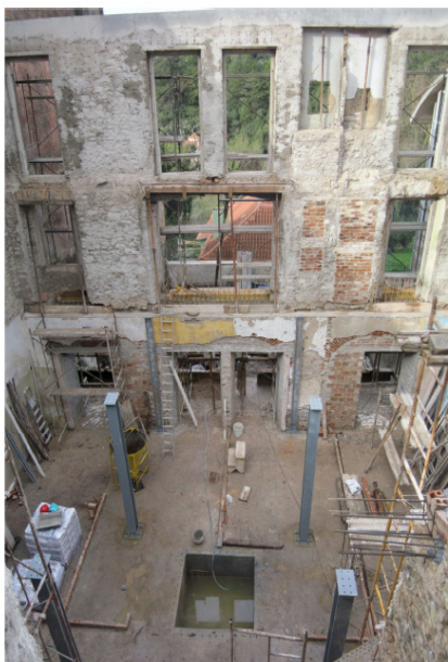
Figura 73: Colocação de pilares centrais metálicos
