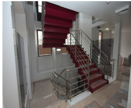
Figura 70: Escada de acesso em estrutura metálica - concluída
