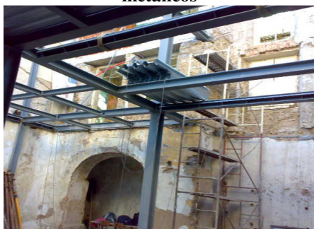
Figura 75: Estrutura metálica ao nível do tecto da cave
