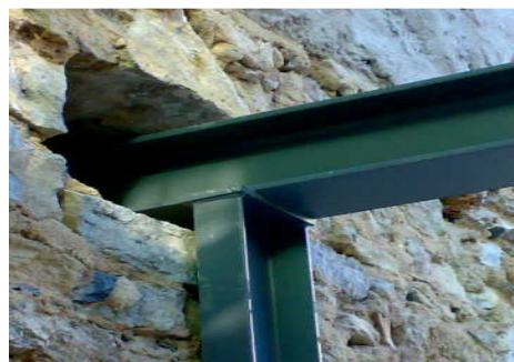
Figura 76: Pormenor de apoio da viga
