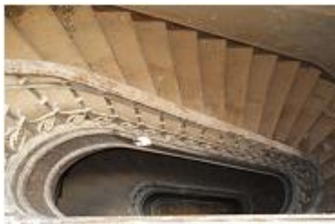
Figura 31- Escada interior [adaptado de ANDRADE]
