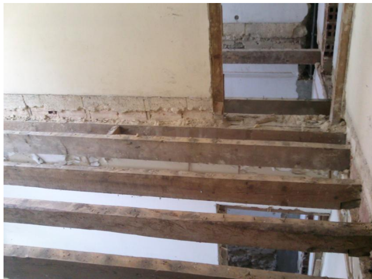
Figura 46- Remoção dos vigamentos do piso
