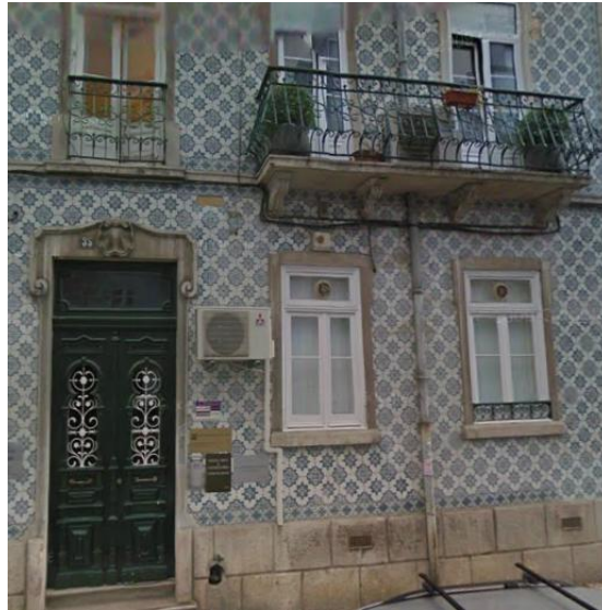
Figura 25- Pormenor das janelas e guardas
