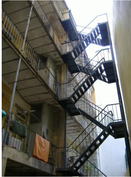
Figura 33 – Escada de serviço
