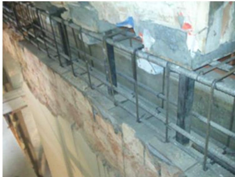
Figura 53- Viga armada no interior da caixa da parede
