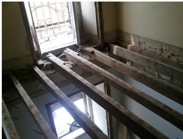
Figura 40- Vigamentos do pavimento
