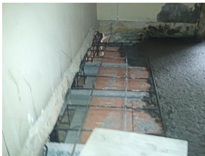
Figura 56- Betonagem da laje
