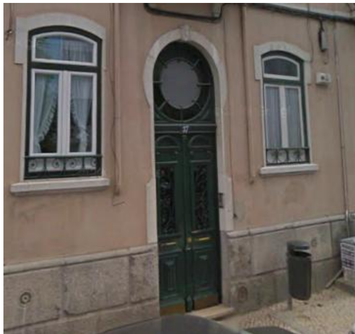
Figura 24- Porta de edifício Gaioleiro
