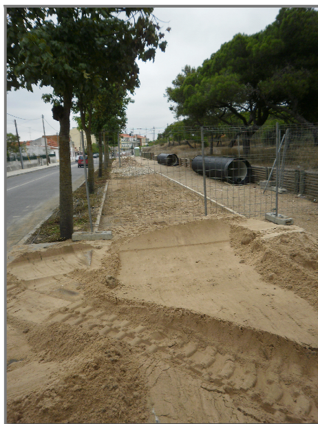
Figura 4.5 - Acondicionamento de tubagem ao longo do traçado
