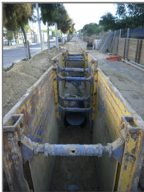
Figura 4.9 - Tubagem PPC 1000mm com vista de embocadura para montante.
