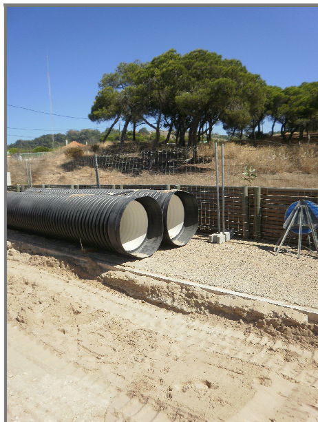
Figura 4.8 - Embocadura de tubagem PPC
