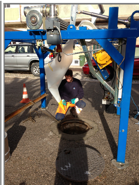
Figura 3.7 - Fixação do cabo do guincho ao filme de polietileno.
