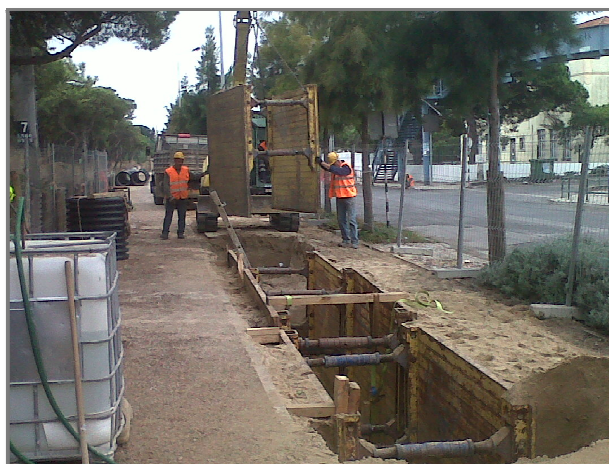
Figura 4.3 - Colocação de entivação em vala
