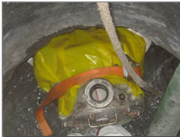
Figura 3.10 - Cabeçote instalado e manga pronta para insuflar.
