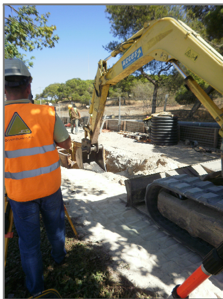
Figura 4.2 - Escavação de vala com recurso a escavadora giratória
