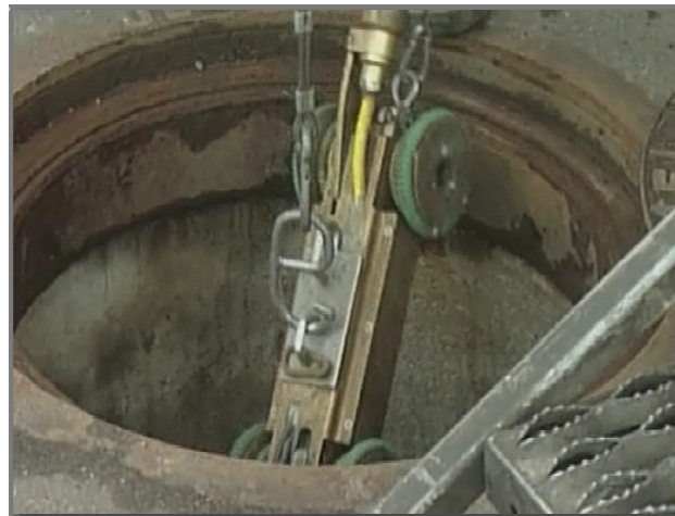
Figura 3.19 - Inserção de equipamento CCTV em caixa de visita
