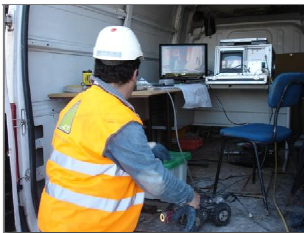
Figura 3.2 - Veículo de inspeção vídeo
