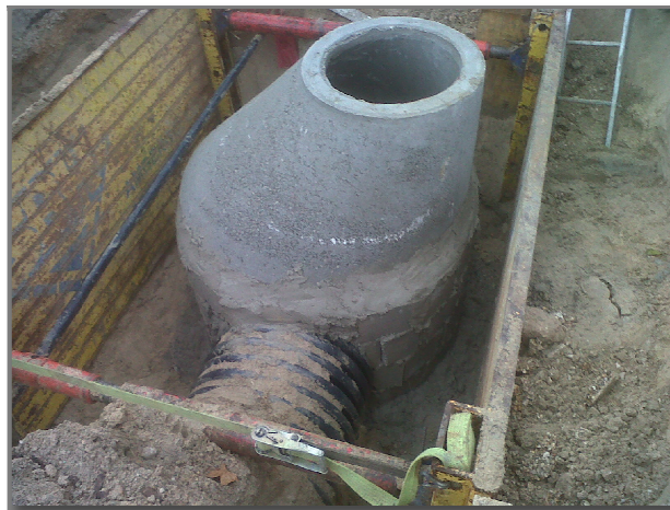
Figura 4.10 - Caixa de visita em execução.
