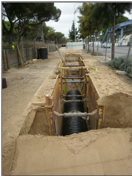
Figura 4.7 - Tubagem PPC 1000mm instalada em vala
