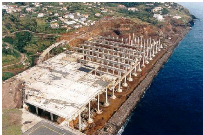
Figura 4.1 – Construção do prolongamento da laje do Aeroporto da Madeira [weblog.com.pt, 2009].
