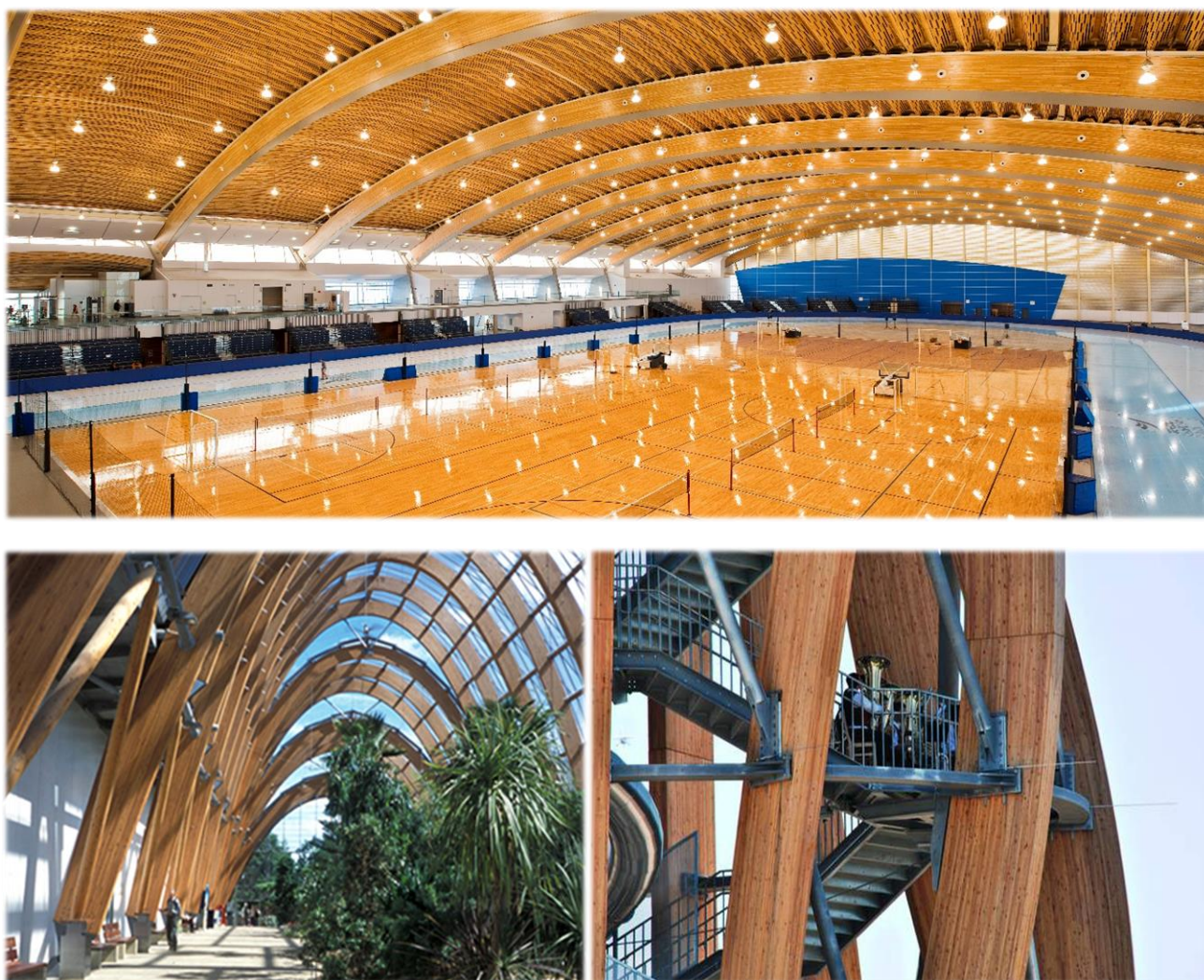
Figura 4.4 – Em cima: Cobertura da arena Richmond Olympic Oval , Canadá, com arcos em MLC e aço [37]; em baixo: Estufa Sheffield Winter Gardens , Reino Unido, com arcos em MLC (esquerda); Torre de observação Pyramidenkogel , Áustria, com pilares em MLC (direita)
