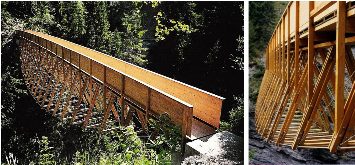
Figura 2.4 – Ponte Traversina, Suíça, por Jürg Conzett, 1996
