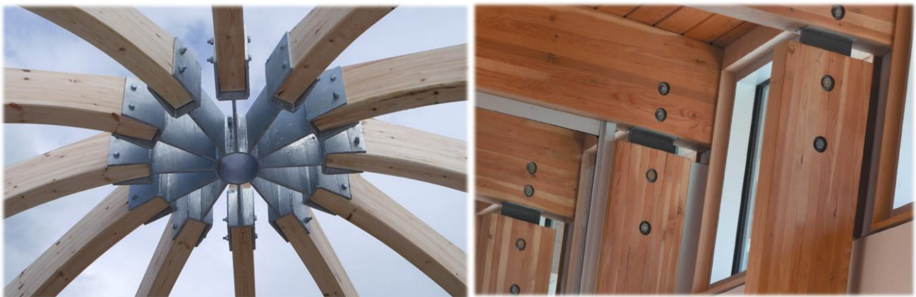
Figura 4.16 – Sistemas de ligação e aço entre dois ou mais elementos de madeira
