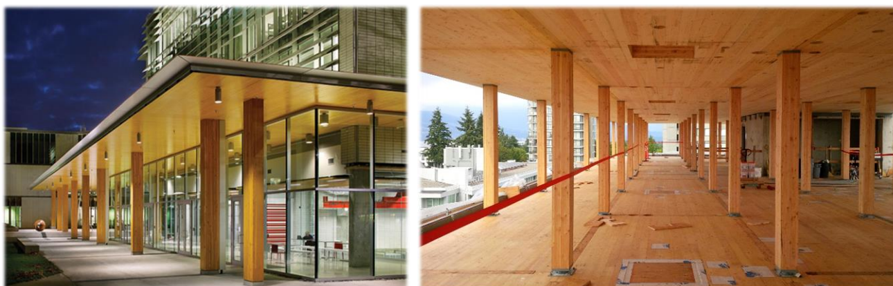
Figura 4.10 – CLT e pilares em MLC evidenciados no alpendre e interior do Earth Sciences Building , UBC , Canadá
