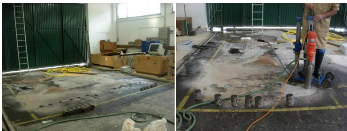
Figura 5.8 – Carotagem dos provetes cilíndricos na fossa
