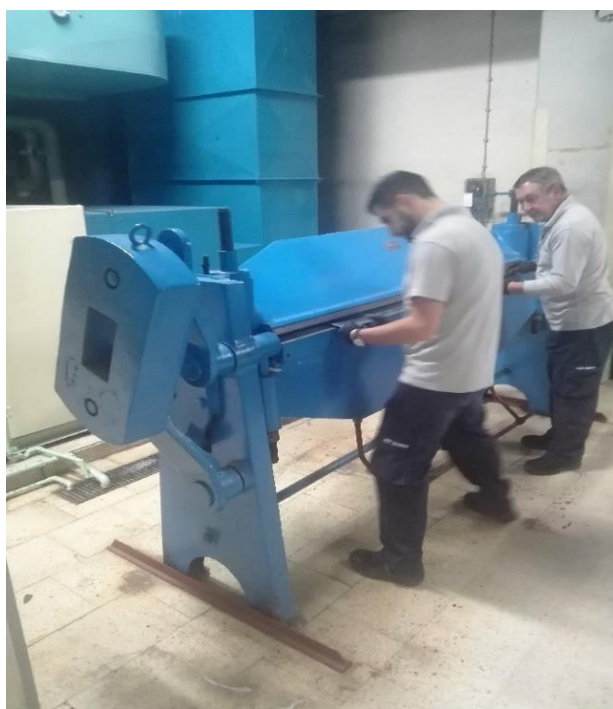
Figura 4.6 - Quinagem da chapa galvanizada.
