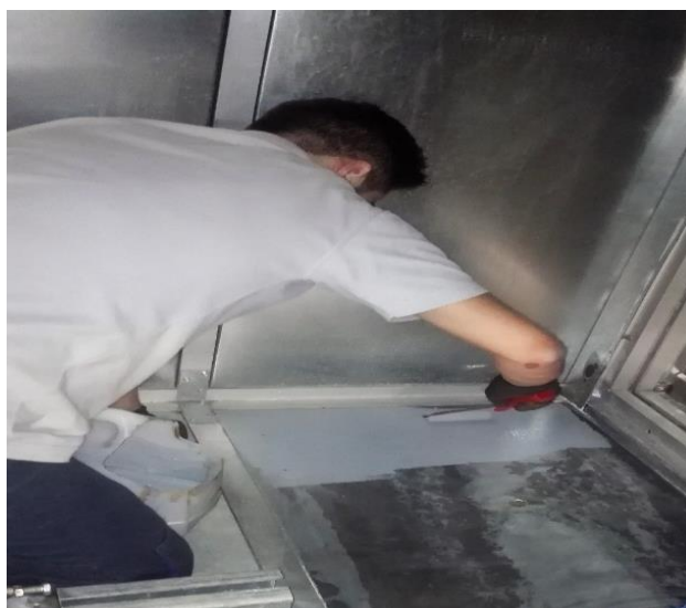
Figura 4.5 - Pintura tabuleiro de condensados.
