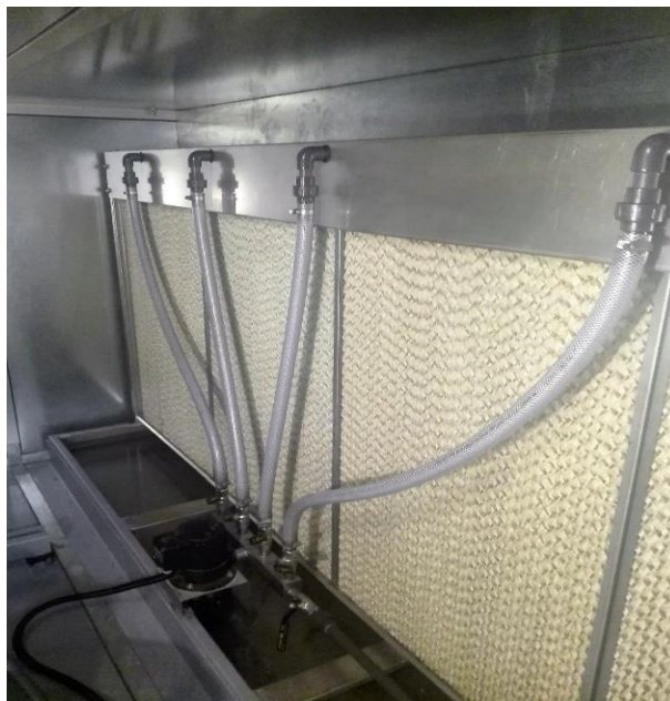
Figura 4.8 - Final do trabalho de manutenção.
