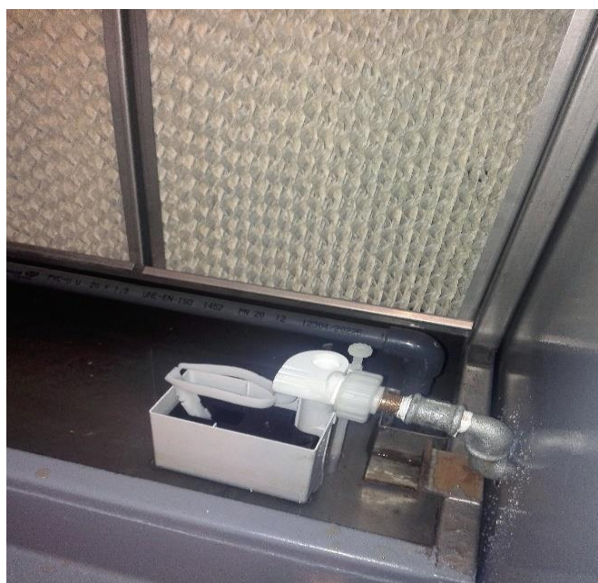
Figura 4.7 - Substituição do boiador.
